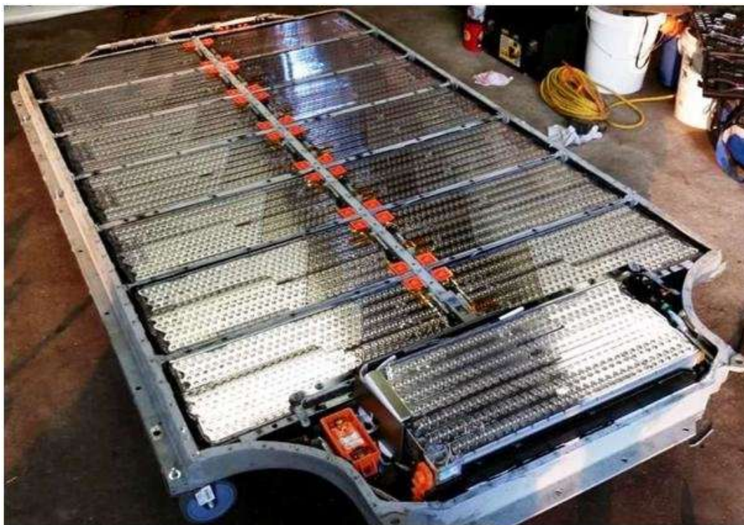
Obrázek 7: Velkokapacitní baterie automobilky Tesla [14], připojené jednotlivé bateriové moduly
