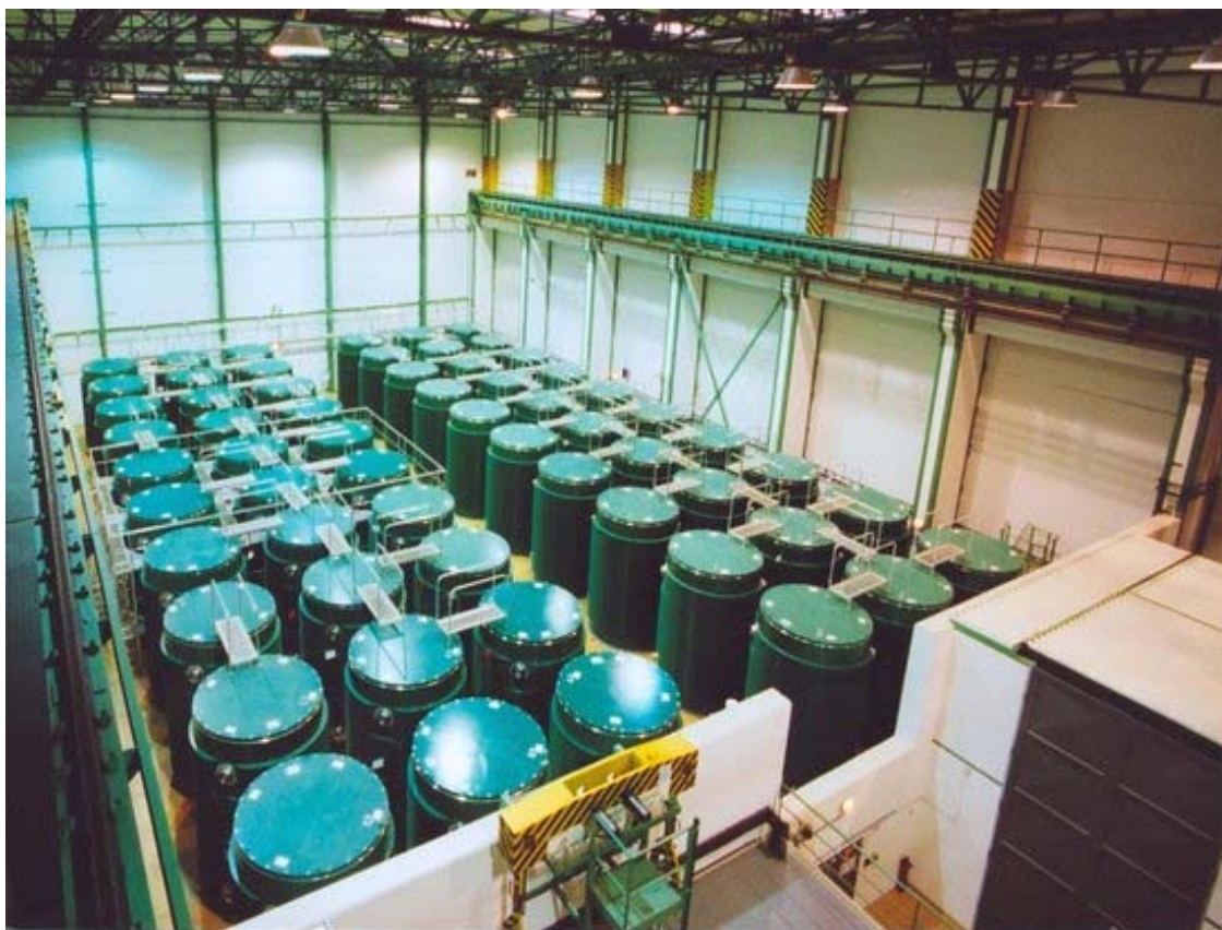
Obrázek 2 - mezisklad VJP v Dukovanech [8]
