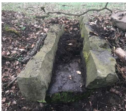
Obrázek 11 Dochovaný bezpečnostní přeliv; foto 18.4.2021, řez přelivem
