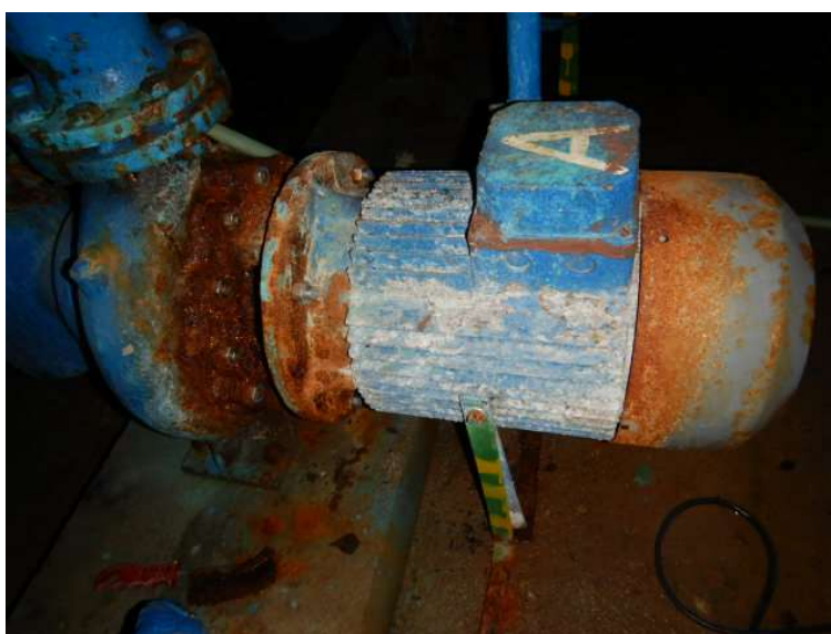
Obrázek 21 Stav čerpadla před rekonstrukcí [31]
