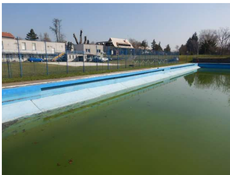
Obrázek 16 Pohled na přelivné žlábký plovárny před rekonstrukcí [31]
