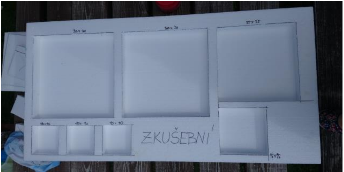
Obr. č. 17 – fotografie bednění pro zkušební vzorky
