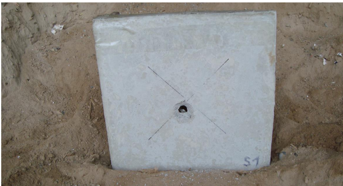
Obr. – přední strana vzorku S1 na střešnici
