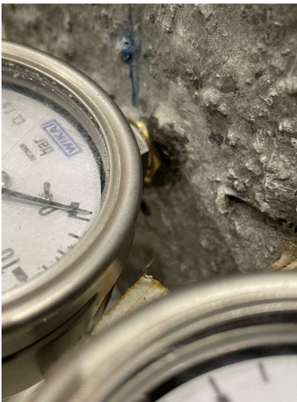
obr. 29: Únik kapaliny vrt 6 mm – fitink
