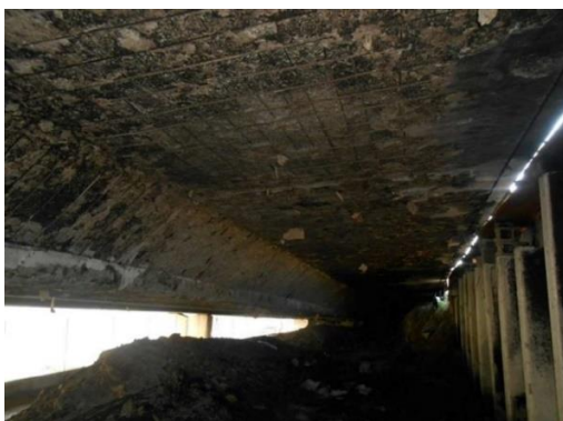
obr. 4: Příklady poškození mostních konstrukcí zasažených požárem [7, 13, 15, 16]
