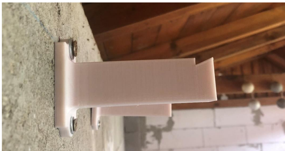
Obrázek 55 Uchycení vetknutého nosníku do kompaktního betonu
