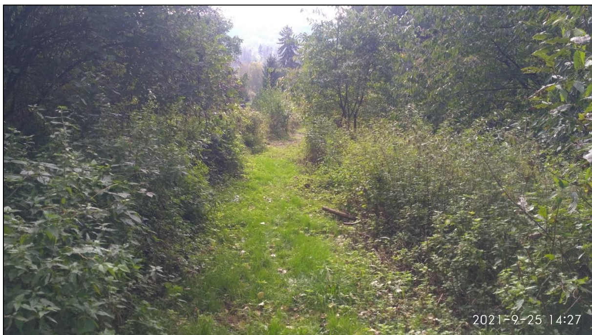
Obr. 67 Stávající stav tělesa trati přibližně v km 2,150 000, foto: autor
