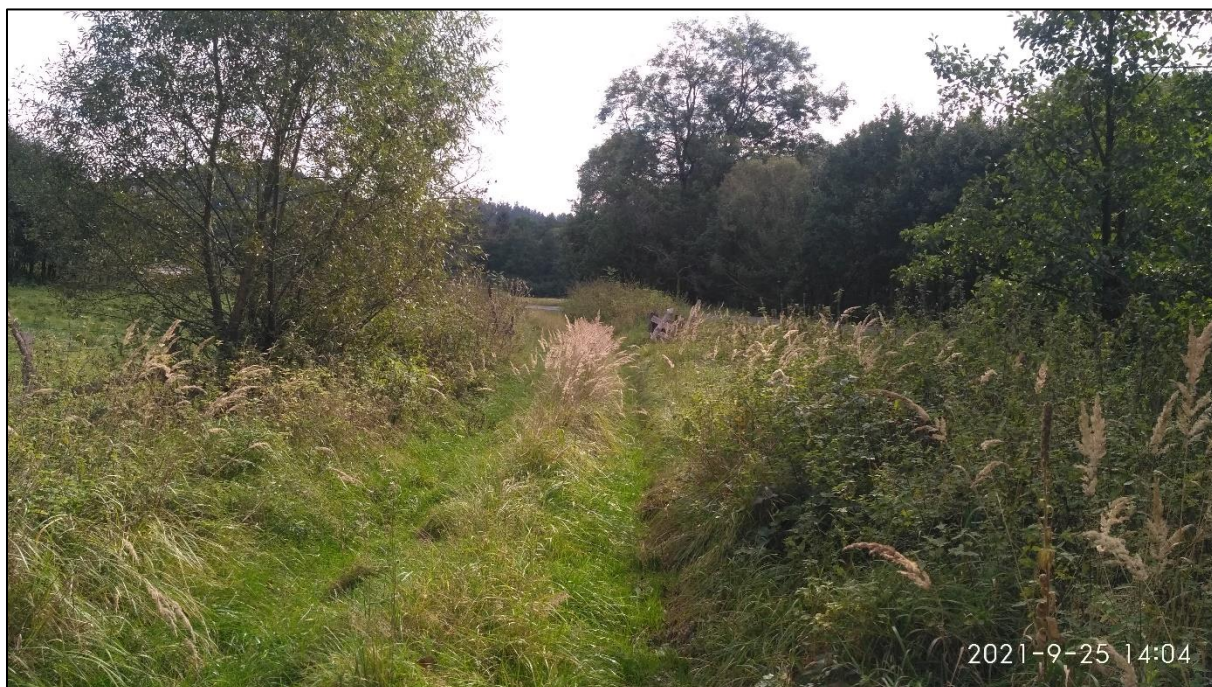
Obr. 60 Stávající stav tělesa trati přibližně v km 1,550 000, foto: autor
