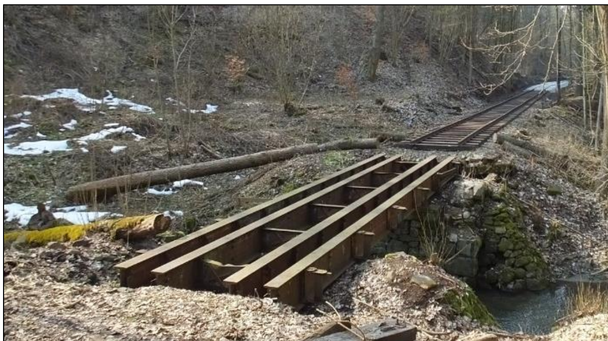
Obr. 37 Obdobná nosná konstrukce, použitá v úseku Zubrnice – Lovečkovice, km 8,025 000, foto: ZMŽ [7]
