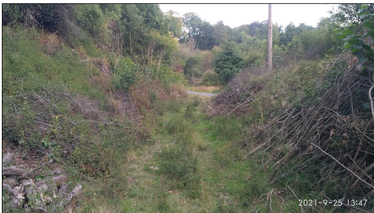
Obr. 50 Stávající stav tělesa trati přibližně v km 0,700 000, foto: autor
