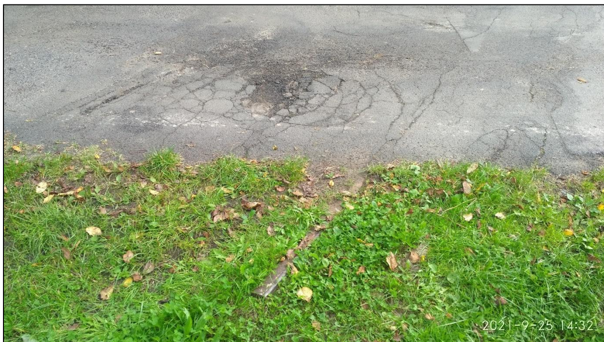
Obr. 70 Původní kolejnicové pasy v přejezdu v km 2,333 408, foto: autor
