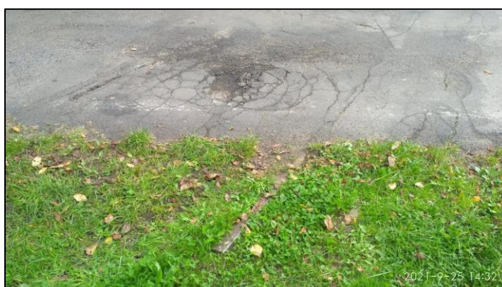
Obr. 33 Nález kolejnic v přejezdu v km 2,460 291
