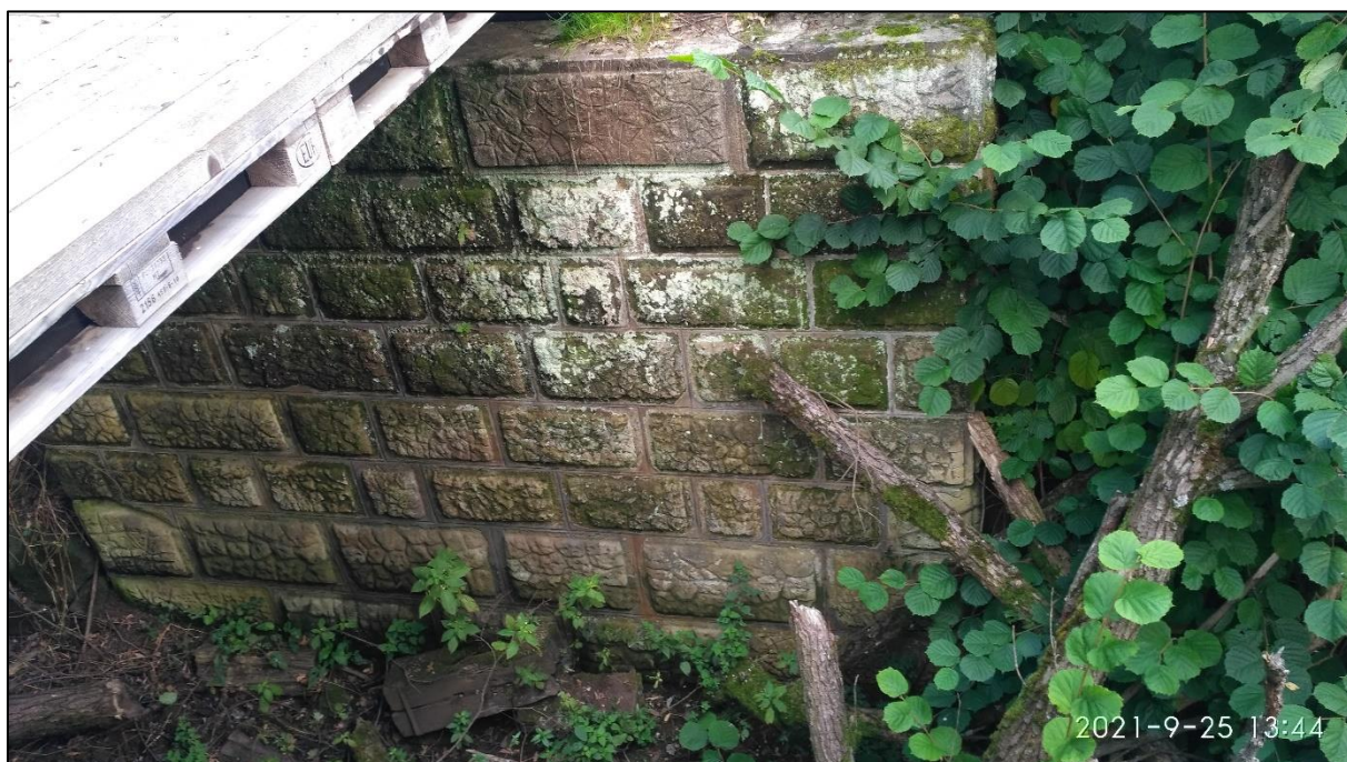
Obr. 47 Stávající stav opěry mostu na Levínské straně potoka v km 0,599 057, na fotografii je patrný velmi dobrý stav zděné opěry, foto: autor
