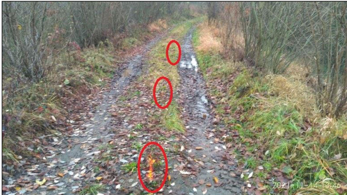
Obr. 30 Ověření správnosti směrového řešení v terénu – v červených elipsách je patrná projektovaná osa koleje vyznačená autorem pomocí spreje, foto: autor
