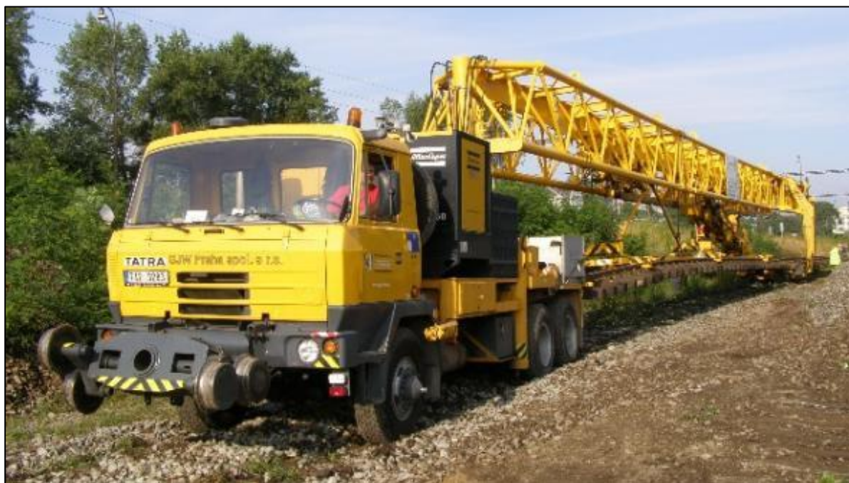
Obr. 3 PKP 25/20i, při trhání kolejových polí, foto: GJW Praha [2]
