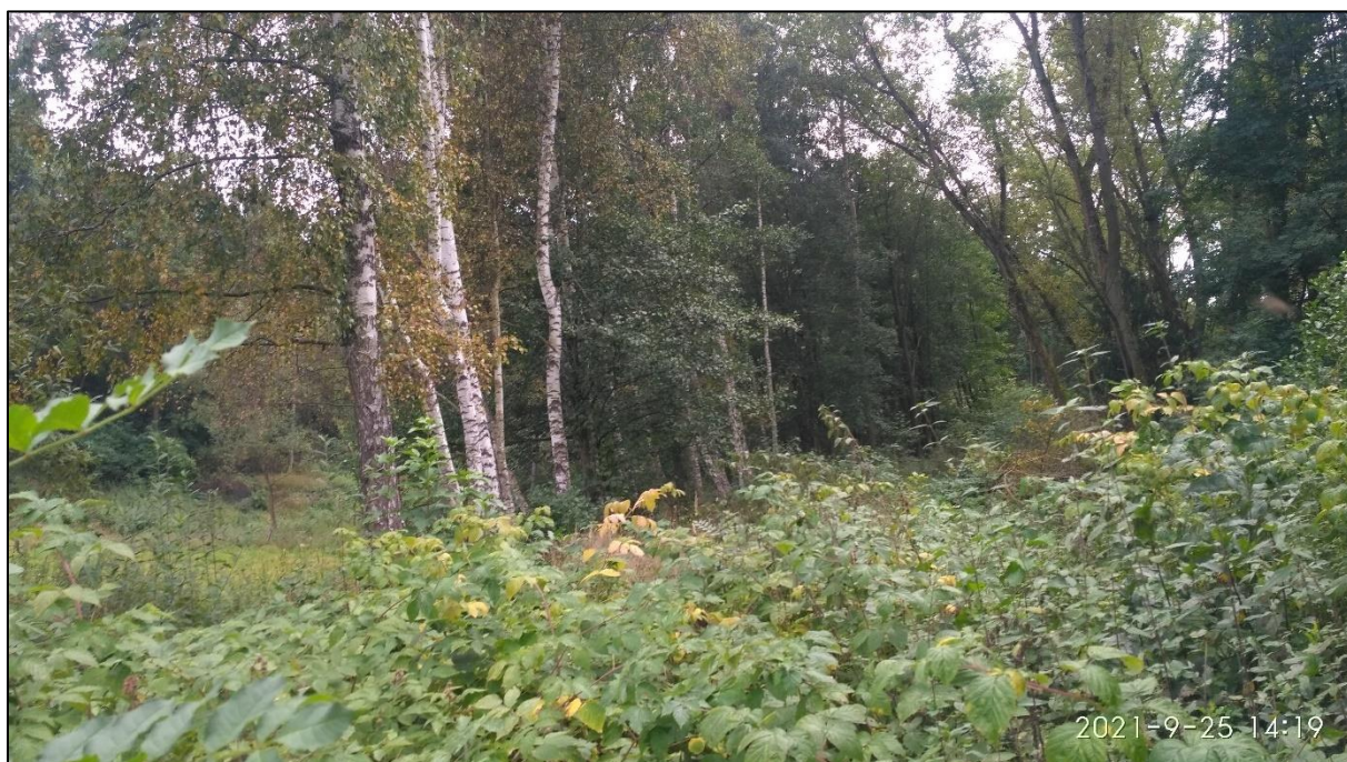
Obr. 65 Stávající stav tělesa trati přibližně v km 2,000 000, foto: autor
