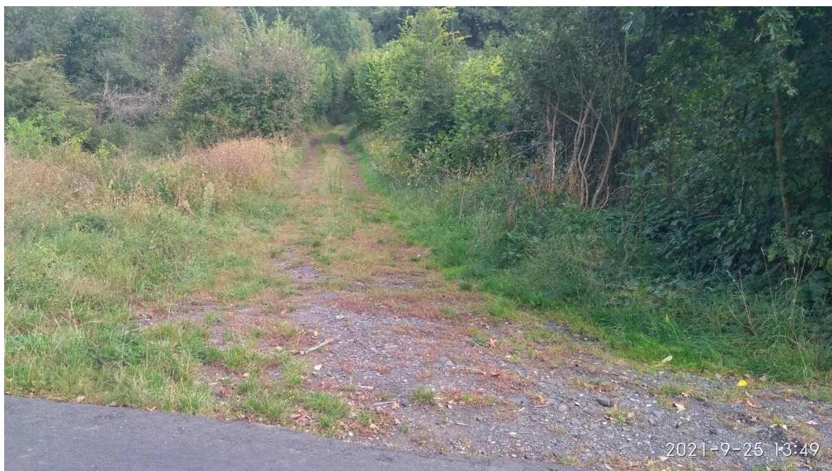
Obr. 53 Pokračování stávající tělesa trati za přejezdem v km 0,726 488, foto autor
