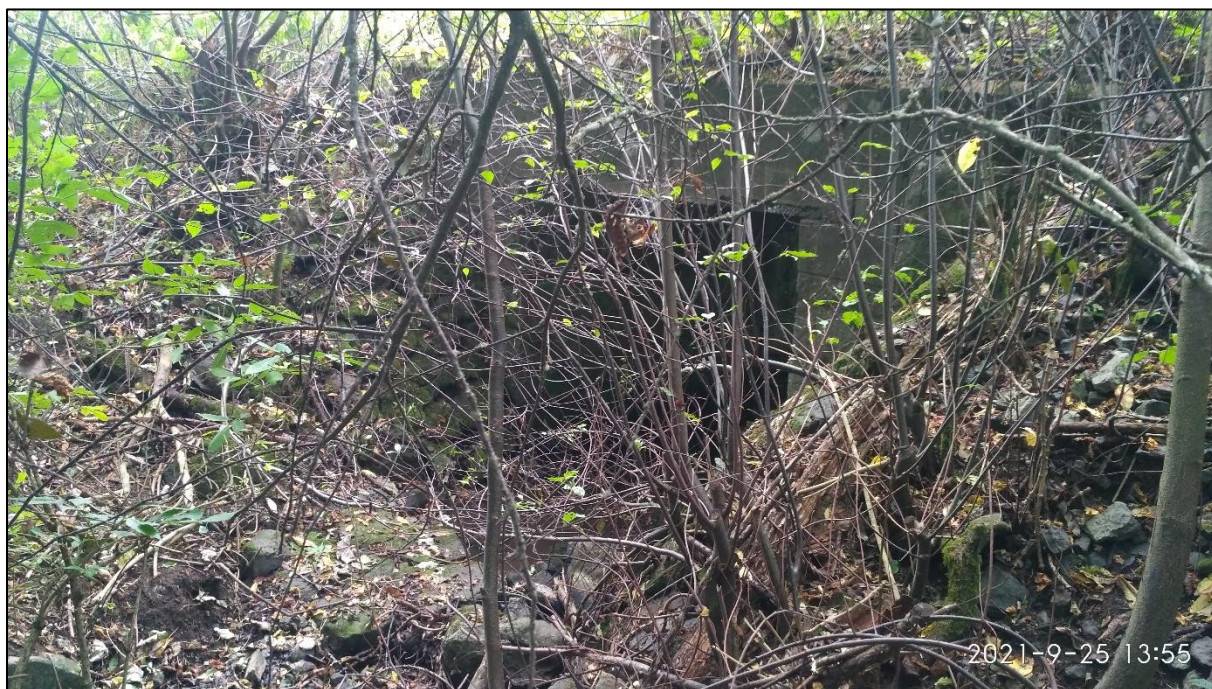
Obr. 56 Stávající stav propustku v km 0,914 965, foto: autor
