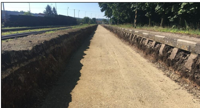
Obr. 6 Zřízená a zhutněná konstrukční vrstva žel. spodku, foto: SAŽEV-REKO [4]
