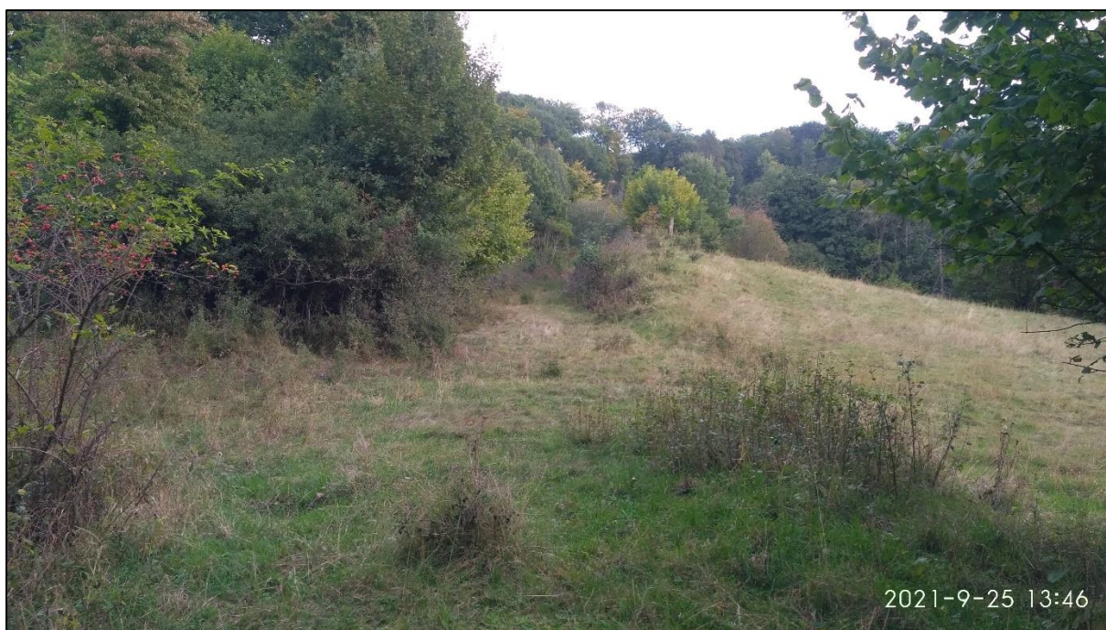
Obr. 49 Stávající stav tělesa trati přibližně v km 0,630 000, foto: autor
