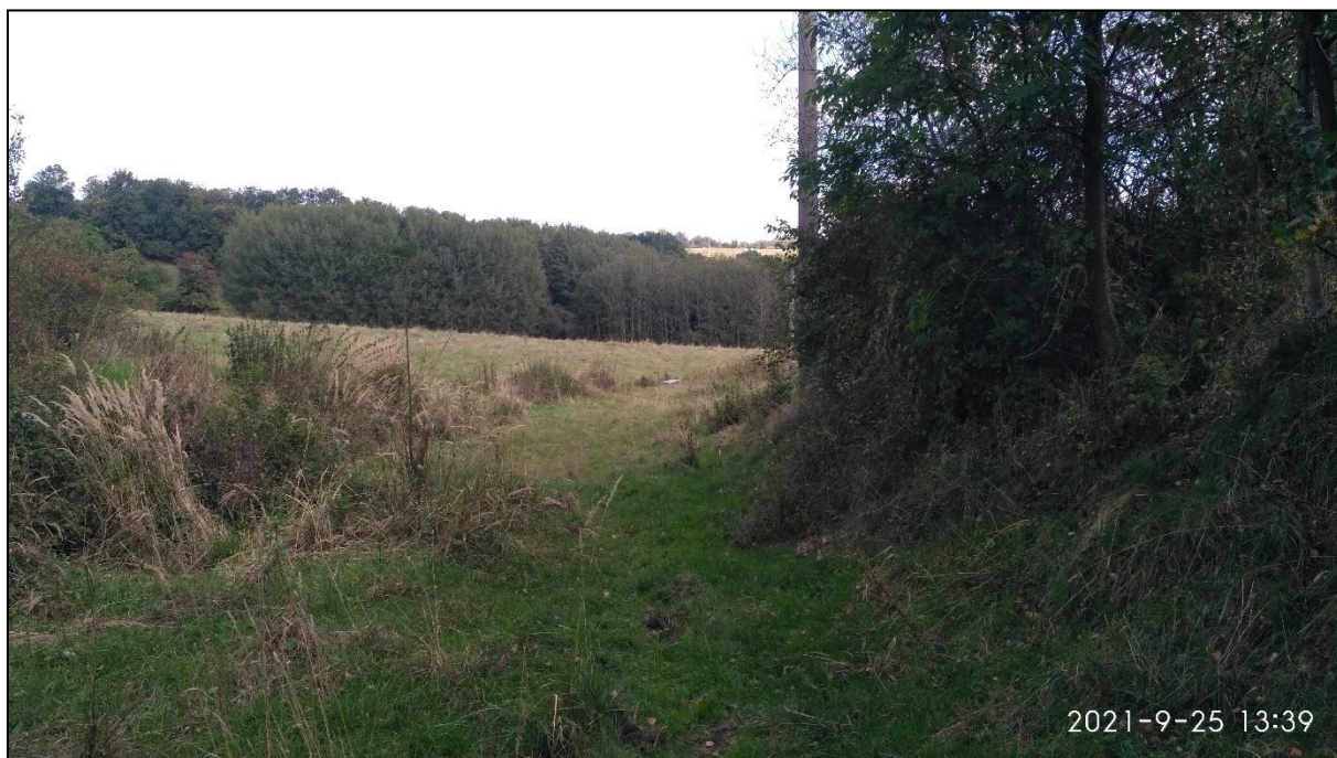
Obr. 42 Stávající stav tělesa trati přibližně v km 0,350 000, foto: autor
