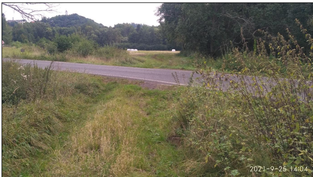
Obr. 61 Stávající stav tělesa trati v místě budoucího železničního přejezdu v km 1,603 640, foto: autor
