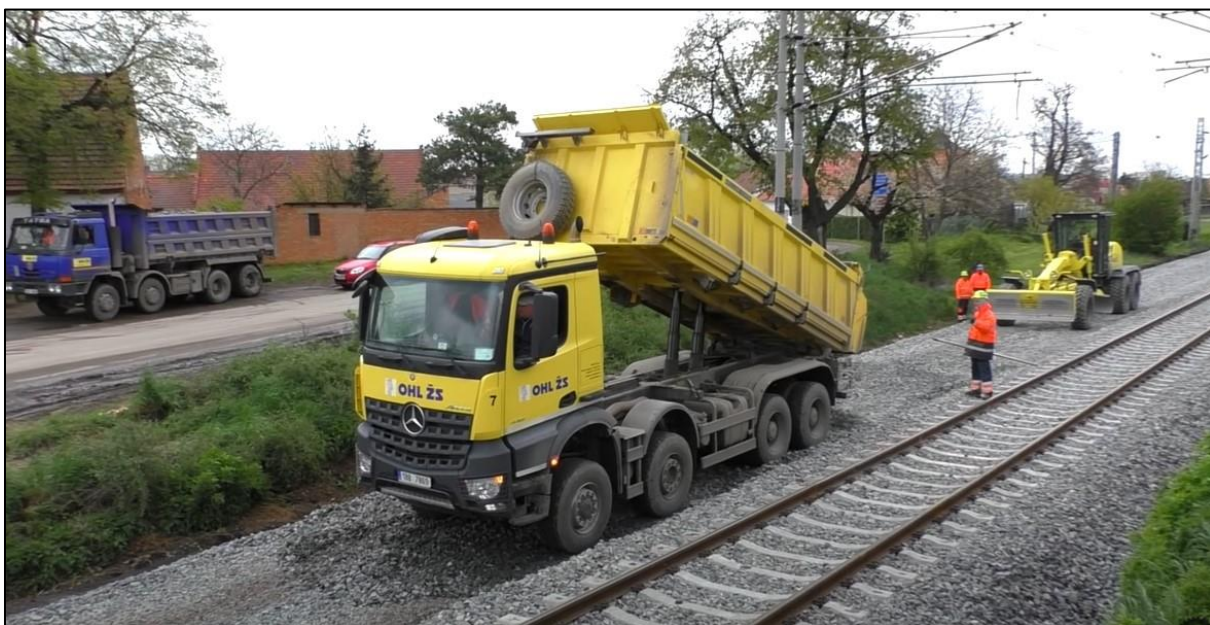
Obr. 18 Čtyřnápravový sklápěč doplňuje materiál při finálním urovnání grejdrem, foto: autor
