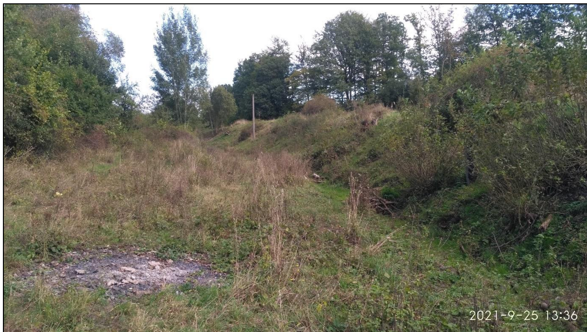
Obr. 40 Stávající stav tělesa trati přibližně v km 0,100 000, na fotografii je patrná větev do Verneřic (vlevo) a řešený úsek do Úštěka (vpravo), foto: autor
