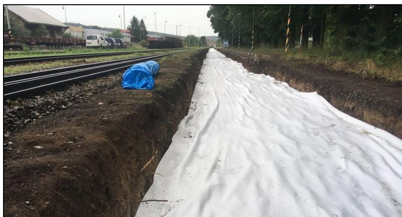
Obr. 5 Pokládka geotextilie na zhutněnou zemní pláň, foto: SAŽEV-REKO [4]
