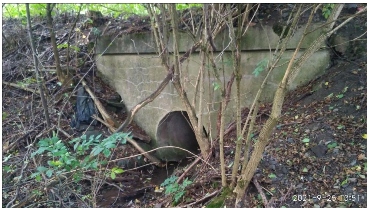
Obr. 55 Stávající stav propustku v km 0,800 233, foto: autor
