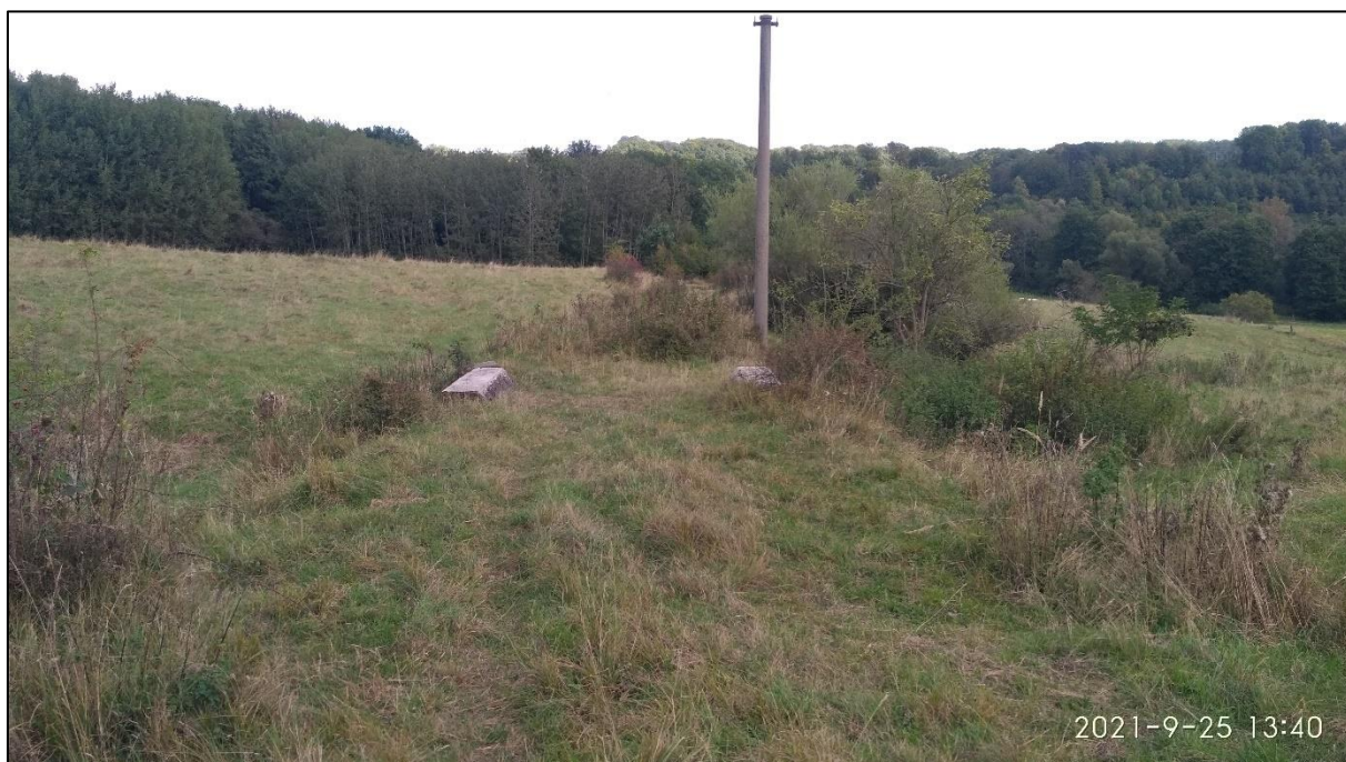
Obr. 43 Stávající stav tělesa trati, na kterém je patrný propustek v km 0,412 020, foto autor
