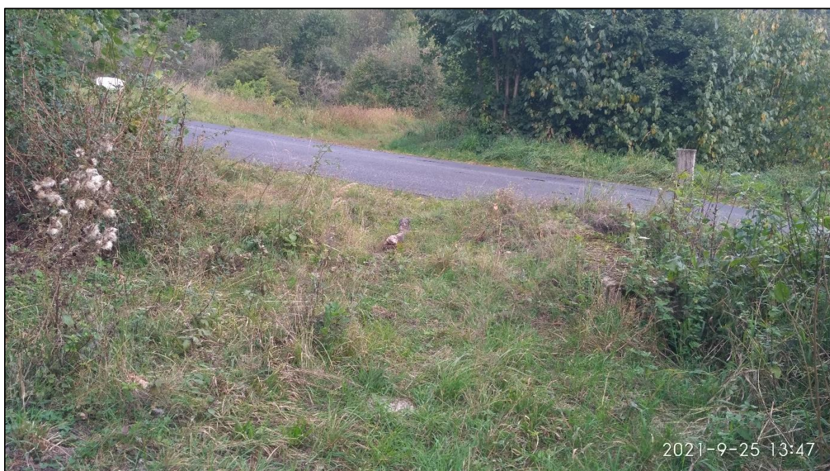
Obr. 51 Stávající stav tělesa trati v místě budoucího železničního přejezdu v km 0,726 488, vpravo je patrné čelo propustku v km 0,720 254 foto: autor
