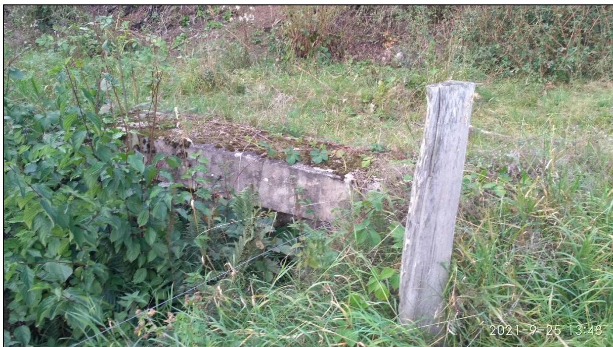
Obr. 52 Stávající stav čela propustku v km 0,720 254, foto: autor
