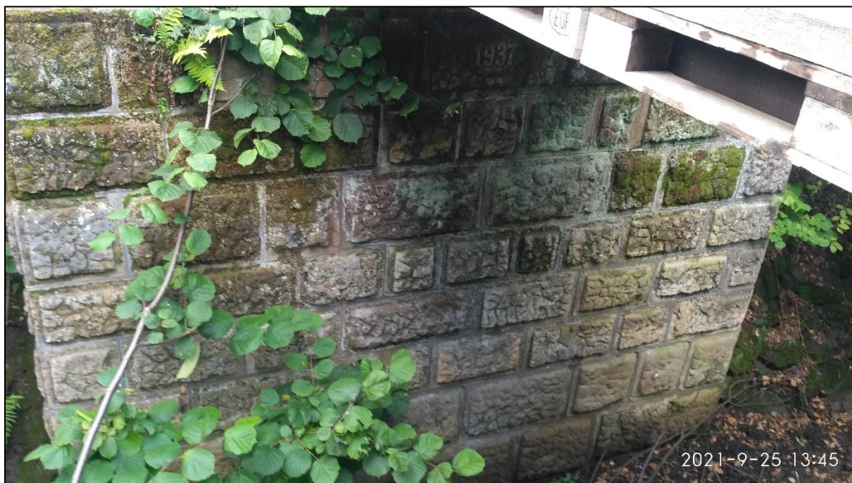
Obr. 48 Stávající stav opěry mostu na Lovečkovické straně potoka v km 0,599 057, na fotografii je patrný velmi dobrý stav zděné opěry, foto: autor
