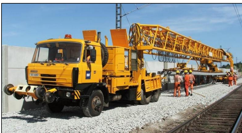
Obr. 8 Pokládka kolejových polí, foto TSS [1]
