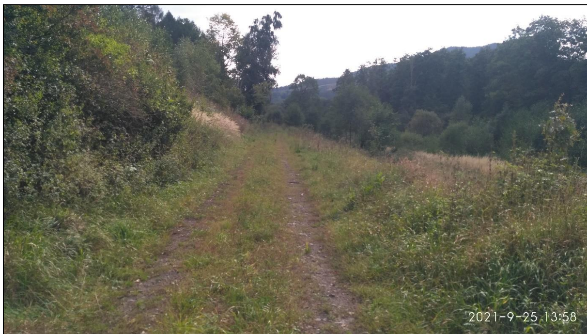
Obr. 58 Stávající stav tělesa trati přibližně v km 1,050 000, foto: autor
