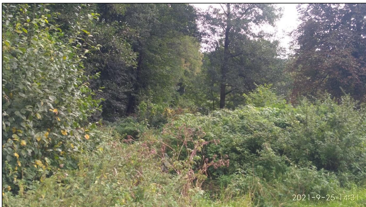
Obr. 71 Stávající stav tělesa trati v místě budoucí zastávky Levín – Městys, foto: autor
