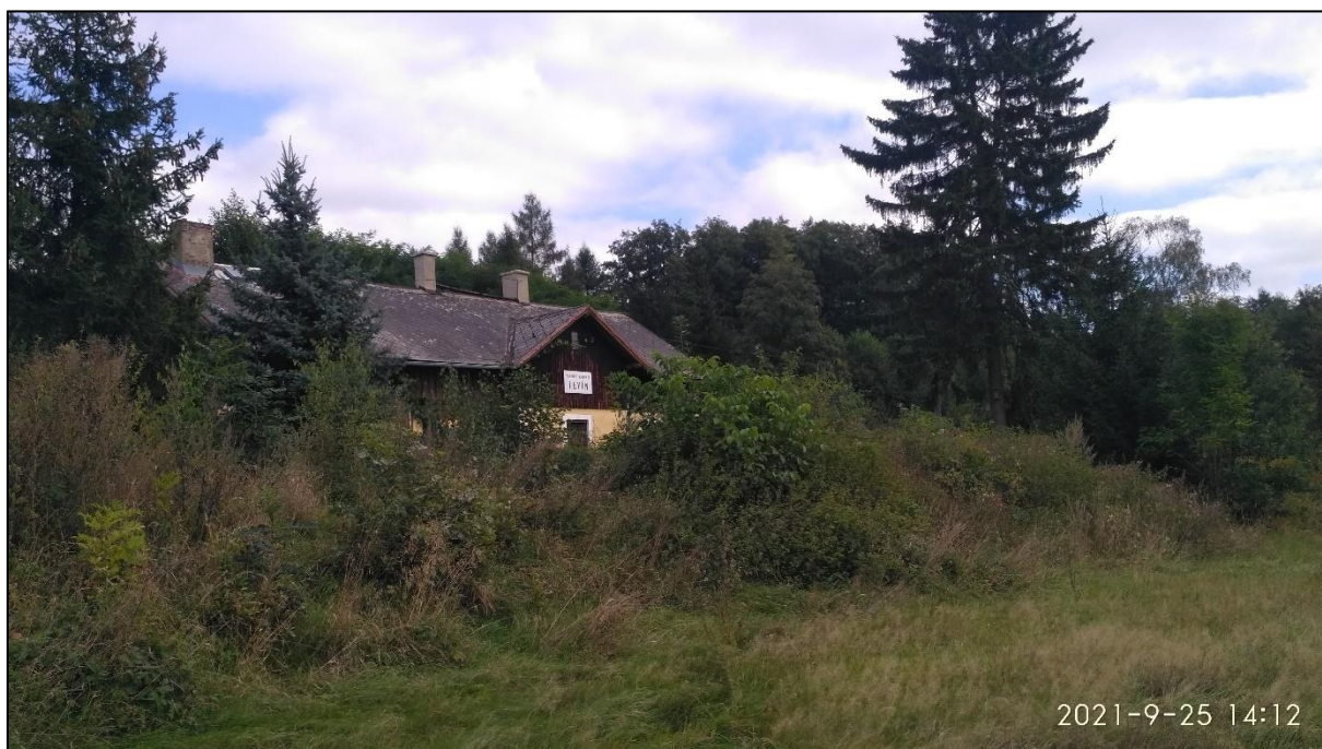
Obr. 63 Pohled na původní výpravní budovu ve stanici Levín, foto: autor
