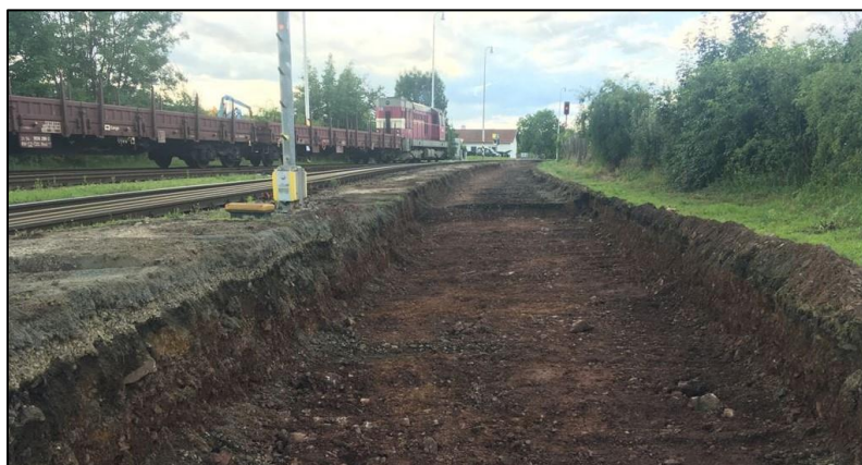
Obr. 4 Odtěžená zemní pláň, foto: SAŽEV-REKO [4]
