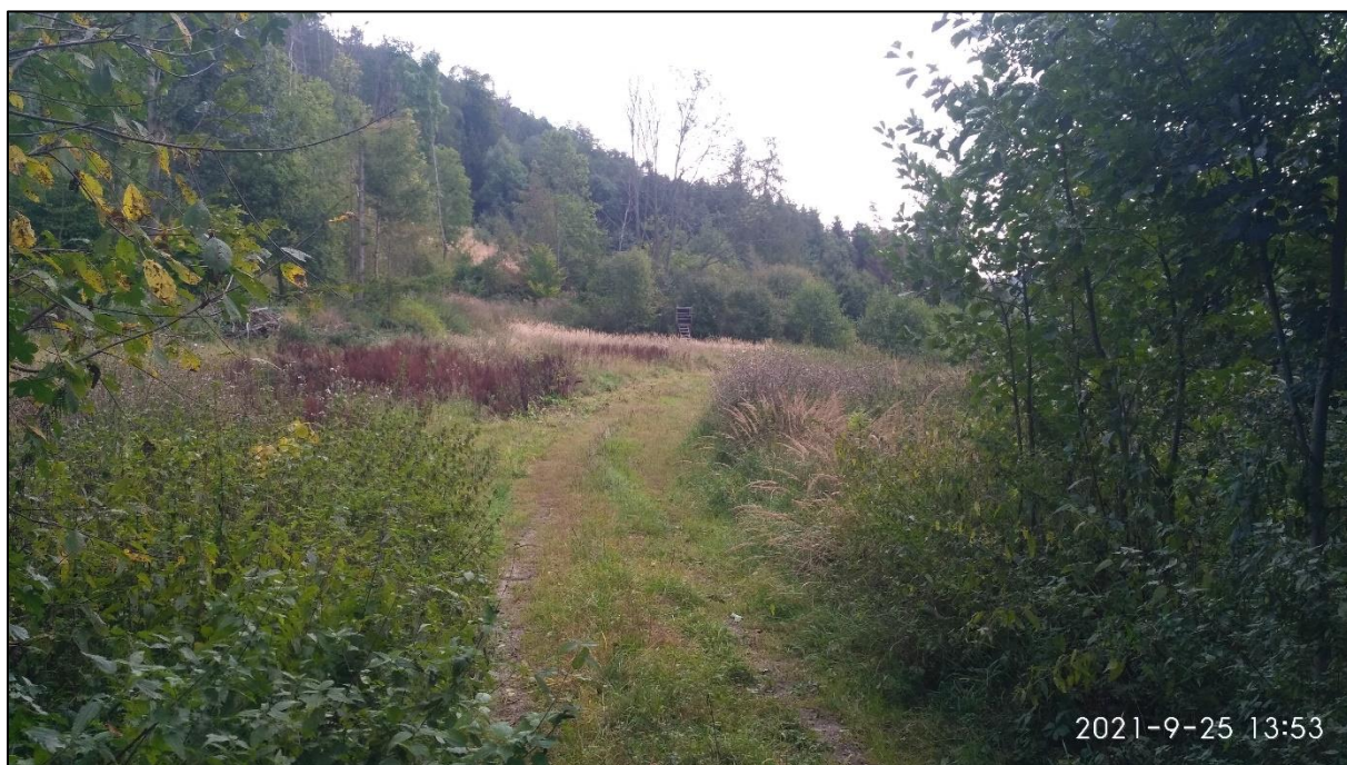
Obr. 57 Stávající stav tělesa trati přibližně v km 0,920 000, foto: autor
