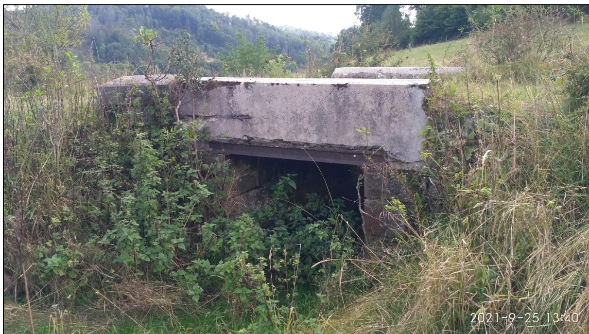
Obr. 44 Stávající stav propustku v km 0,412 020, foto: autor
