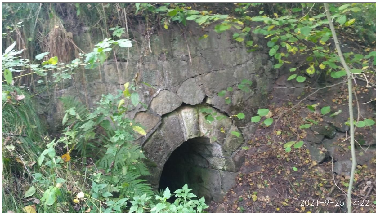
Obr. 66 Stávající stav propustku v km 2,042 000, foto: autor
