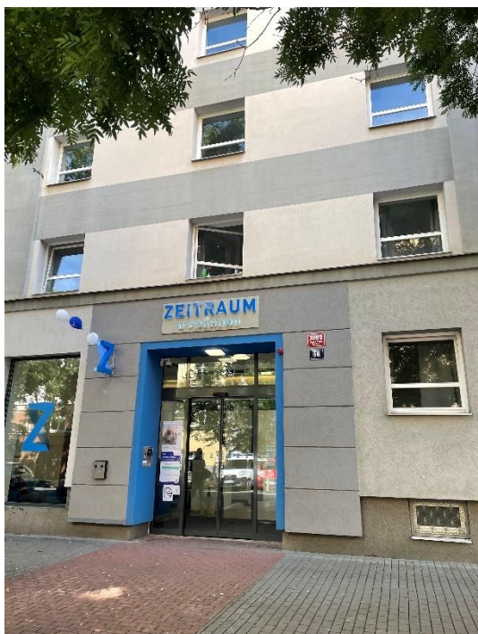
Obrázek 8: Zeitraum Student Housing – exteriér Zdroj: autor
