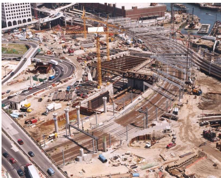
Obrázek 27: Central Artery Boston - realizace tunelu Zdroj: (24)
