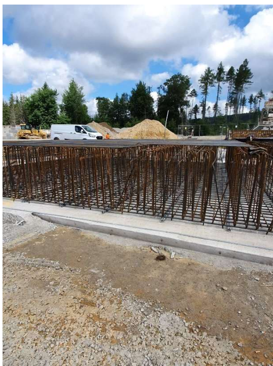
Obrázek 23: Jihlavská obalovna – šalování a základová deska Zdroj: vlastní
