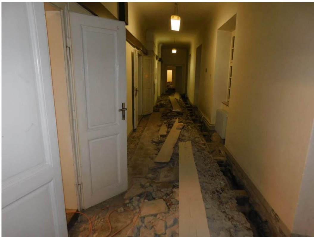
Obrázek 10 – pásové sondy; odkrytí zhlaví trámů stropních konstrukcí na budově Hybernská 1
