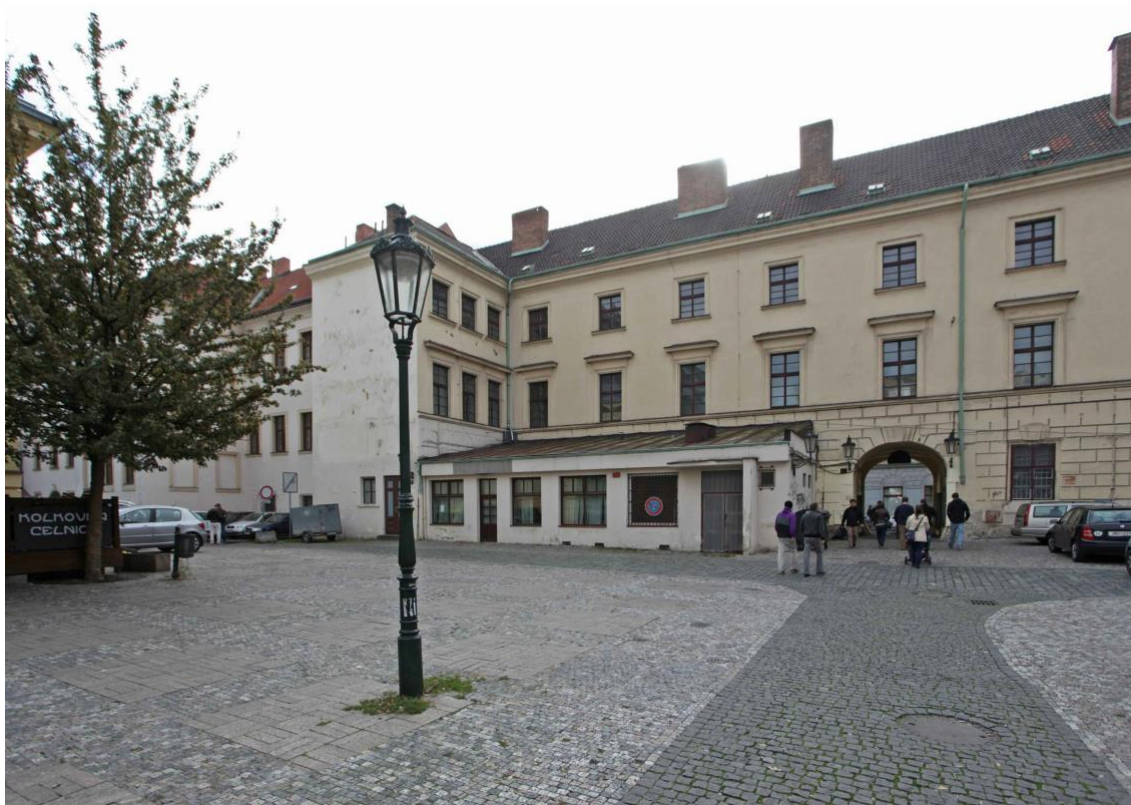
Obrázek 5 - nevhodný přístavek v severní části budovy
