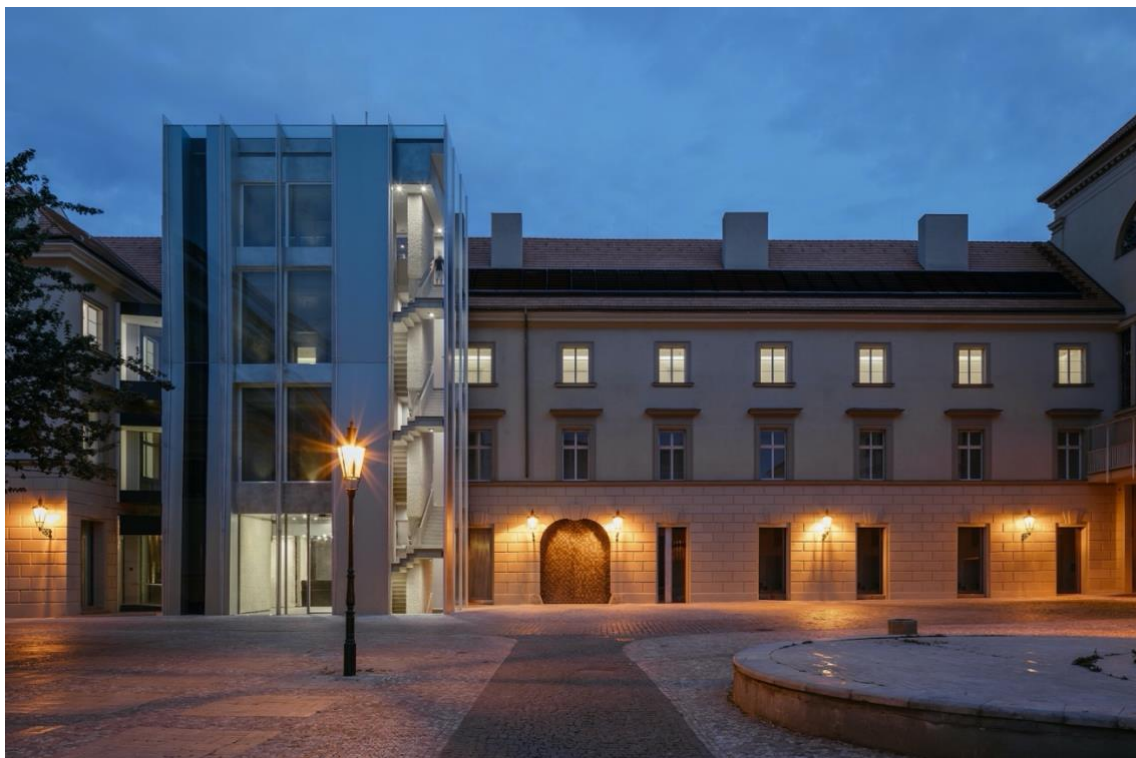
Obrázek 2 - Hyberská 1; po obnově
