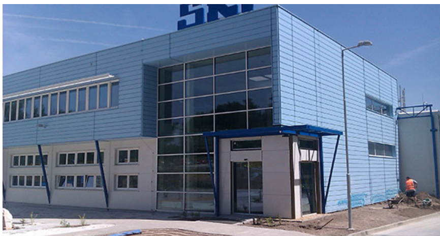
Obrázek 7 Výrobní hala Lubricon s certifikací LEED Platinum [41]
