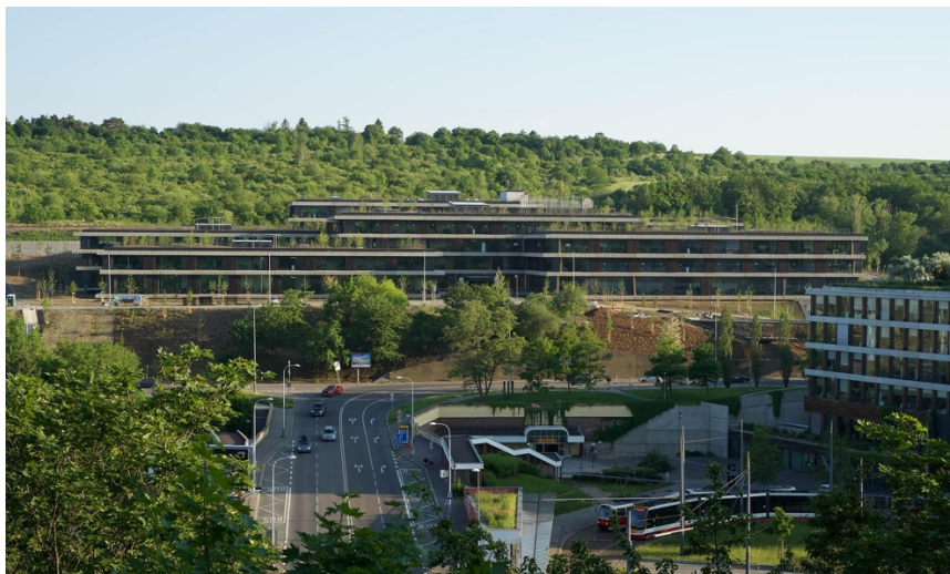
Obrázek 6 Kampus ČSOB s certifikací LEED Platinum [40]
