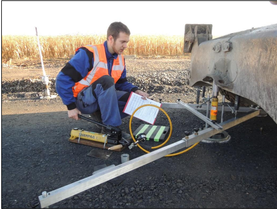
Měření na trati v Uničově, zkouška 1
