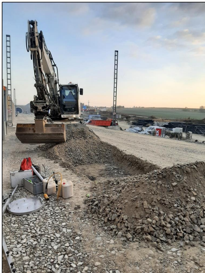
Měření na trati v Soběslavi, odebrání konstrukční vrstvy z ŠD 0/63 na úroveň ZP
