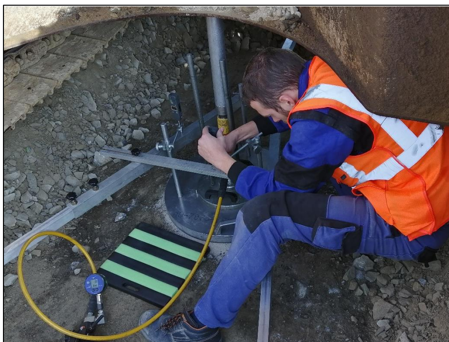
Měření na trati v Soběslavi, příprava zkoušky 2
