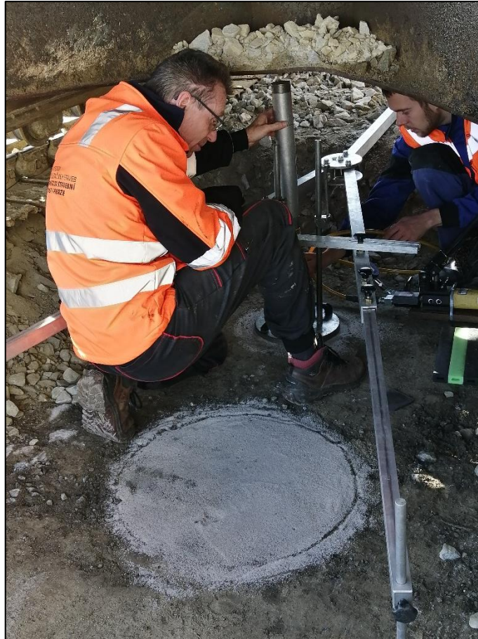
Měření na trati v Soběslavi, příprava zkoušky 3
