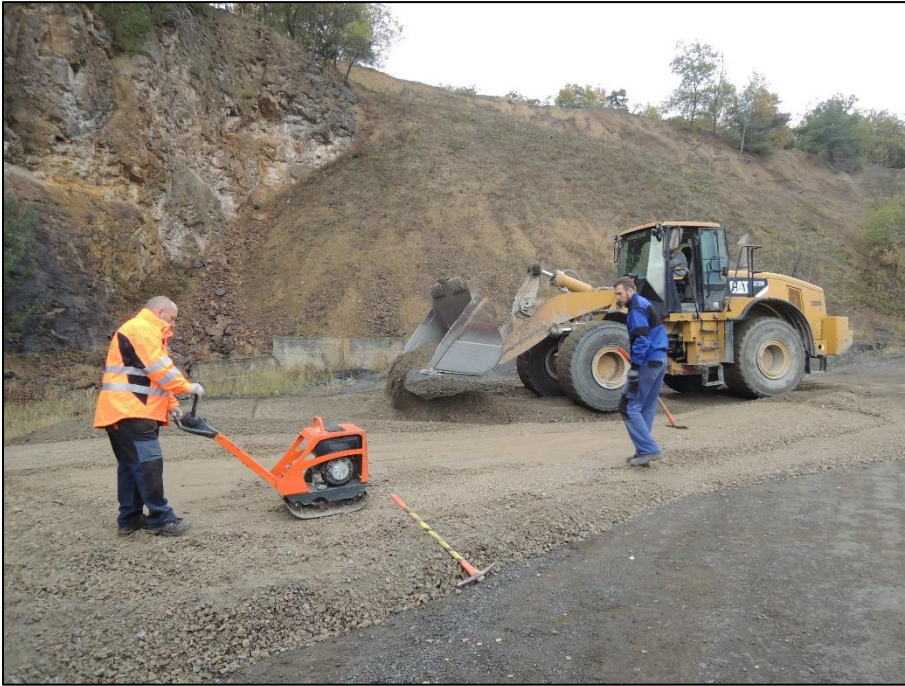
Druhé měření v kamenolomu Zbraslav, příprava zkušebních vrstev
