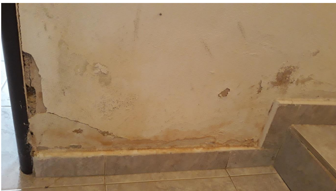
Obrázek 25 – Vlhkost ve zdivu Zdroj: vlastní
