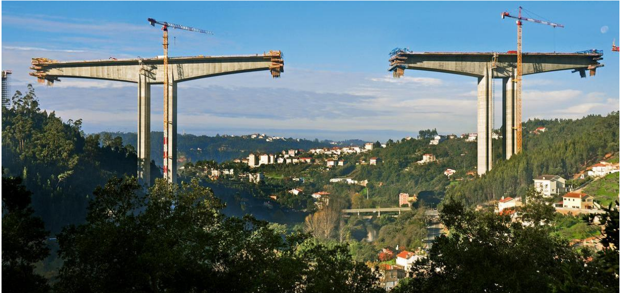
Obr. 49 - Pohled na výstavbu [83]
