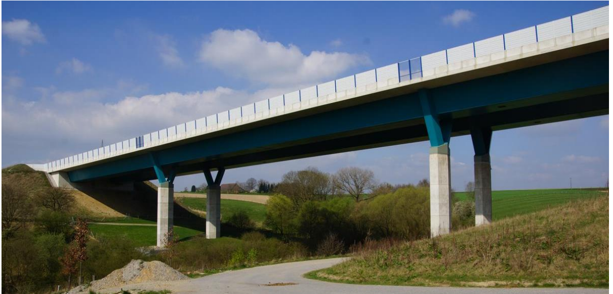
Obr. 26 - Pohled na konstrukci [41]
