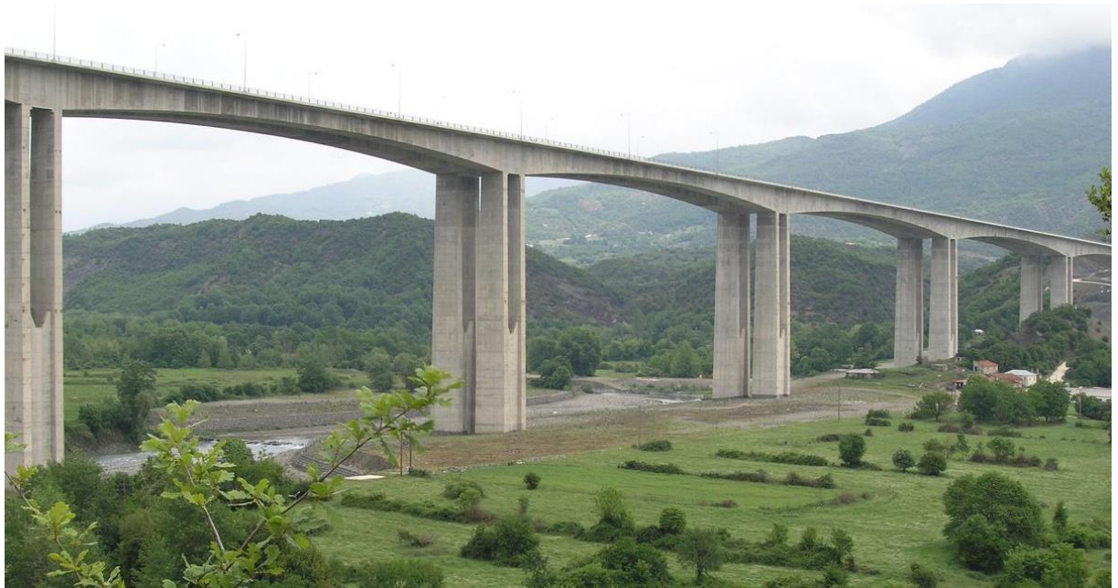
Obr. 46 - Pohled na hotovou konstrukci [78]
