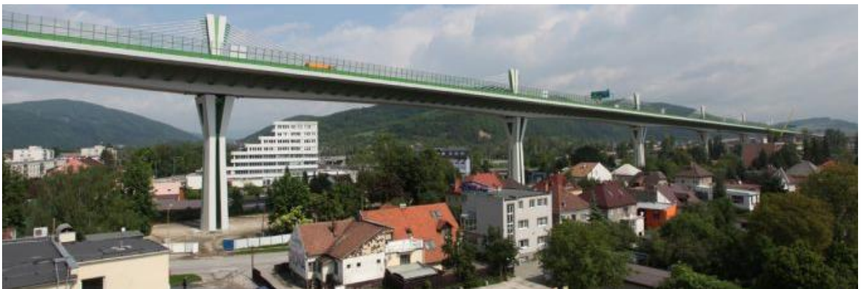
Obr. 30 - Pohled na hotový most [47]
