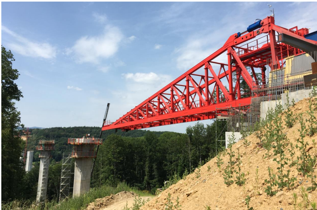
Obr. 7 - Pohled na výsuvný nos (foto autor)
