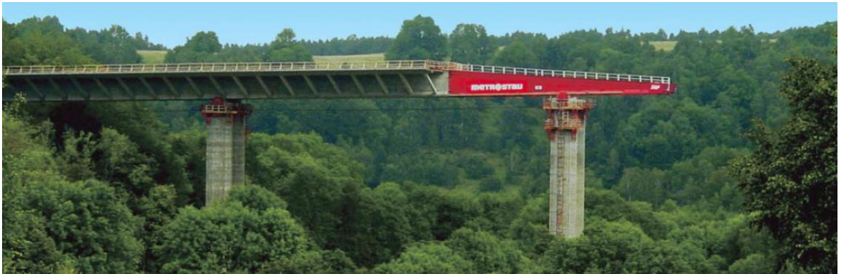
Obr. 10 - Pohled na most při výsunu [11]
