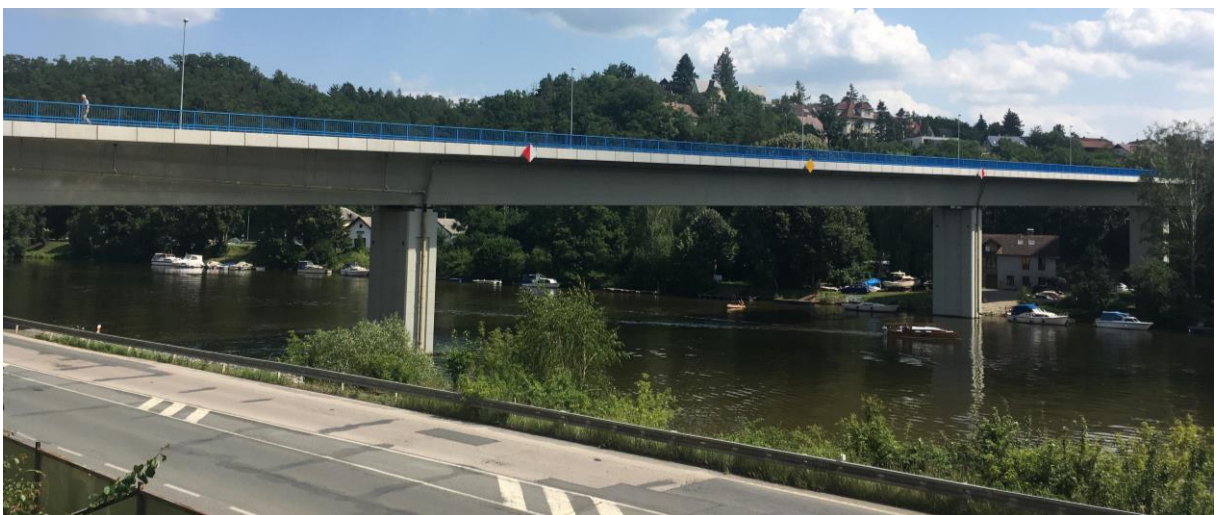
Obr. 17 - Pohled na most po sanaci (foto autor)
