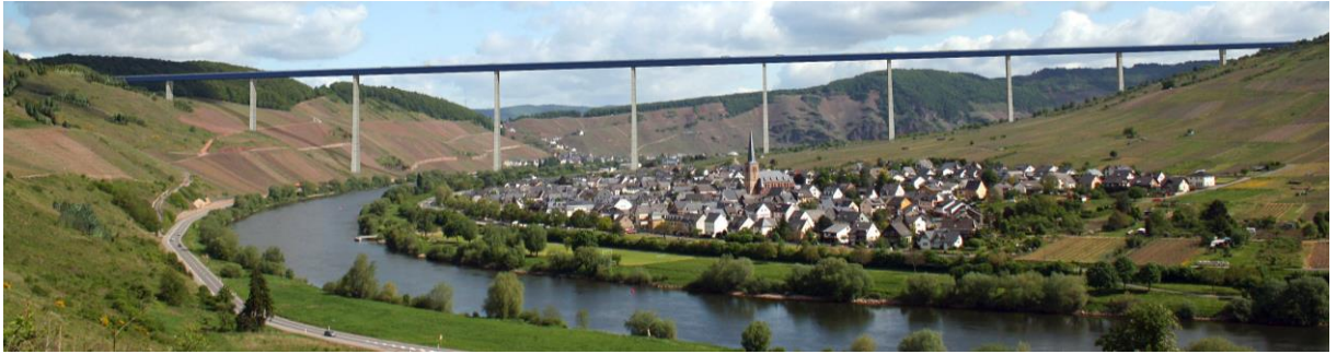
Obr. 24 - Pohled na hotovou konstrukci [34]
