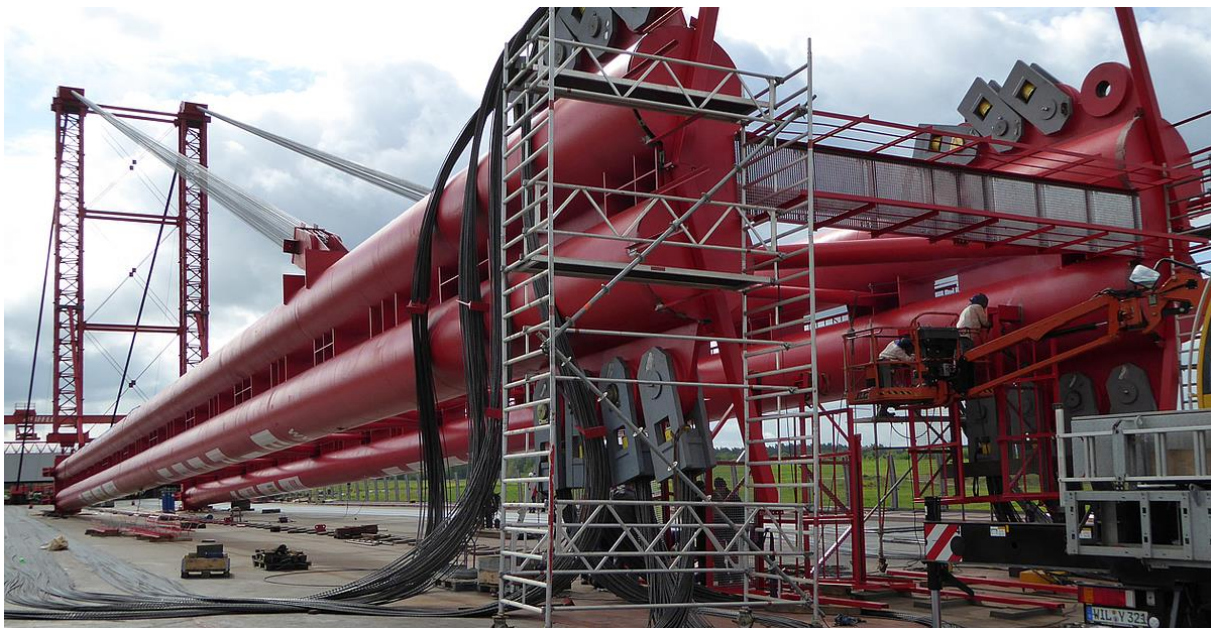
Obr. 23 - Pohled na nevztýčený pomocný pylon [33]
