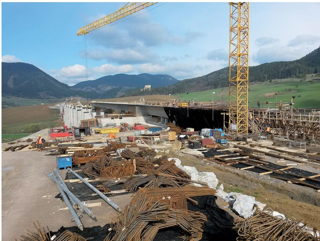
Obr. 12 - Pohled na staveniště [13]
