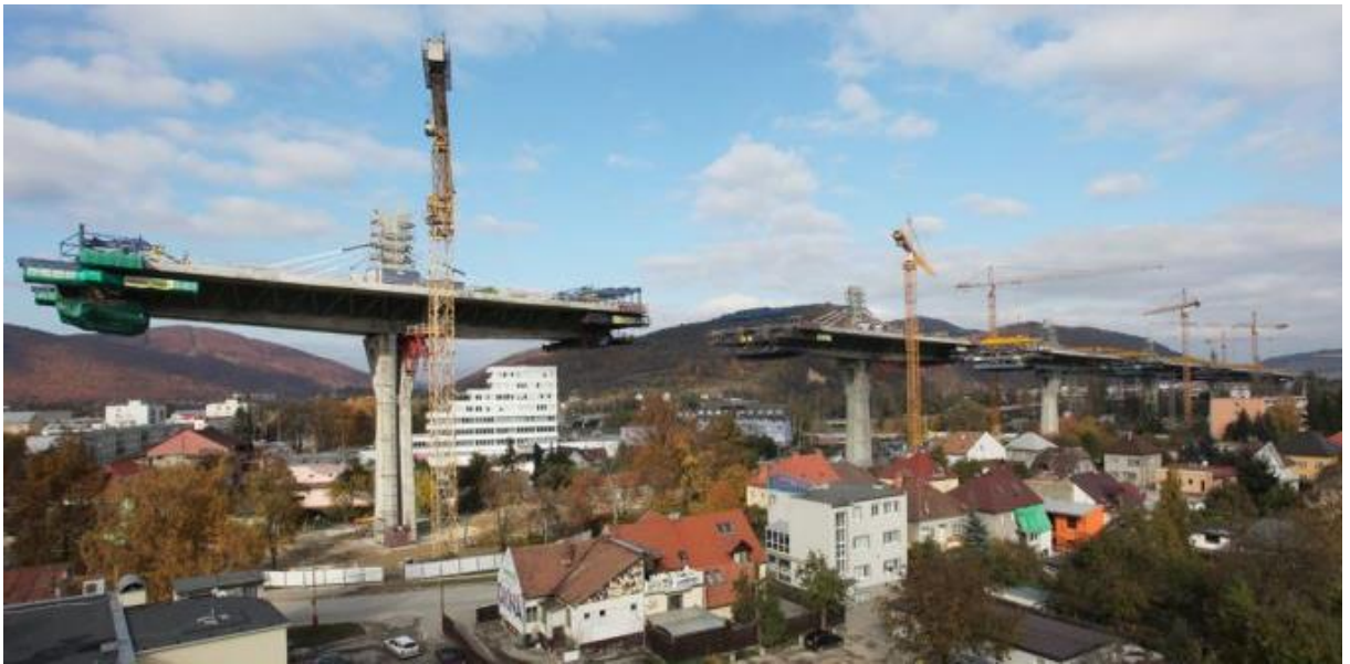
Obr. 29 - Pohled na průběh výstavby mostu [47]
