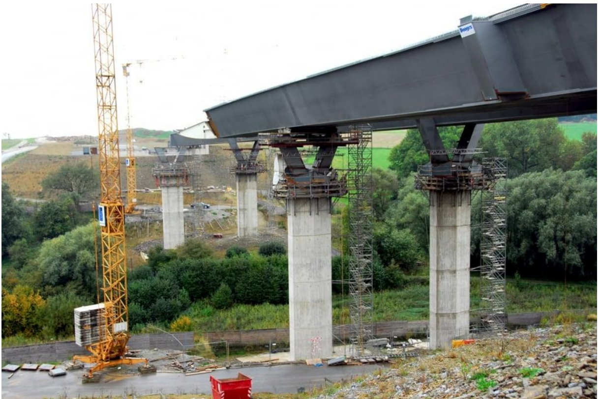
Obr. 27 - Pohled na vysouvanou konstrukci [42]
