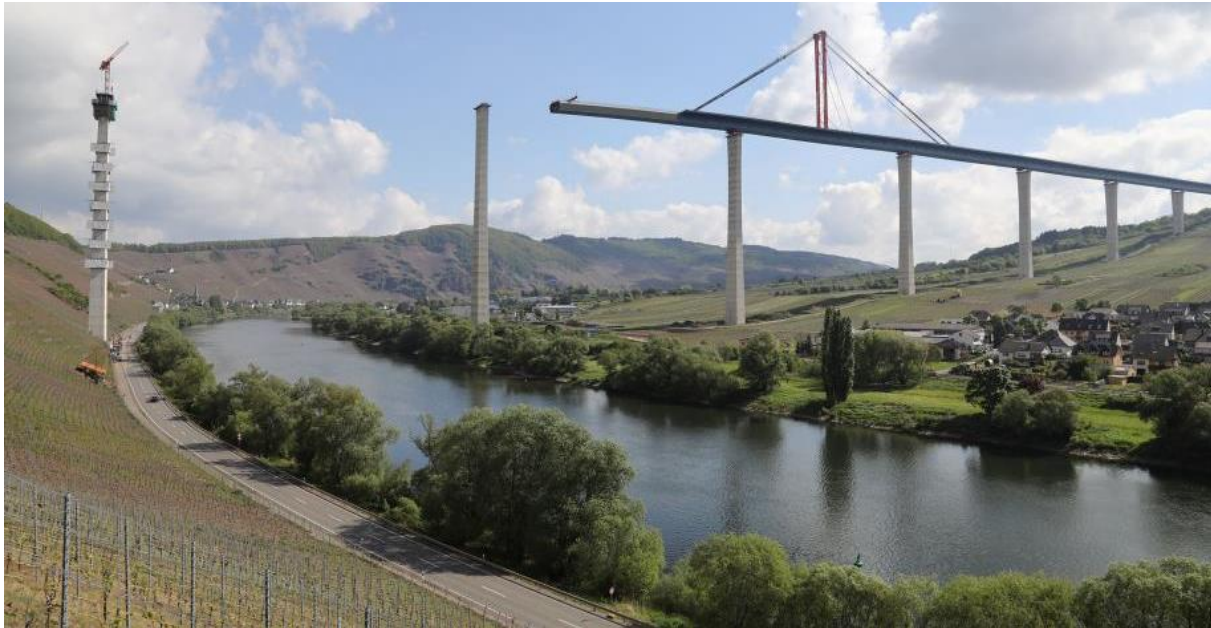
Obr. 22 - Pohled na vysouvání most [32]
