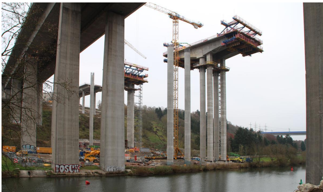
Obr. 43 - Pohled na rozestavěný most (vlevo starý most) [75]
