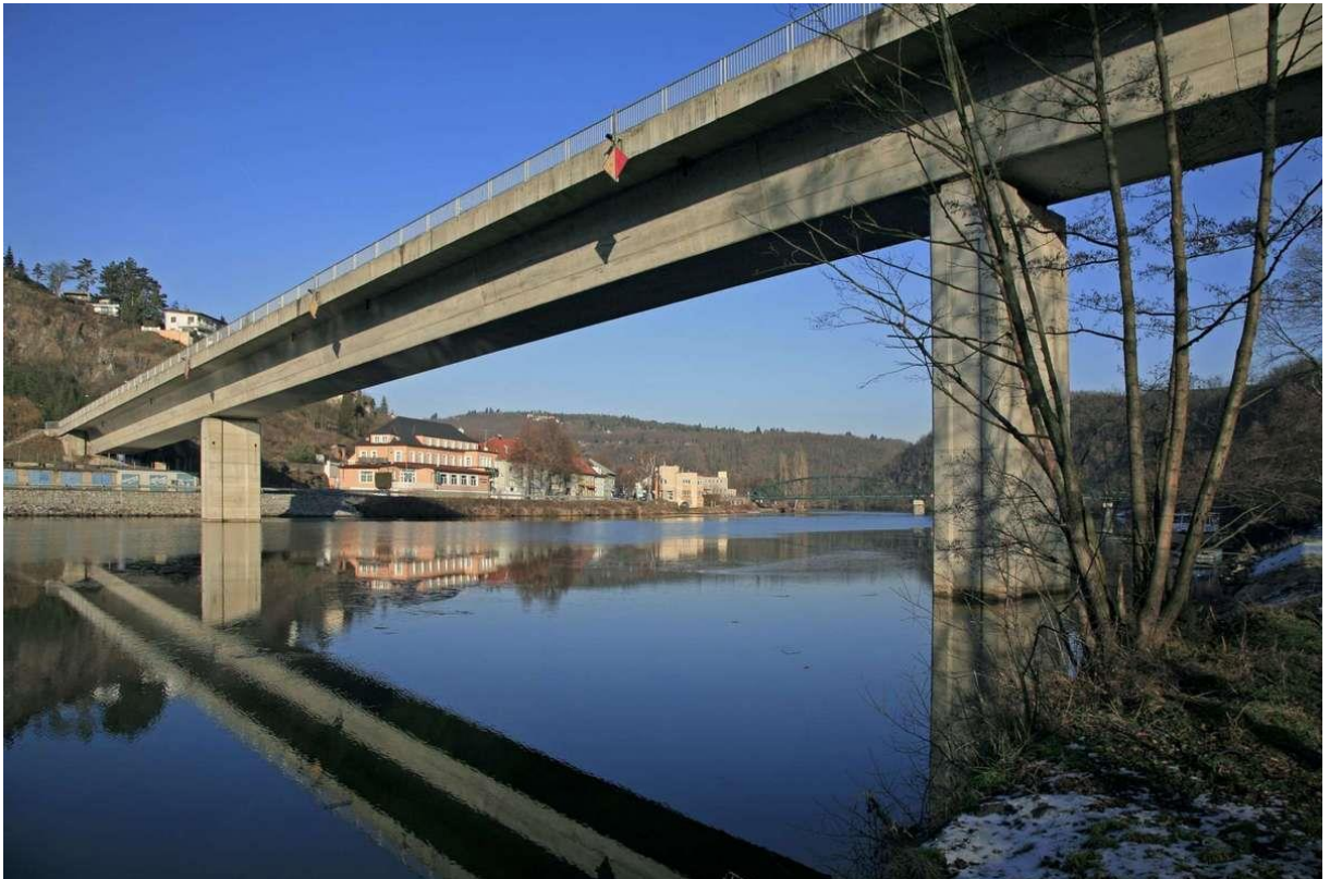
Obr. 16 - Pohled na most před sanací [21]
