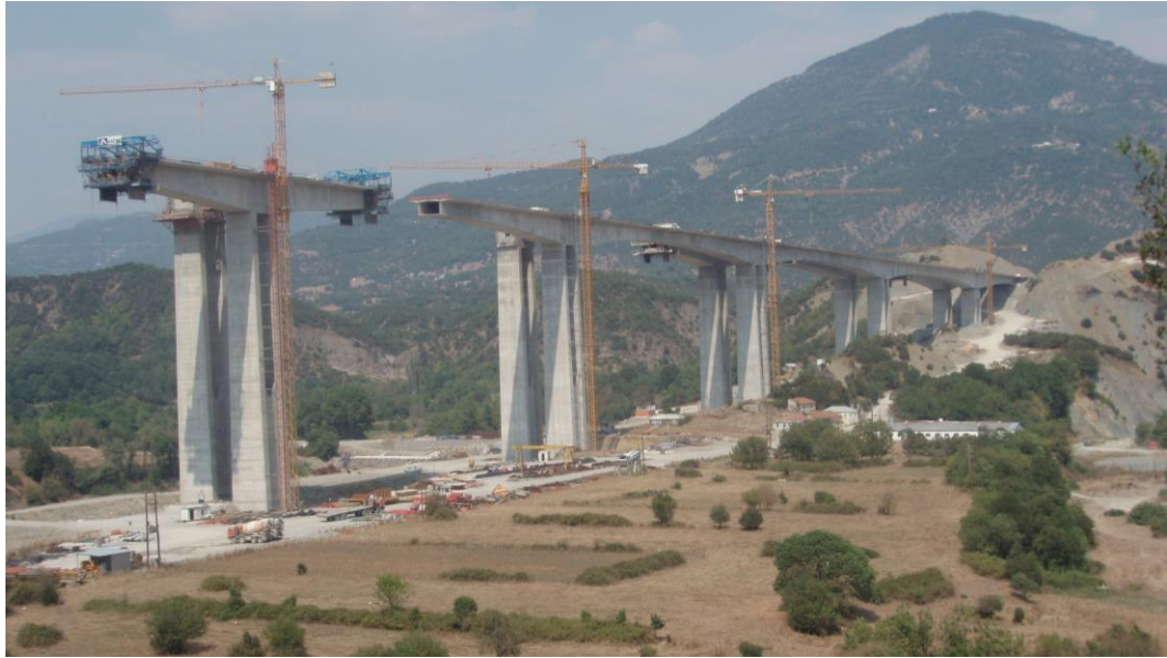
Obr. 44 - Pohled na vahadlový způsob výstavby [76]
