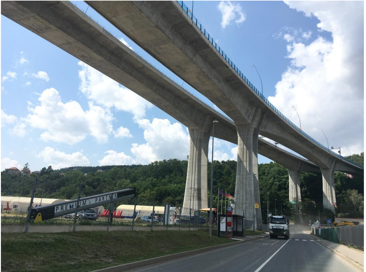
Obr. 34 - Pohled na severní část estakády (foto autor)
