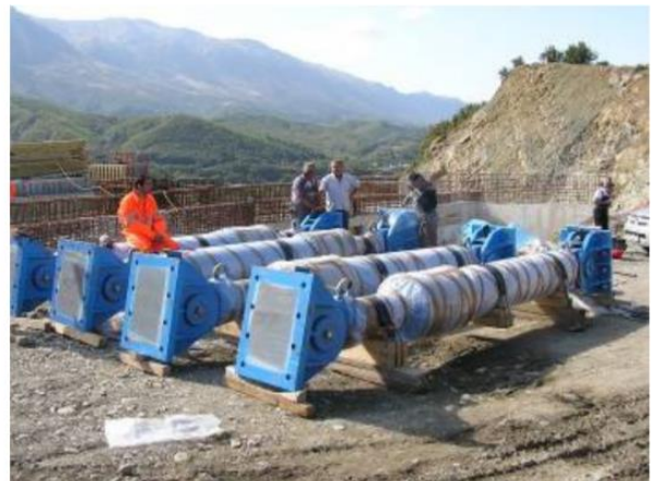
Obr. 45 - Viskózní tlumiče [77, s. 240]
