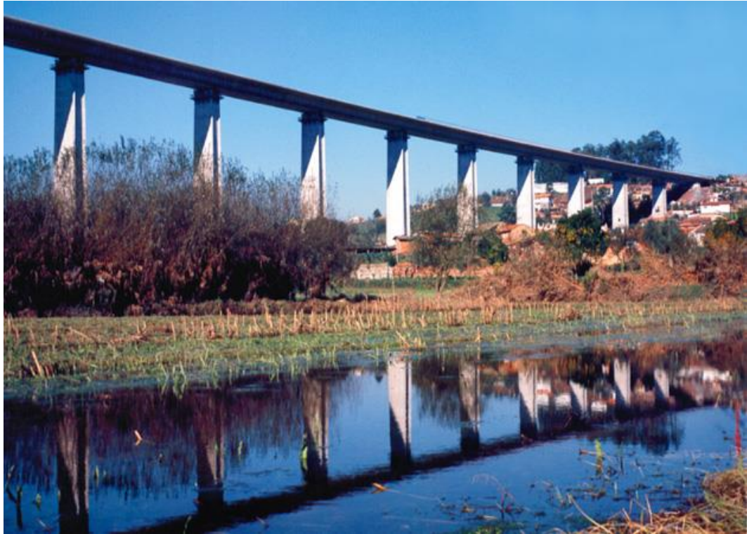
Obr. 18 - Pohled na most přes řeku Águeda [23]
