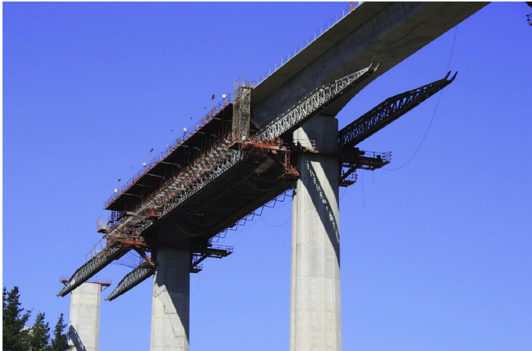
Obr. 52 - Pohled na výsuvnou skruž [87]
