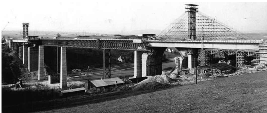
Obr. 41 - Výstavba mostu 1965 - provizorní pylon [72]
