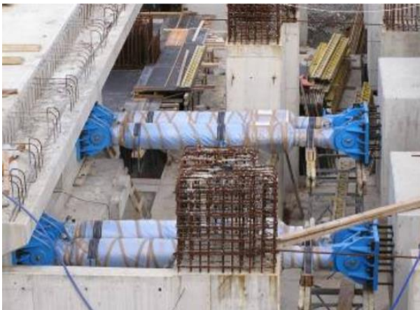
Obr. 45 - Viskózní tlumiče [77, s. 240]
