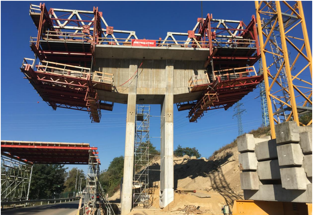
Obr. 31 - Pohled na rozestavěné vahadlo u mostu přes Mži v Plzni (foto autor)
