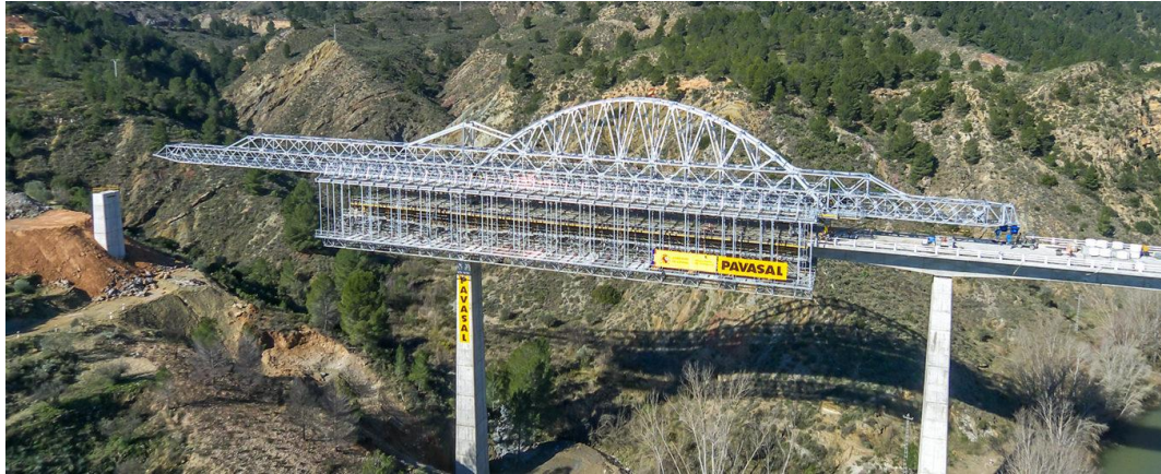
Obr. 51 - Výsuvná skruž BERD MSS M70-S [86]
