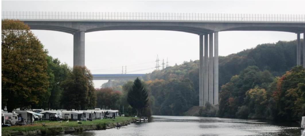
Obr. 42 - Pohled na hotovou konstrukci (v pozadí železniční ICE most) [74]
