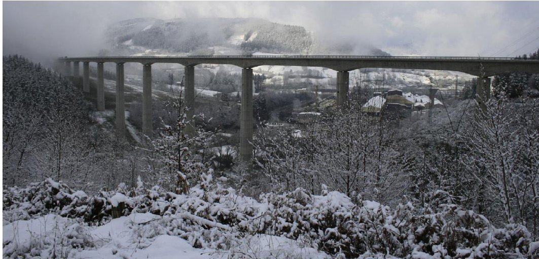
Obr. 53 - Pohled na hotovou konstrukci [87]
