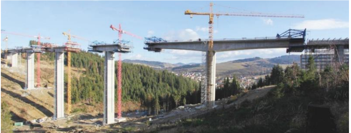
Obr. 38 - Pohled na stavbu nosné konstrukce mostu Valy [70]
