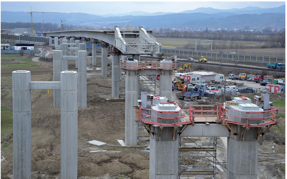
Obr. 13 - Pohled na výsuvný nos [14]
