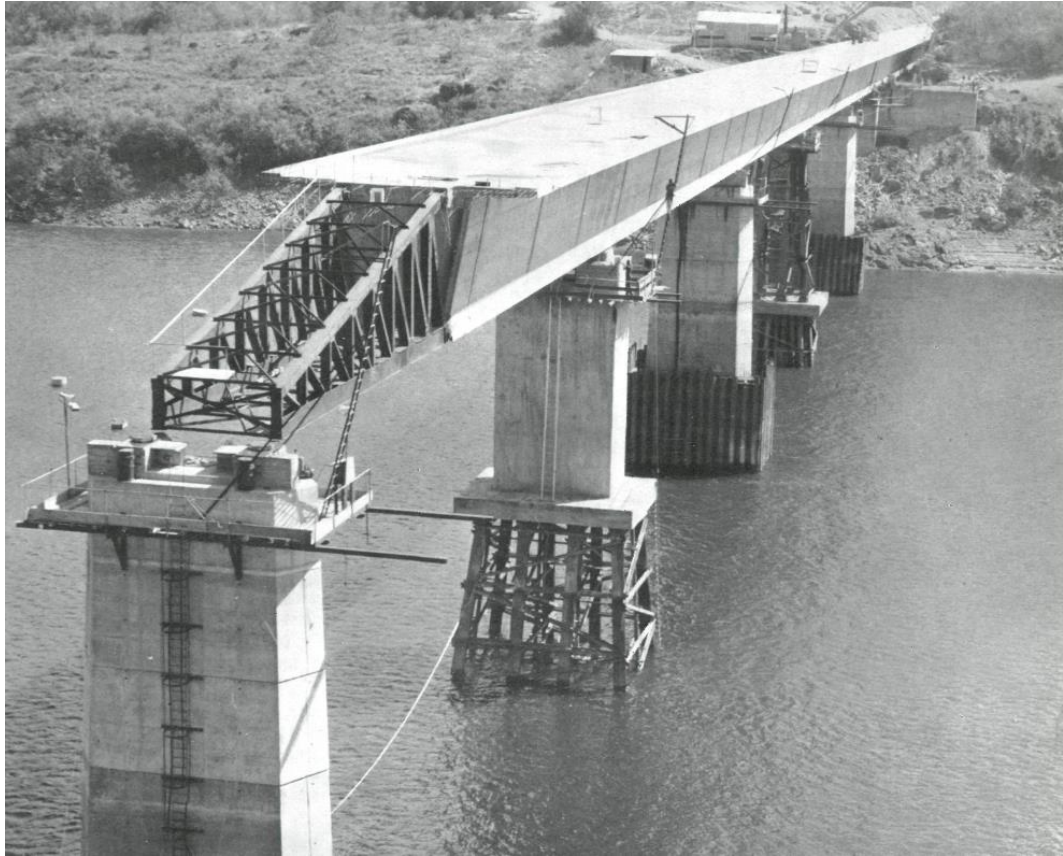
Obr. 20 - Pohled na výsun mostu [27]
