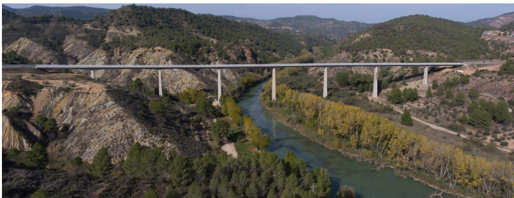
Obr. 50 - Pohled na hotový most [86]
