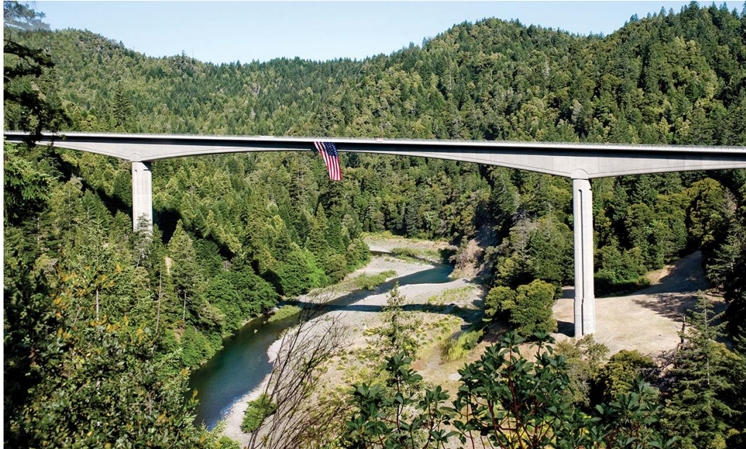
Obr. 47 - Pohled na hotový most [80]
