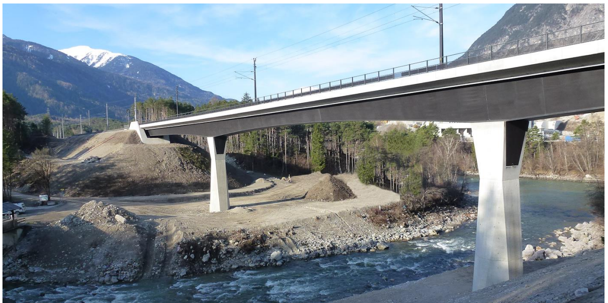
Obr. 9 - Pohled na hotový most [8]
