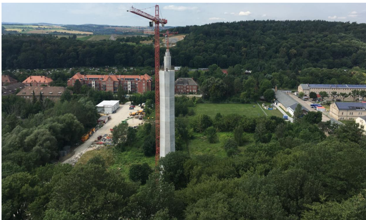
Obr. 8 - Pohled z pilíře 80 ve směru výsunu (foto autor)
