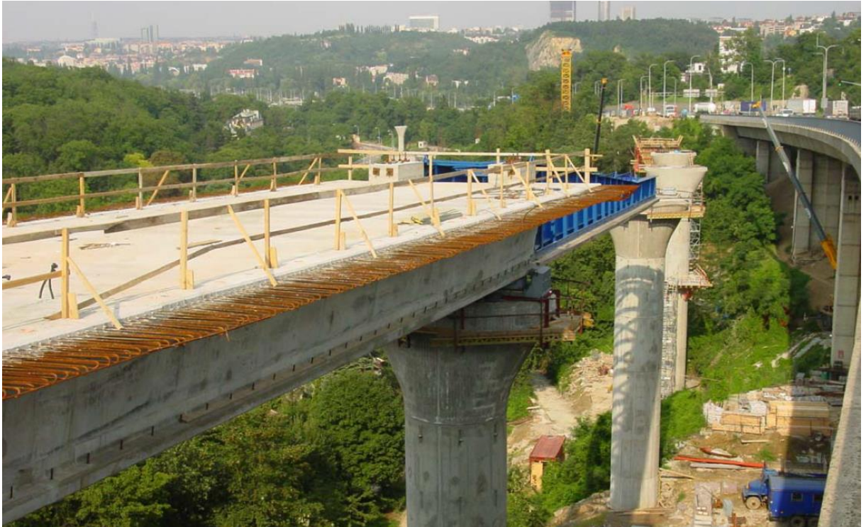
Obr. 14 - Pohled ve směru výsuvu mostů [19]
