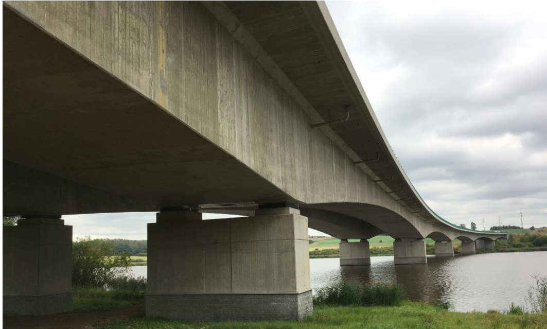
Obr. 37 - Pohled na most přes rybník Koberný (foto autor)
