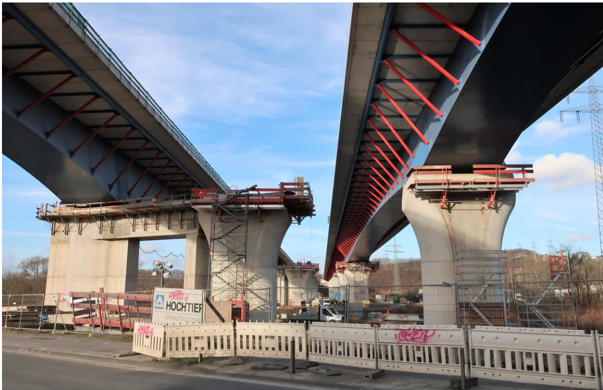
Obr. 28 - Pohled na oba mosty před příčným posunem [45]
