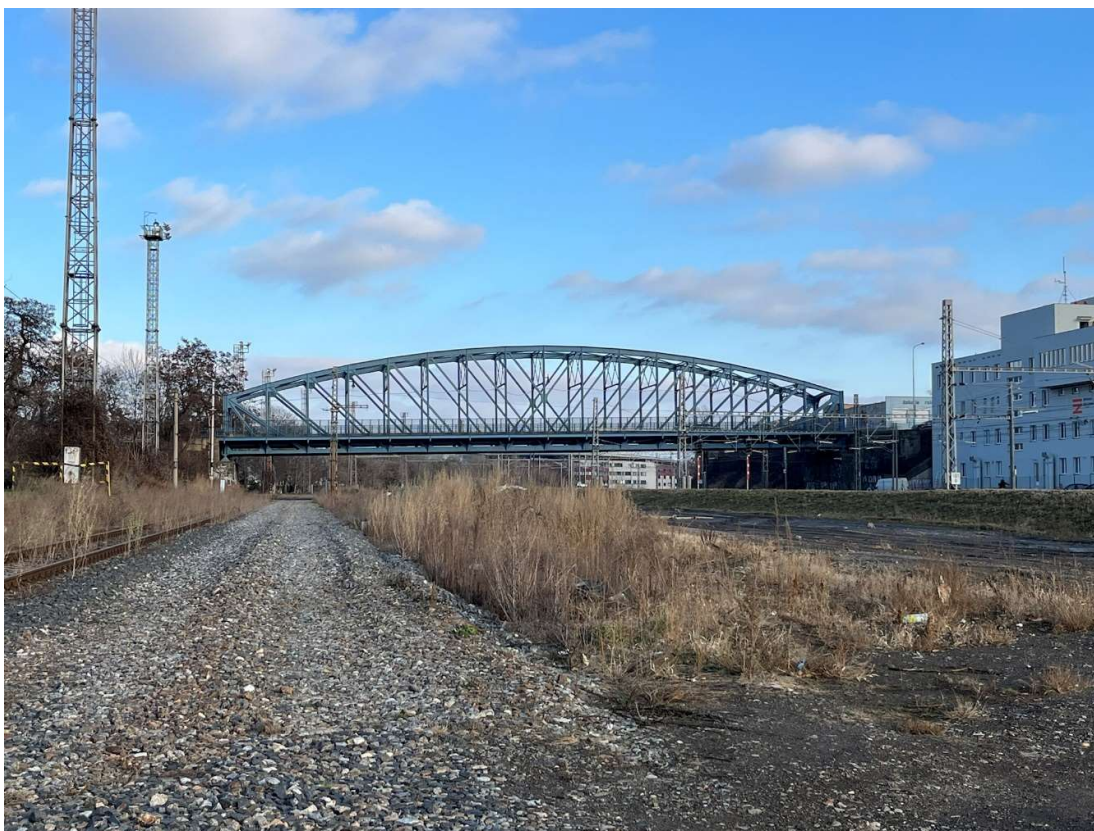
Fotografie 9 Pohled na silniční most přes železniční trať č.221
