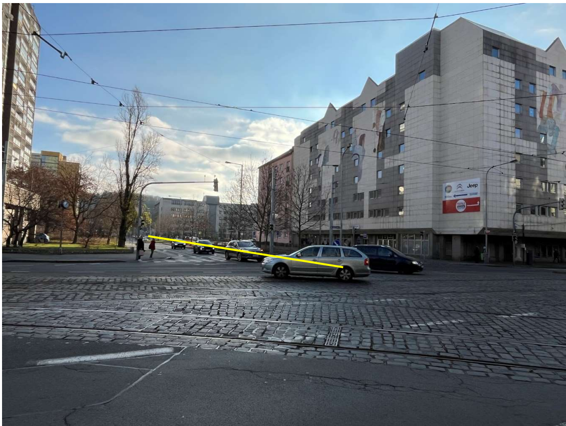
Fotografie 1 Pohled na křižovatku ulic Vršovická x Moskevská
