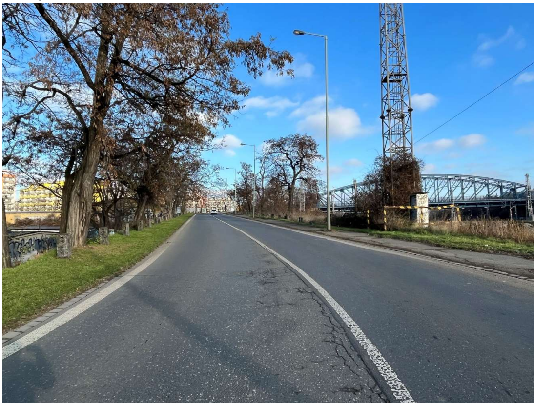
Fotografie 12 Pohled na ulici Moskevská spolu se silničním mostem
