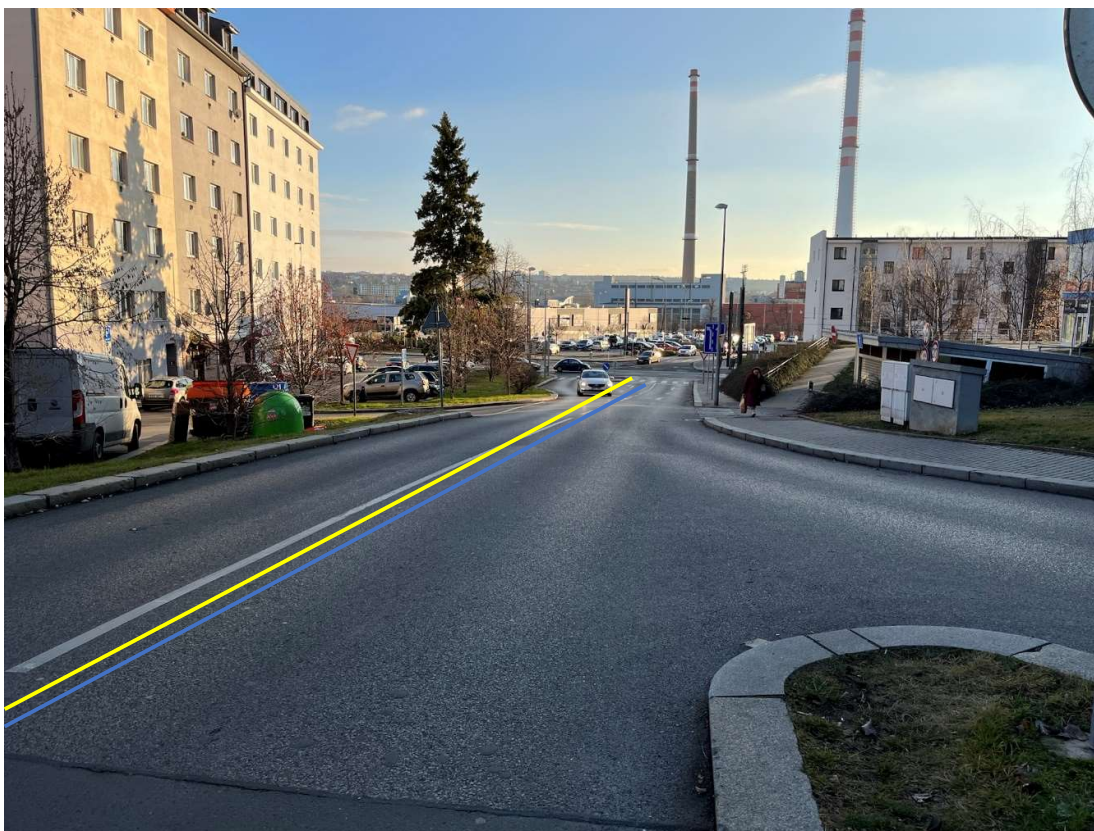
Fotografie 35 Pohled na ulici Popovická (ve směru staničení navrhovaných tras)
