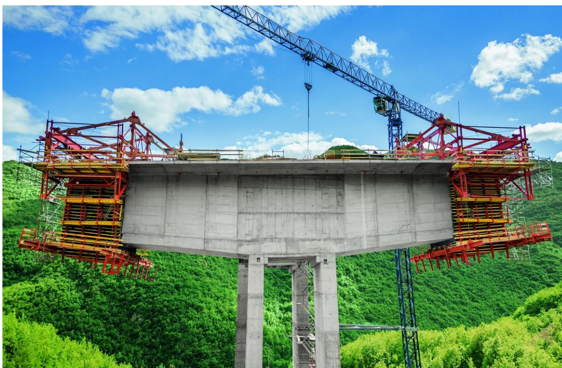
Obrázek 2.1: Symetrický postup letmé betonáže v Severní Makedonii [31]
