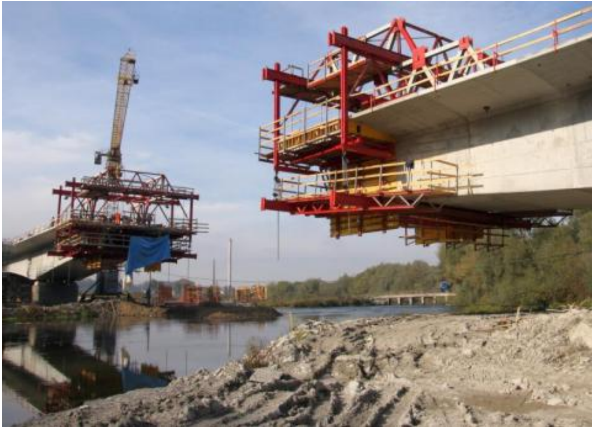
Obrázek 2.16: Výstavba přes vodoteč [32]
