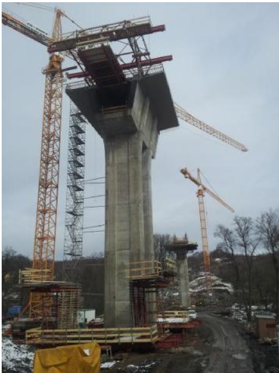
Obrázek 2.17: Kompletace bednění betonážního vozíku [32]
