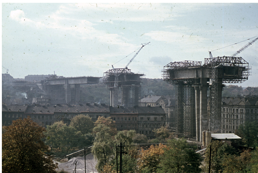
Obrázek 2.7: Výstavba Nuselského mostu [33]
