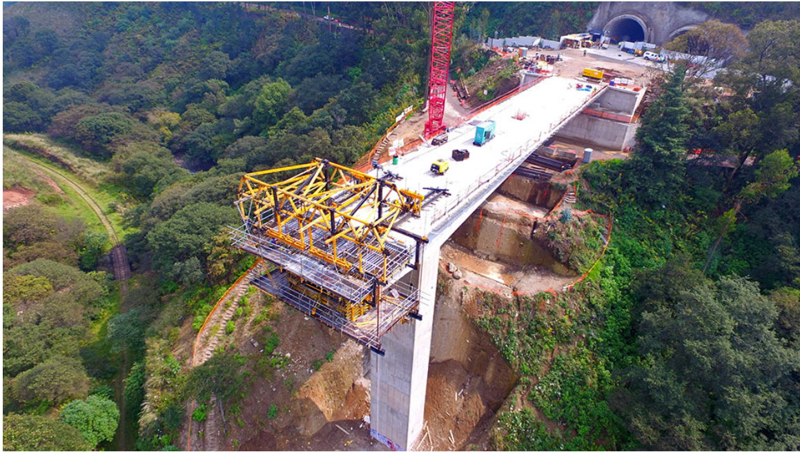
Obrázek 2.2: Letmá betonáž v nepřístupném terénu [32]
