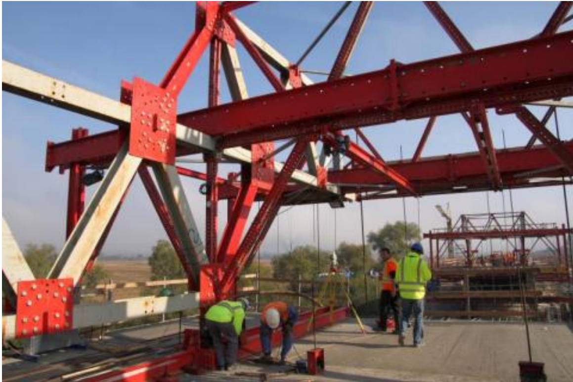
Obrázek 2.15: Horní nosné části betonážního vozíku [32]
