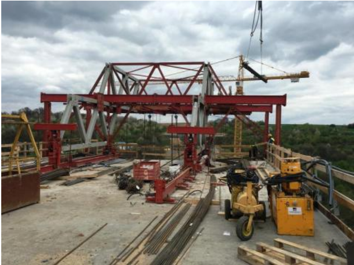
Obrázek 2.14: Uchycení betonážního vozíku na nosné konstrukci [32]
