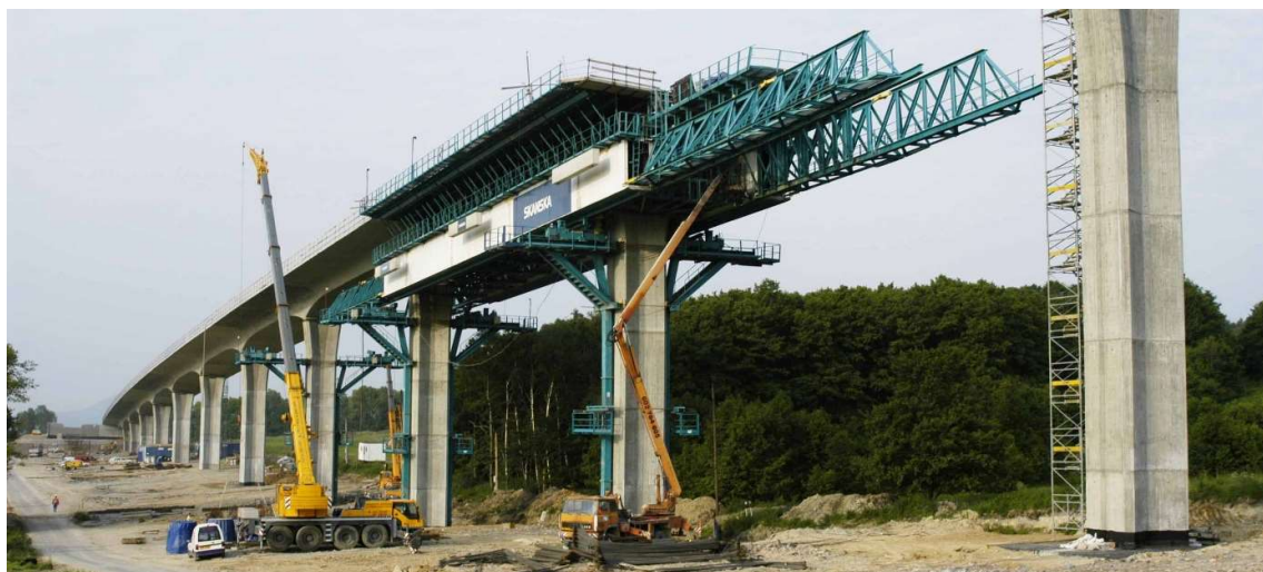
Obrázek 16: Most Knínice během výstavby spodní výsuvnou skruží [3]
