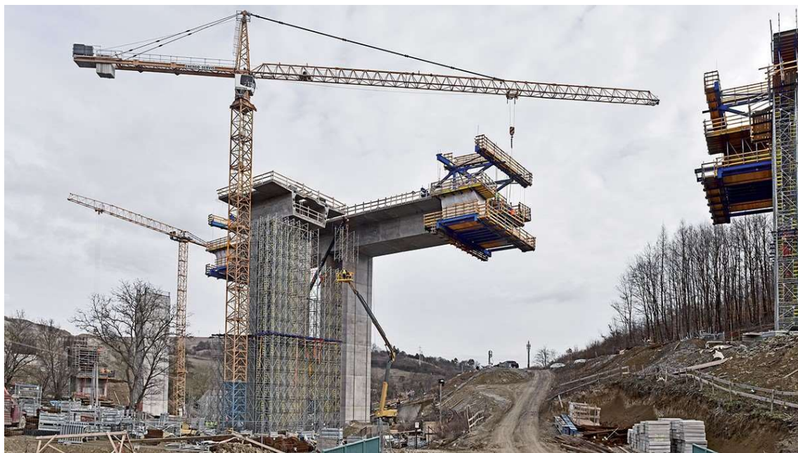
Obrázek 52: Most přes Malkovský potok během realizace vahadel [24]
