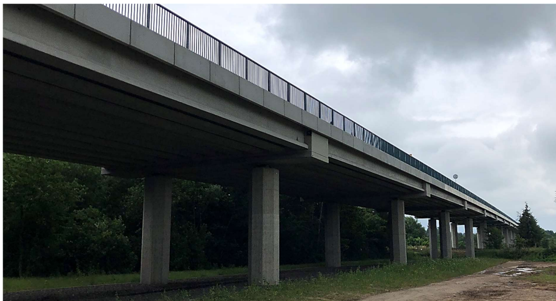
Obrázek 19: Fotografie dokončeného mostu v Hořicích
