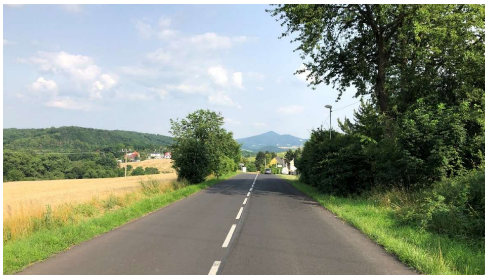
Obrázek 10: Silnice III/25337 ve velmi dobrém stavu
