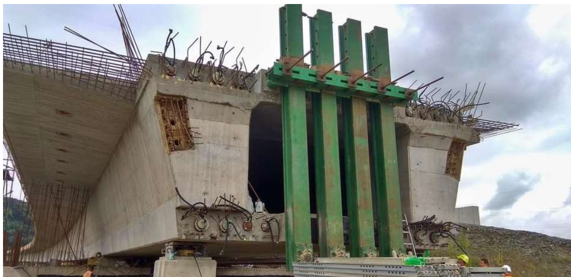
Obrázek 51: Detail tažného výsuvného zařízení [23]
