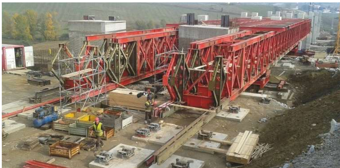
Obrázek 38: Pohled na tvar opěry během výstavby [12]
