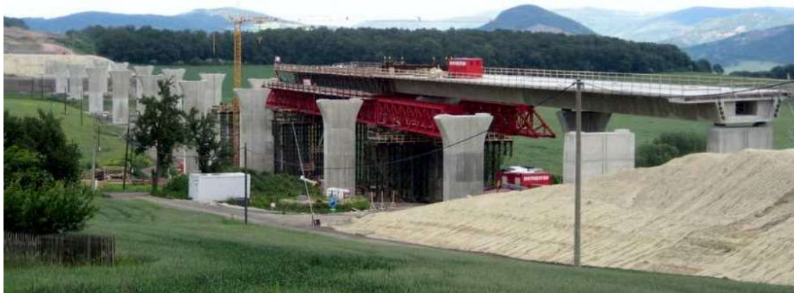
Obrázek 31: Most při výstavbě na výsuvné skruži ŽM16 [9]
