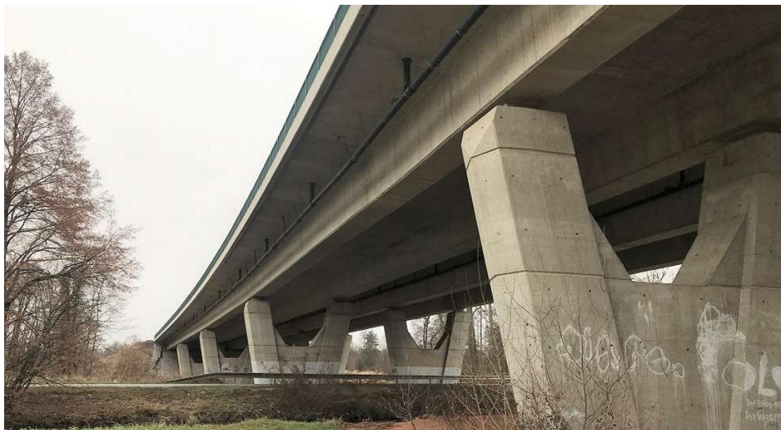
Obrázek 21: Boční pohled na most přes Opatovický kanál
