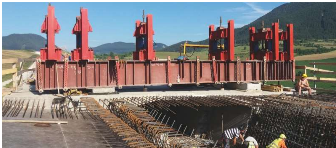
Obrázek 37: Kotvení předchozího betonážního taktu k výsuvné skruži [12]
