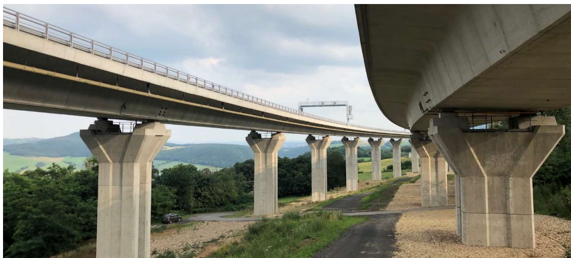
Obrázek 49: Fotografie dálničních segmentových mostů u obce Prackovice
