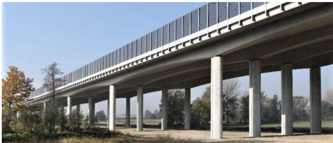
Obrázek 26: Most přes Husí potok na dálnici D47 [7]
