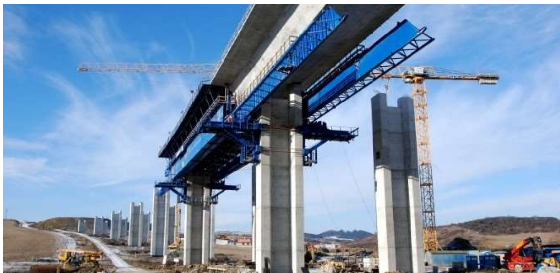
Obrázek 27: Pohled na most během výstavby na výsuvné skruži [8]
