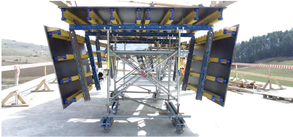
Obrázek 148: Vozík pro podepření bednění horní desky komorového průřezu [11]
