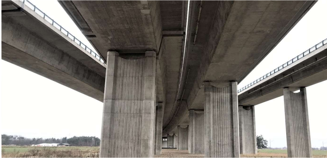
Obrázek 32: Fotografie hlavního mostu a přípojných bočních ramp
