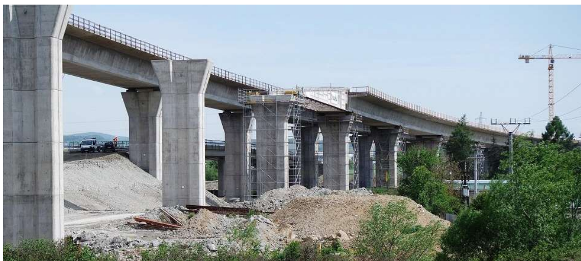
Obrázek 50: Pohled na most v Prešově během výsunu [23]
