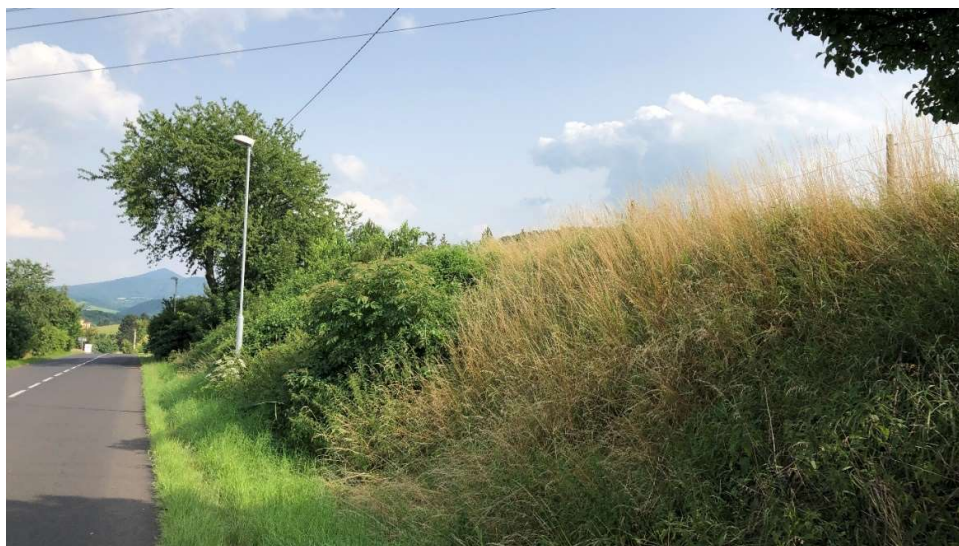
Obrázek 11: Pohled ze silnice III/25337 na svah u plánované Bilinské opěry
