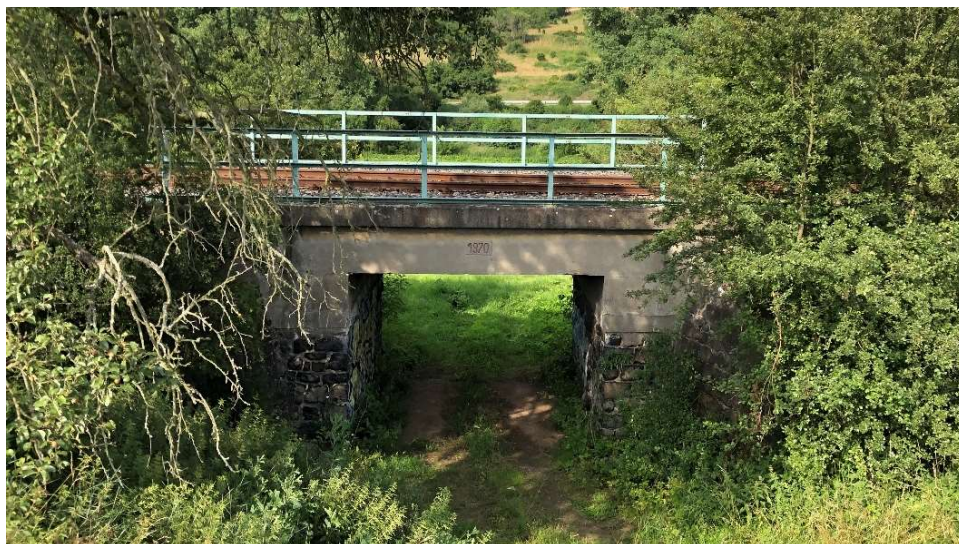
Obrázek 6: Železniční most s malou podjezdnou výškou
