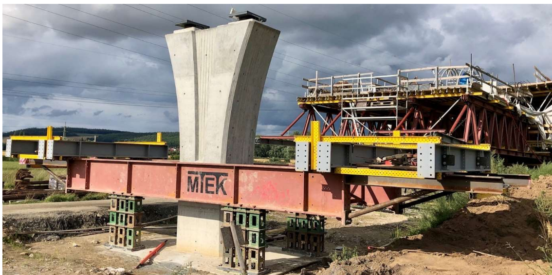
Obrázek 18: Detail výsuvné skruže a pilířové podpory
