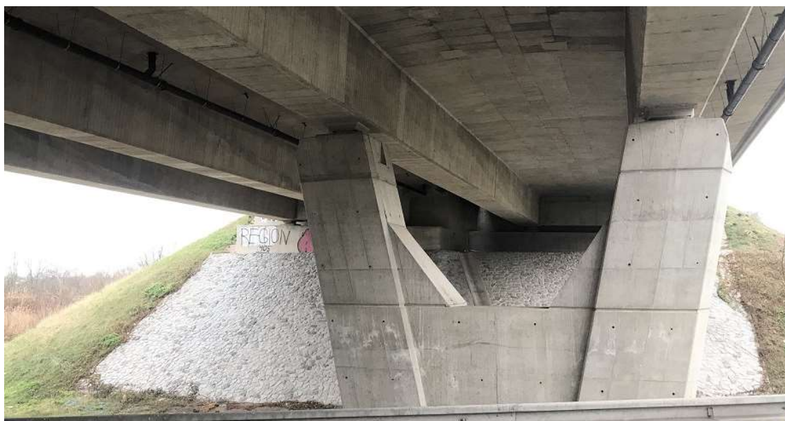
Obrázek 22: Pohled na rozdělenou opěru
