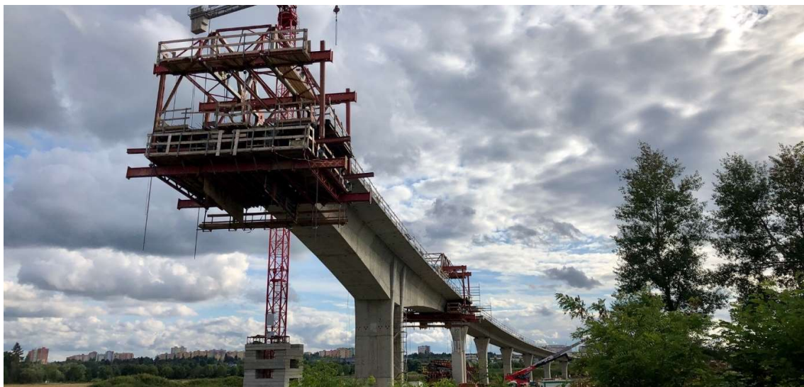
Obrázek 17: Fotografie vahadla letmé betonáže s napojením na jednostránový most
