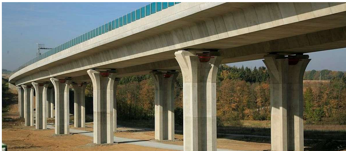
Obrázek 48: Most na obchvatu Plzně přes údolí řeky Úhlavy [21]
