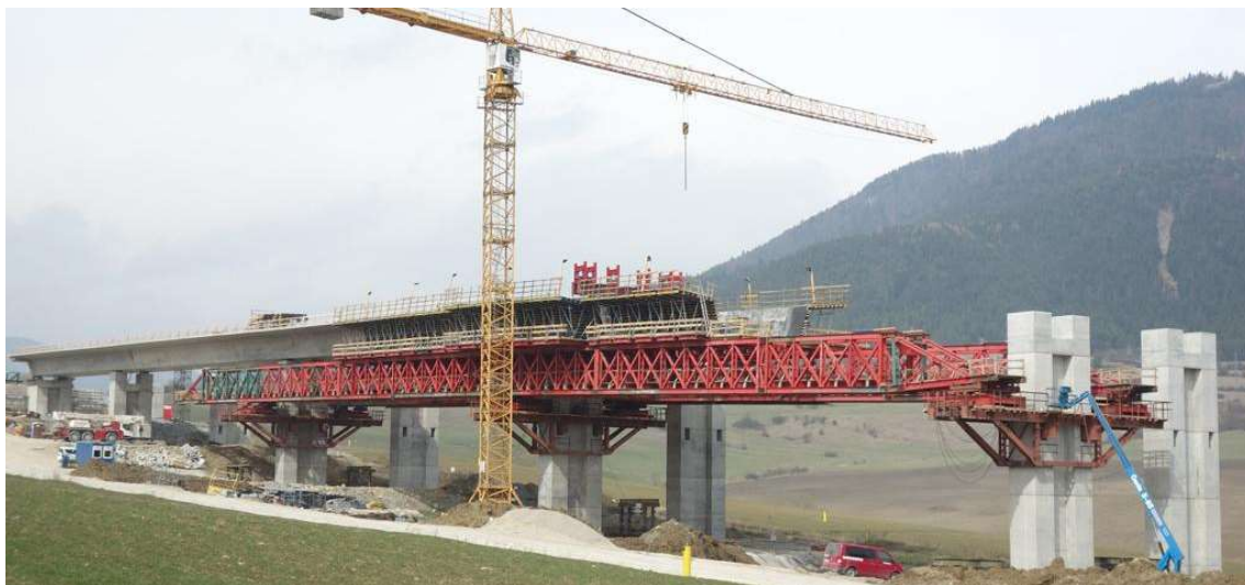
Obrázek 35: Pohled na skruž a pilířové vzpěry [11]
