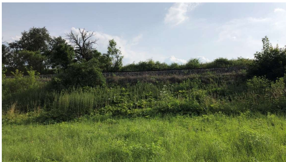
Obrázek 7: Pohled na strmý svah tělesa železniční trati
