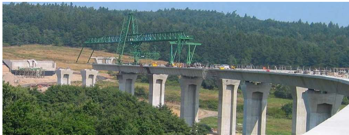
Obrázek 47: Most na silnici I/7 během výstavby letmou montáží [18]
