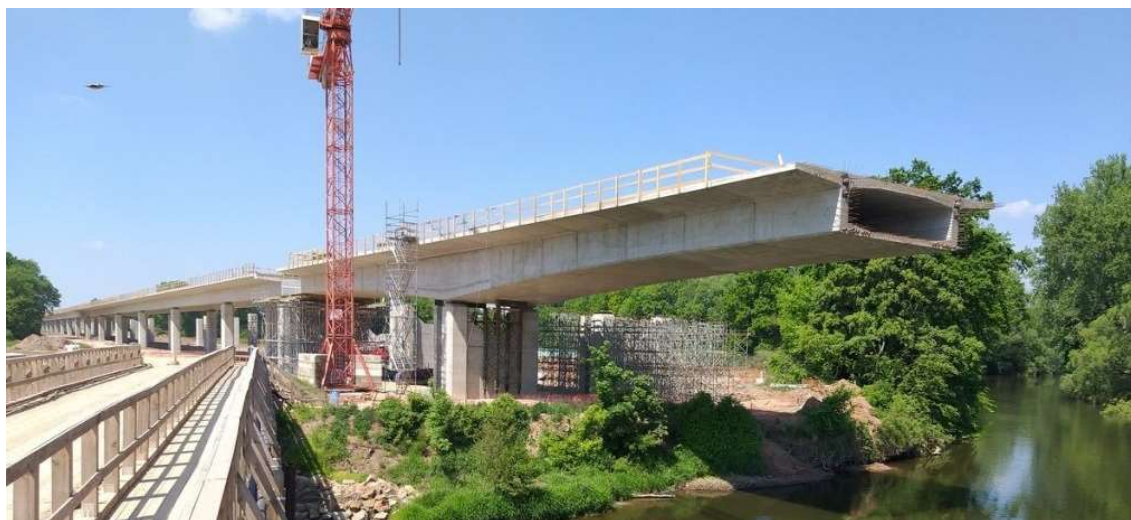
Obrázek 25: Výstavba vahadla mostu u Opatovic nad Labem [6]
