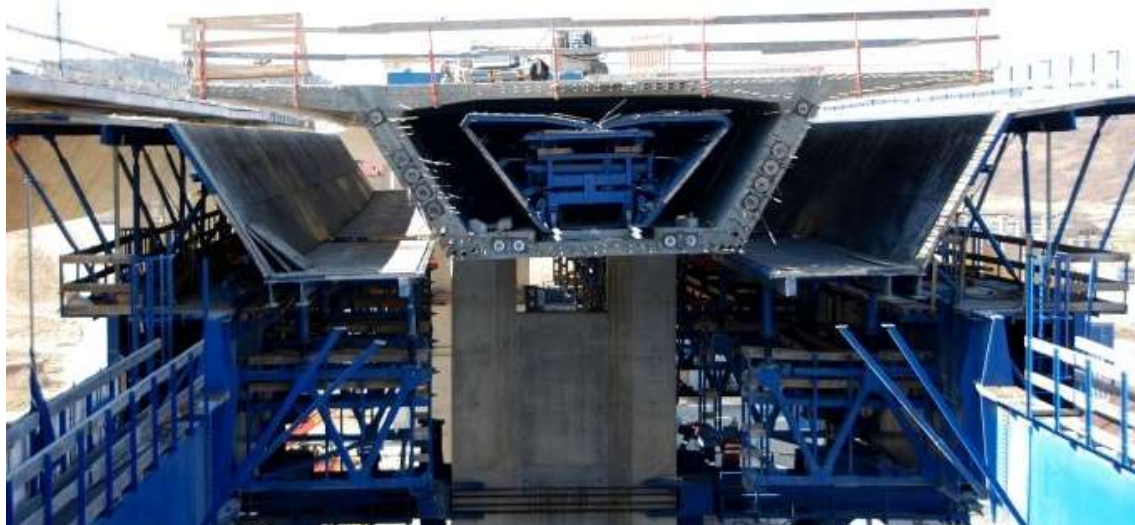
Obrázek 28: Detailní pohled na pracovní spáru a teleskopické bednění komory [8]
