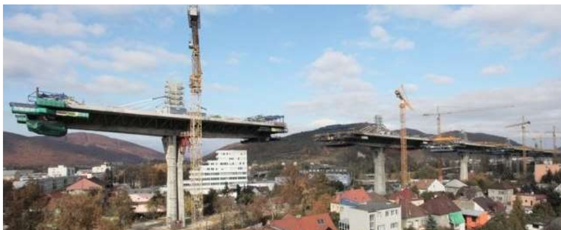
Obrázek 58: Městská estakáda v Povážské Bystrici během výstavby vahadel [27]
