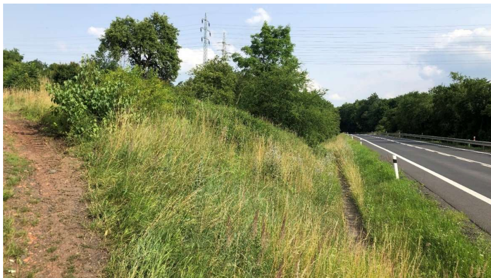
Obrázek 3: Pohled na silnici I/8 a svah k ústecké opěře
