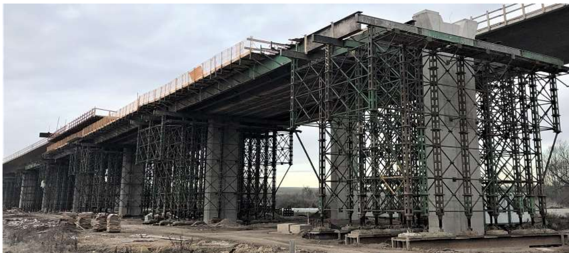
Obrázek 13: Pevná skruž mostu v Trotině
