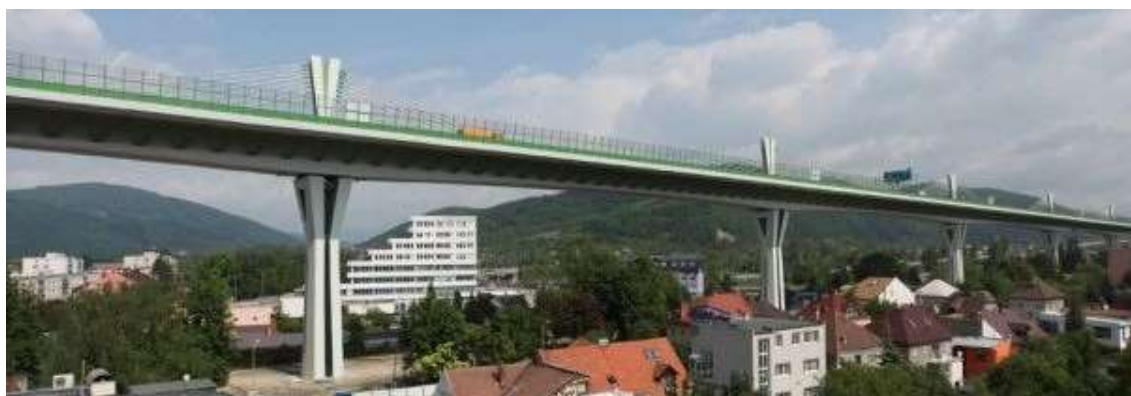
Obrázek 57: Pohled na dokončený extradosed most [27]
