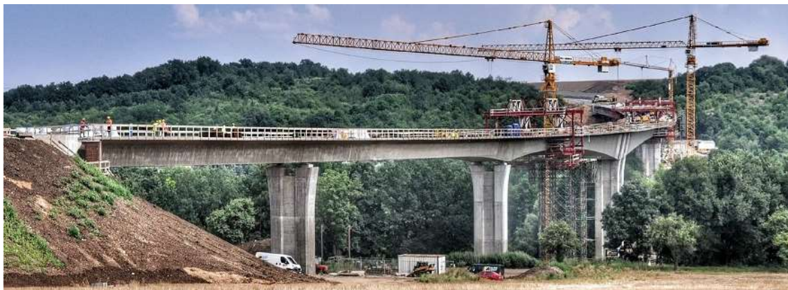
Obrázek 55: Most Velemyšleves během výstavby vahadel [26]
