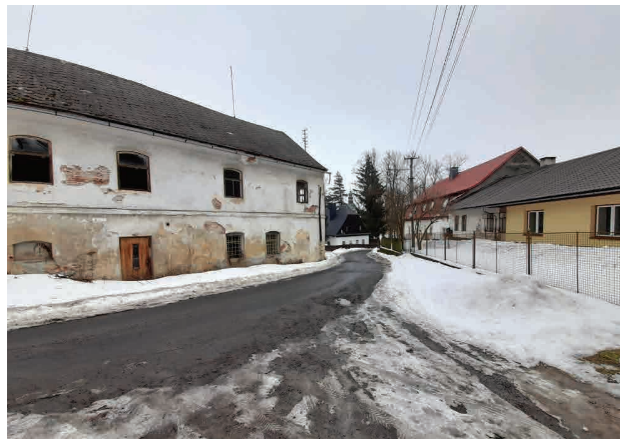
Ulice Sklepní pohled směrem k zámku
