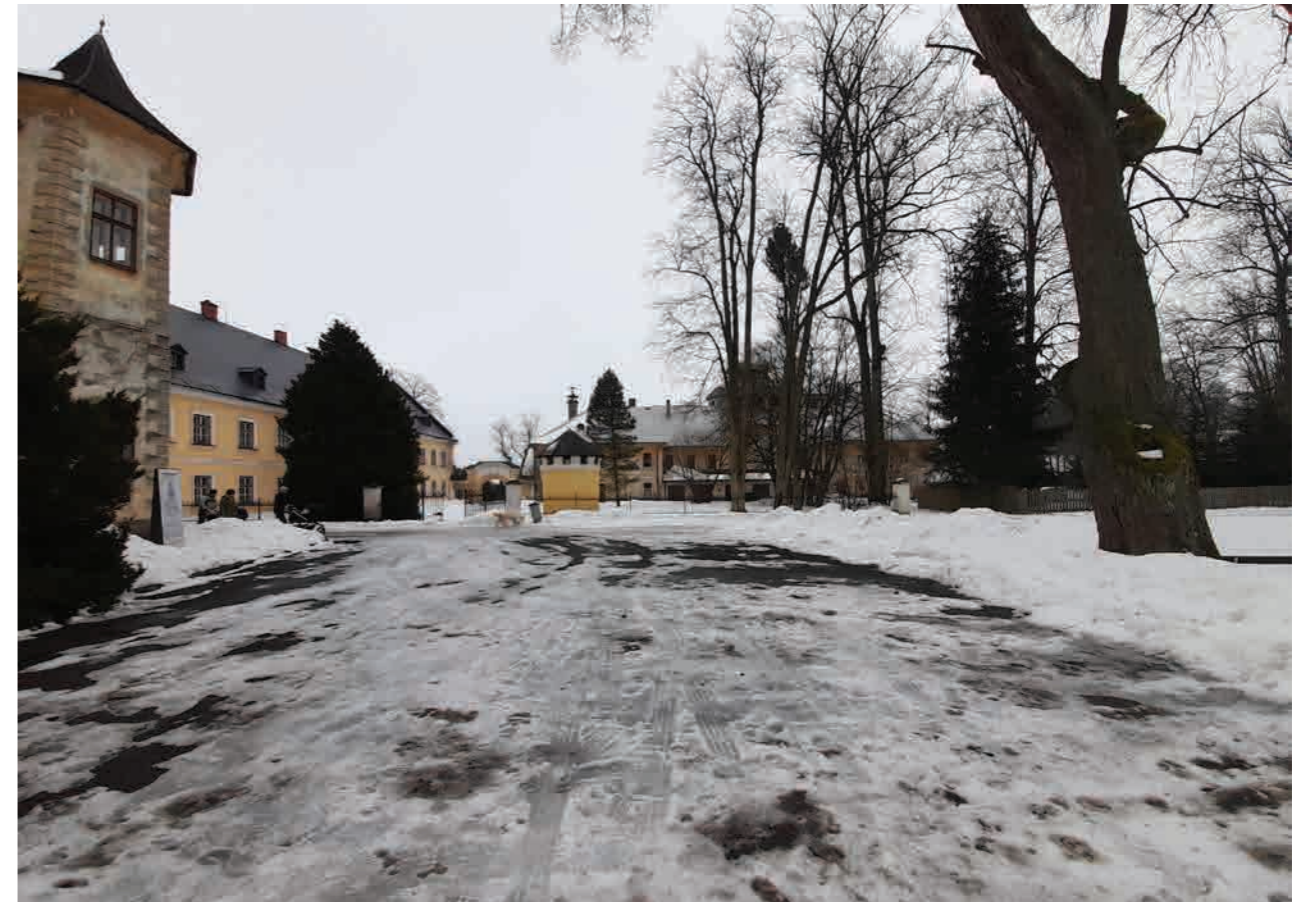
Pohled z nádvoří zámku na západní fasádu pivovaru, budovu ředitelství a bránu
