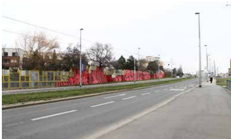
Pohled na protihlukovou stěnu při příjezdu do města směrem od západu-letiště.
