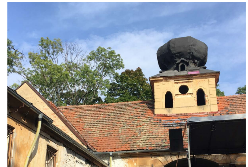
(23) Stav 2021 - objekt B východní křídlo, věž vlastní fotografie
