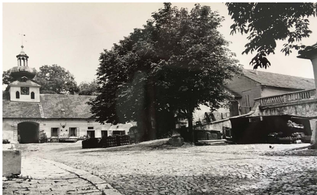
(2) pohled na východní křídlo a východní přístavěnou stodolu dobová fotografie - archiv NPÚ v Praze
