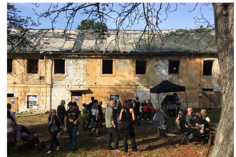
(24) Stav 2021 - objekt B severní křídlo vlastní fotografie
