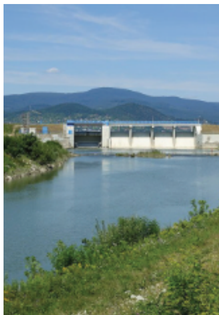
Zemplínska šírava a jej výpustný kanál.
