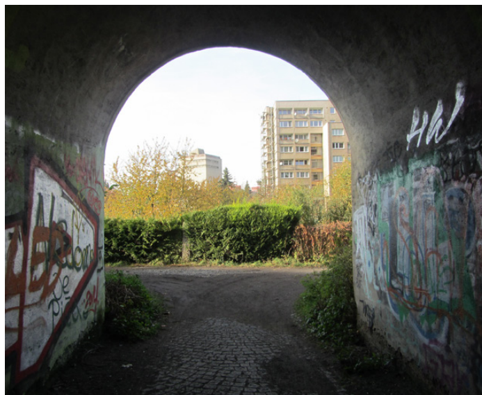
východný priestup pod železničnou traťou
