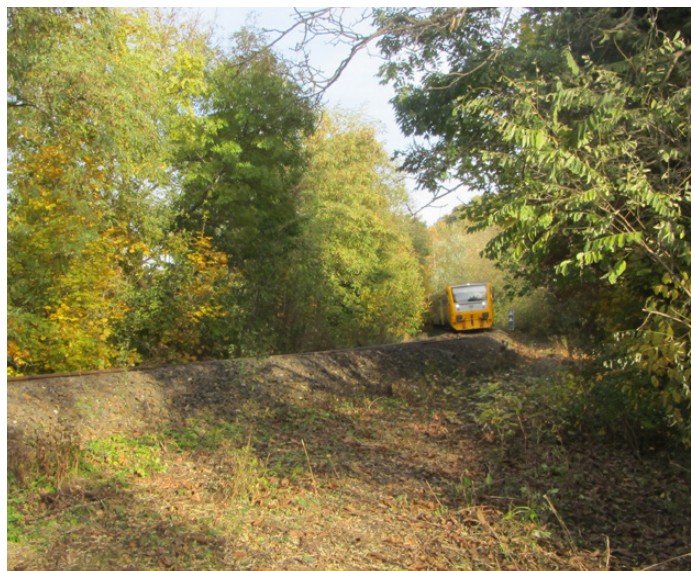
železničná trať v mieste nájazdu na viadukt
