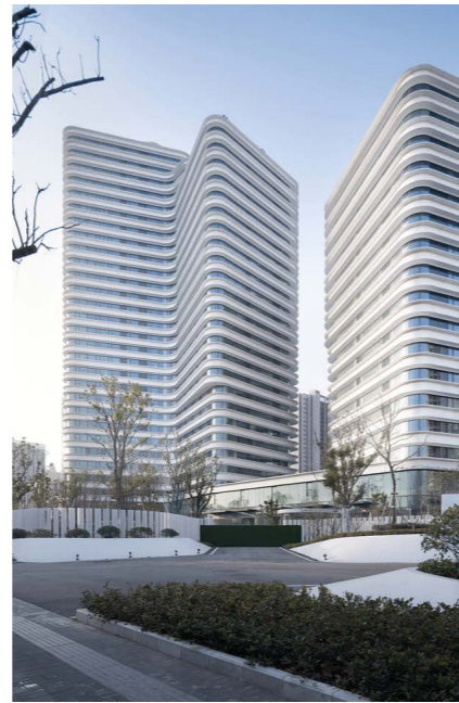
Výšková rezidenční budova / Baumschlager Eberle Architekten
