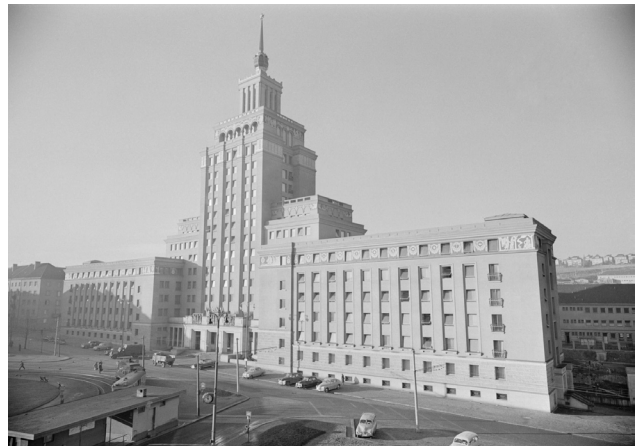
Hotel International. Stavba z let 1952–1956 je jednou z nejtypičtějších ukázek socialistického realismu v Praze.
