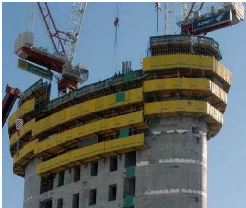
obr. 13 Pohled na výstavbu [7]
