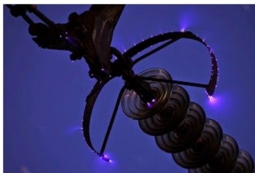
(b) Korónový výboj na přenosovém vedení [29].
