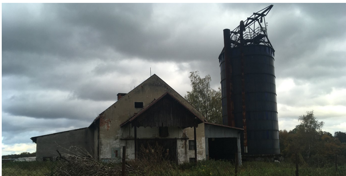
Obrázek 11: Budova na parcele č. 1407/2. [zdroj: autor]
