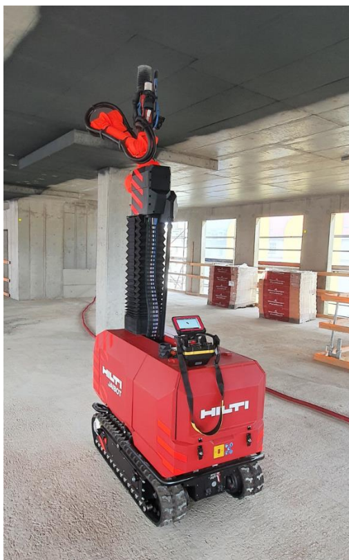
Obrázek č.8 – Ilustrace k příkladu použití stavebních robotů – robot Hilti Jaibot [74]
