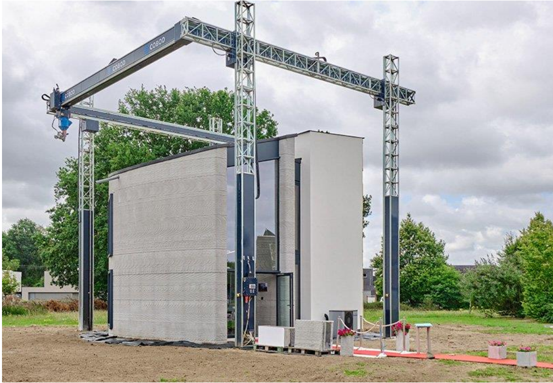
Obrázek č.7 – Ilustrace k příkladu použití stavebních robotů – 3D tisk dvoupatrového domu [75]
