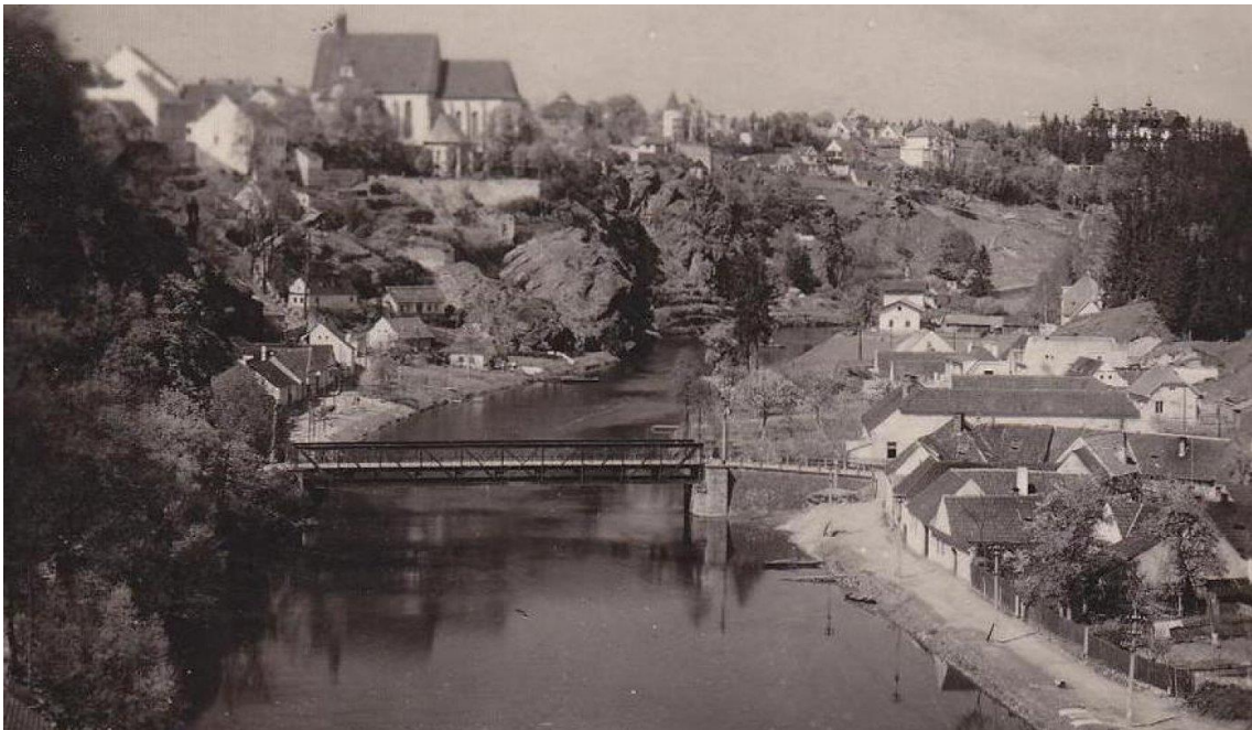
Obr. 1: Ocelový most přes řeku Lužnici v Bechyni - Zářečí [4]
