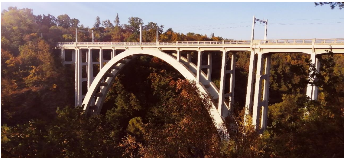
Obr. 4: Pohled na sružený obloukový železobetonový most v Bechyni
