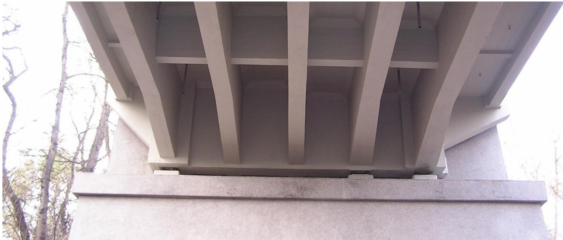
Obr. 6: Uložení mostovky na krajní opěru [1]
