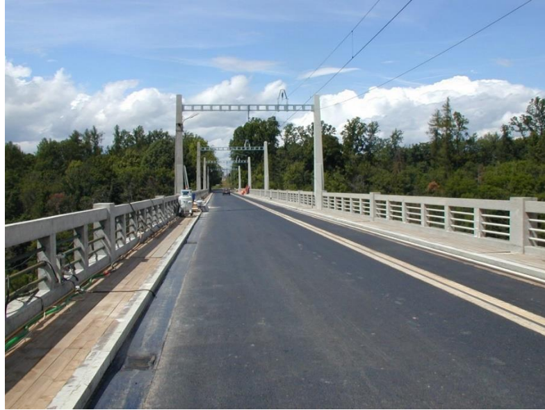
Obr. 8: Pohled na nově zrekonstruované vozovkové vrstvy [1]
