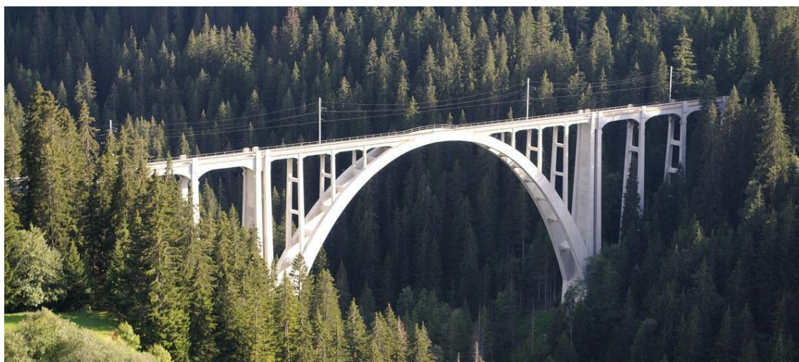
Obr. 3: Obloukový železobetonový most v Langwies ve Švýcarsku [6]
