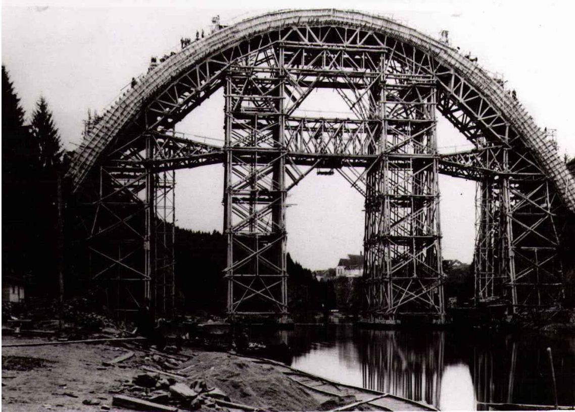
Obr. 7: Pohled na dřevěnou skruž obloukových pasů [8]
