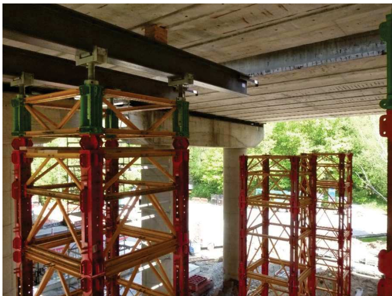
Obrázek 19 Těžká skruž s využitím vysokopevnostních věží VST
