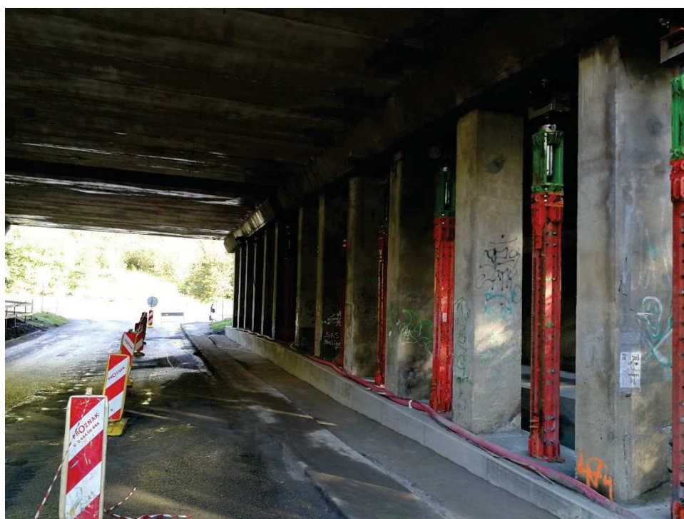
Obrázek 33 Podepření stativ na mostě D5-016 [16]
