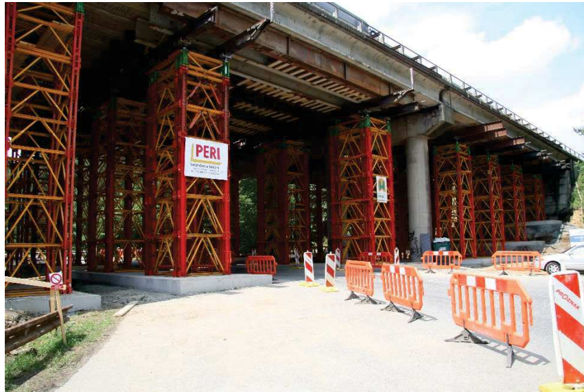
Obrázek 27 Most D1-035 po podepření [23]
