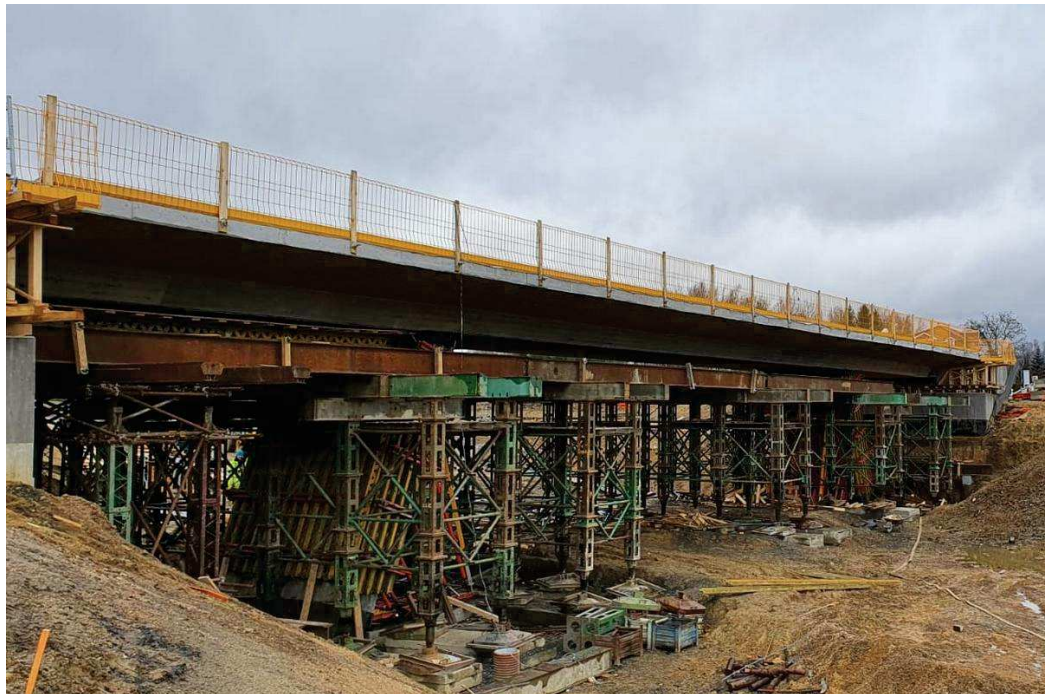
Obrázek 18 Podepěrná konstrukce těžké skruže PIŽMO [23]
