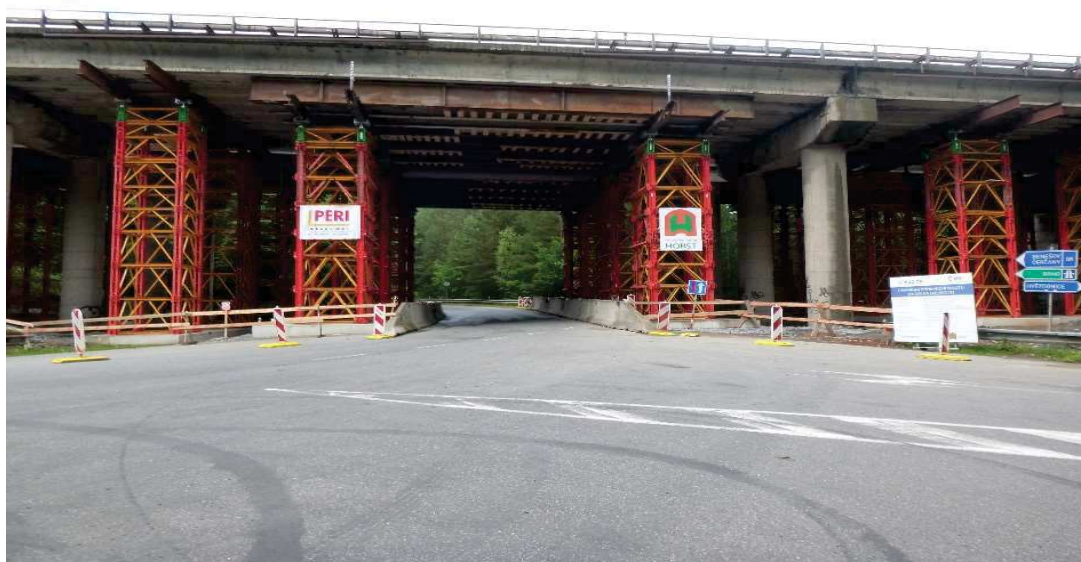
Obrázek 11 Podepření mostu D1-035 Hvězdonice [23]
