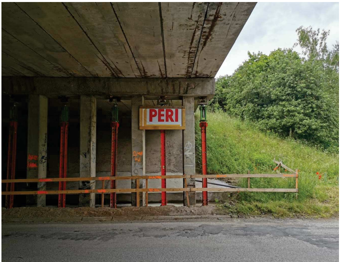
Obrázek 34 Podepření stativa v pohledu na mostě D5-016 [16]
