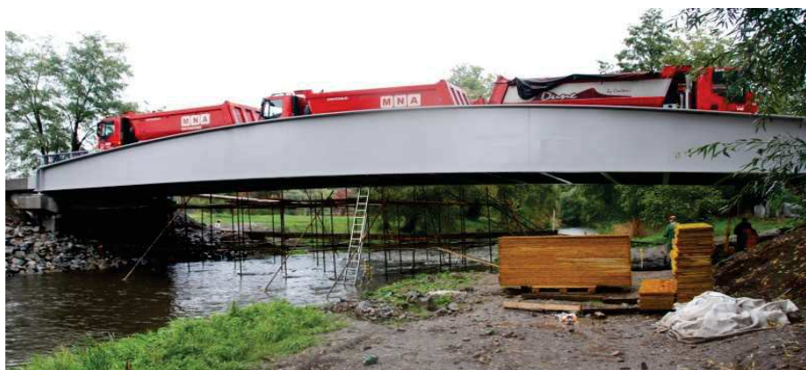
Obrázek 5 Příklad statické zatěžovací zkoušky mostu [21]
