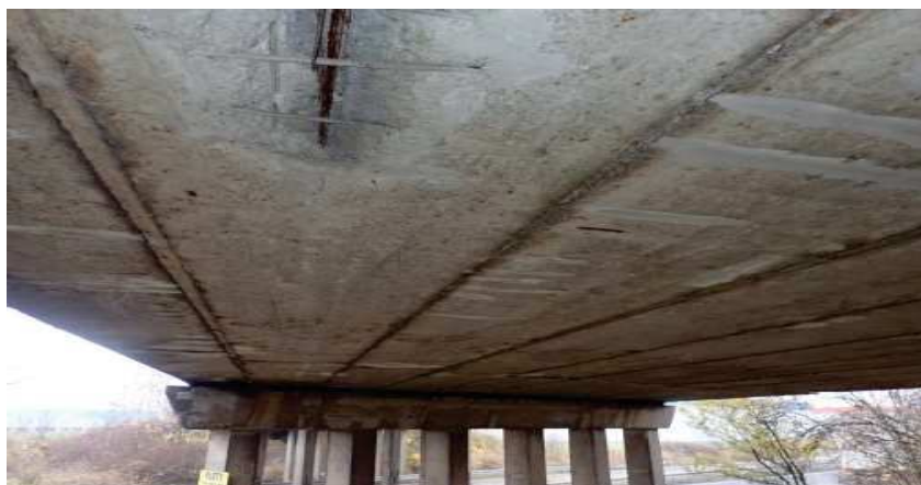
Obrázek 40 Pohled na nosnou konstrukci v poli č. 1 [18]
