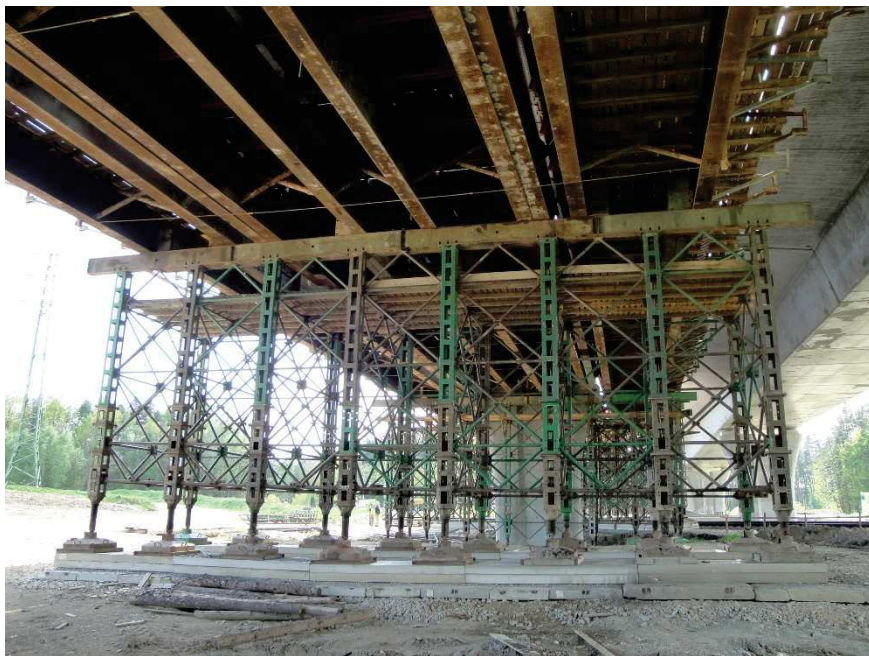
Obrázek 12 Podepření skruž PIŽMO [24]
