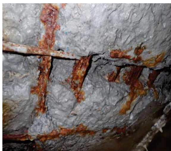
Obrázek 45 a) pohled na opěru č. 2 – zatékání vody přes MDZ, b) obnažená a degradující předpínací výztuž a konstrukční výztuž včetně degradace betonu [18]
