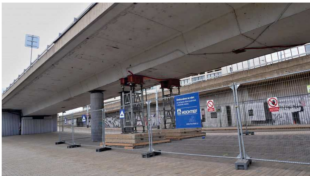
Obrázek 30 Podepření mostu X22 pomocí věží s nosníky [14]
