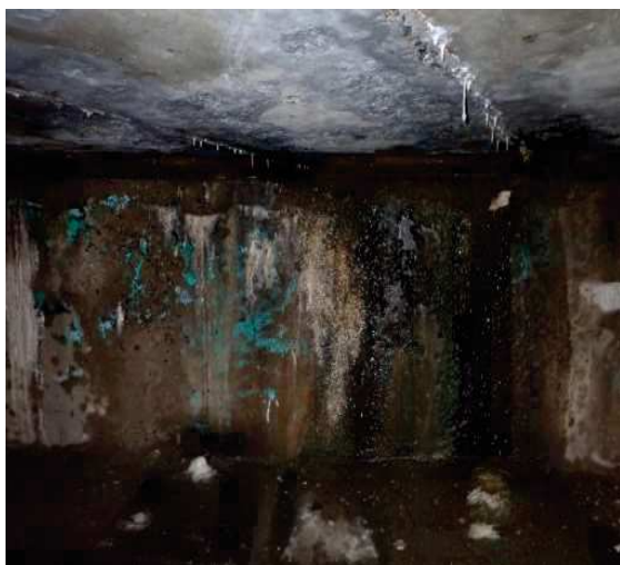
Obrázek 45 a) pohled na opěru č. 2 – zatékání vody přes MDZ, b) obnažená a degradující předpínací výztuž a konstrukční výztuž včetně degradace betonu [18]
