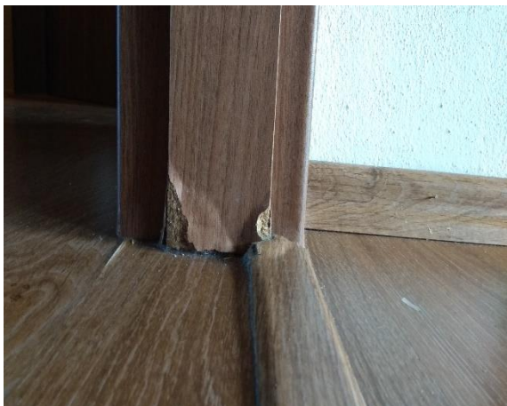
Obrázek 15: Poškození zárubně a)
