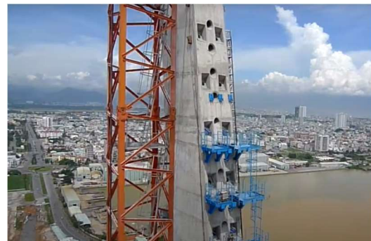
Obrázek 16 Pylon s kabely (8)
