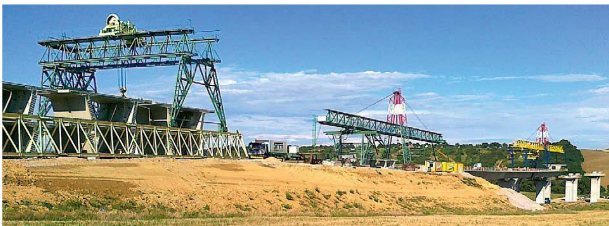
Obr. 24 Most přes Kadaňský potok na R1: Nasazení dvou jeřábu MS1 [15]
