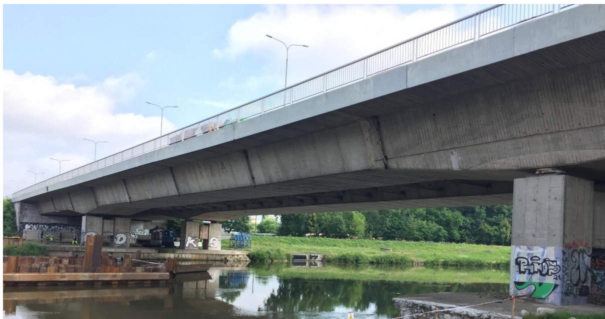
Obr. 35 Pohled na most
