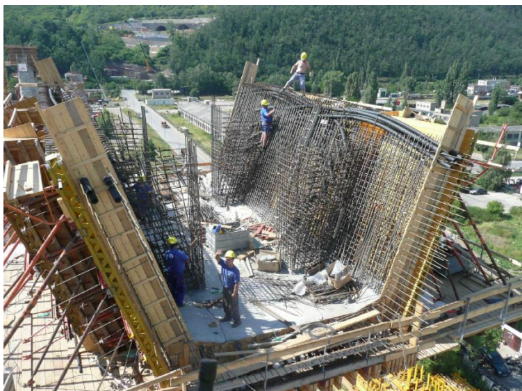
Obr. 55 Zárodek před vybetonováním [7]
