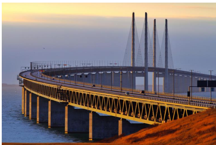
Obrázek 15: Dvoupatrová příhradová konstrukce mostu.
