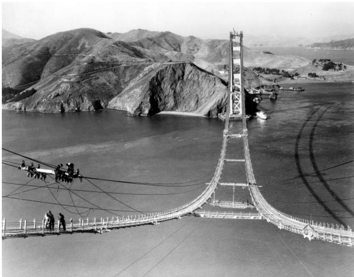
Obrázek 3: Technologie výstavby visutého mostu.
