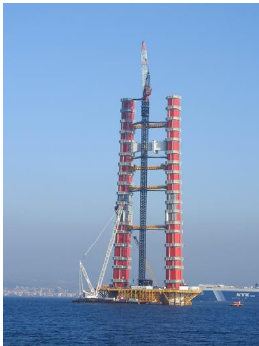
Obrázek 7: Realizace pylonů ve vodě. Poskytnuto doc. Ing. Romanem Šafářem, Ph.D.
