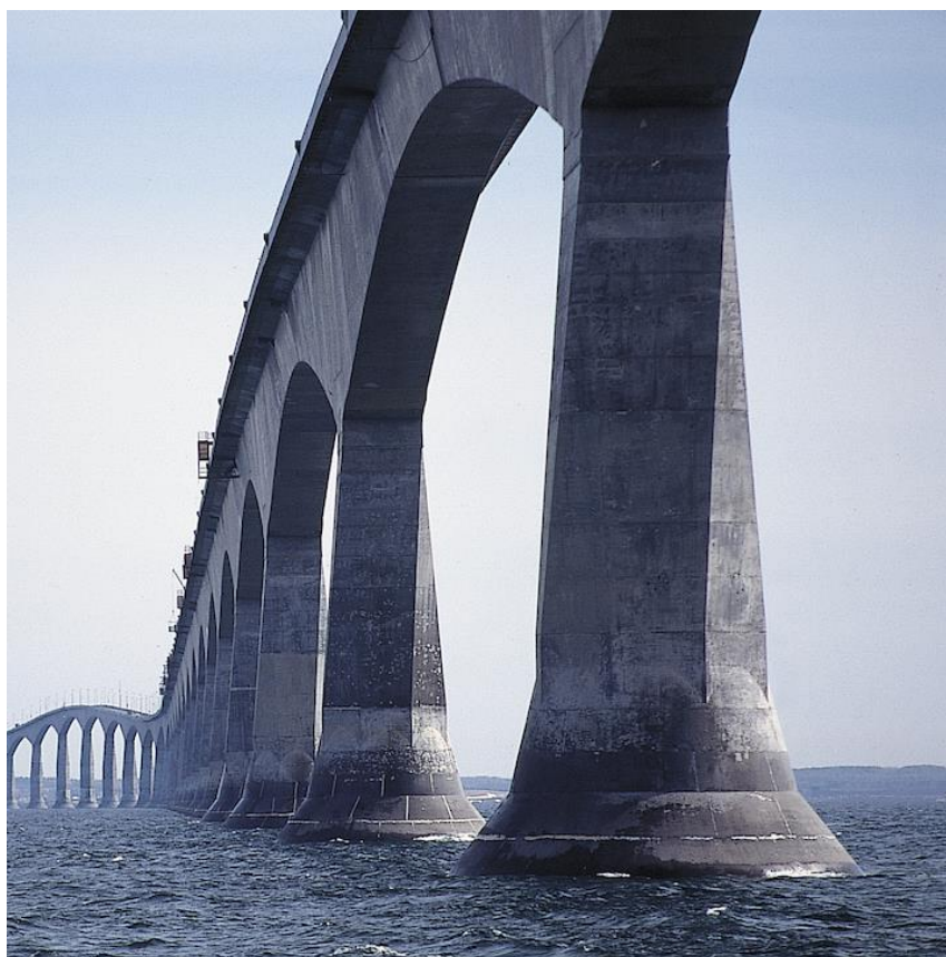
Obrázek 14: Pole mostu umožňující proplutí lodní dopravě. [5]
