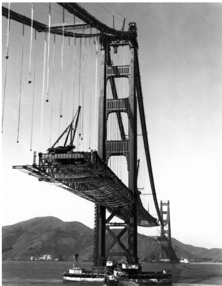
Obrázek 1: Výstavba Golden Gate Bridge.
