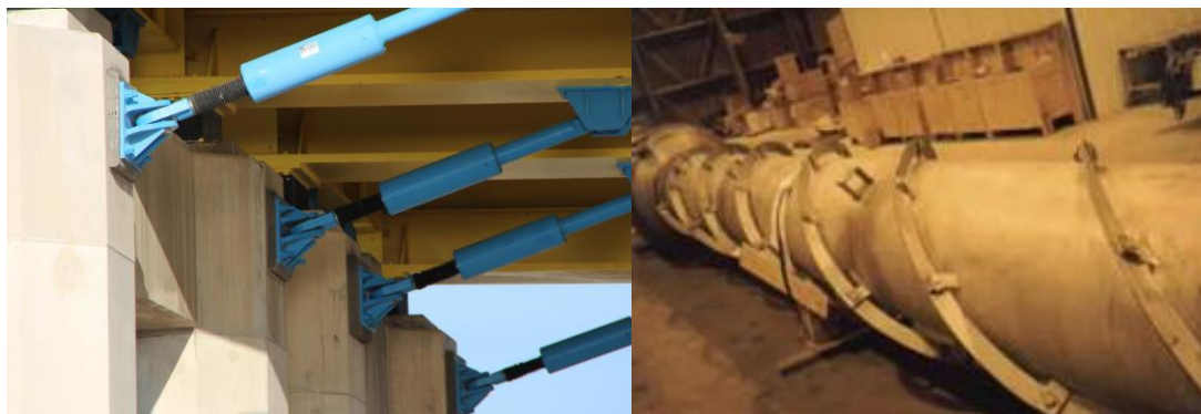
Obrázek 11: Tlumič na mostovce a spirálový kabelový kryt.
