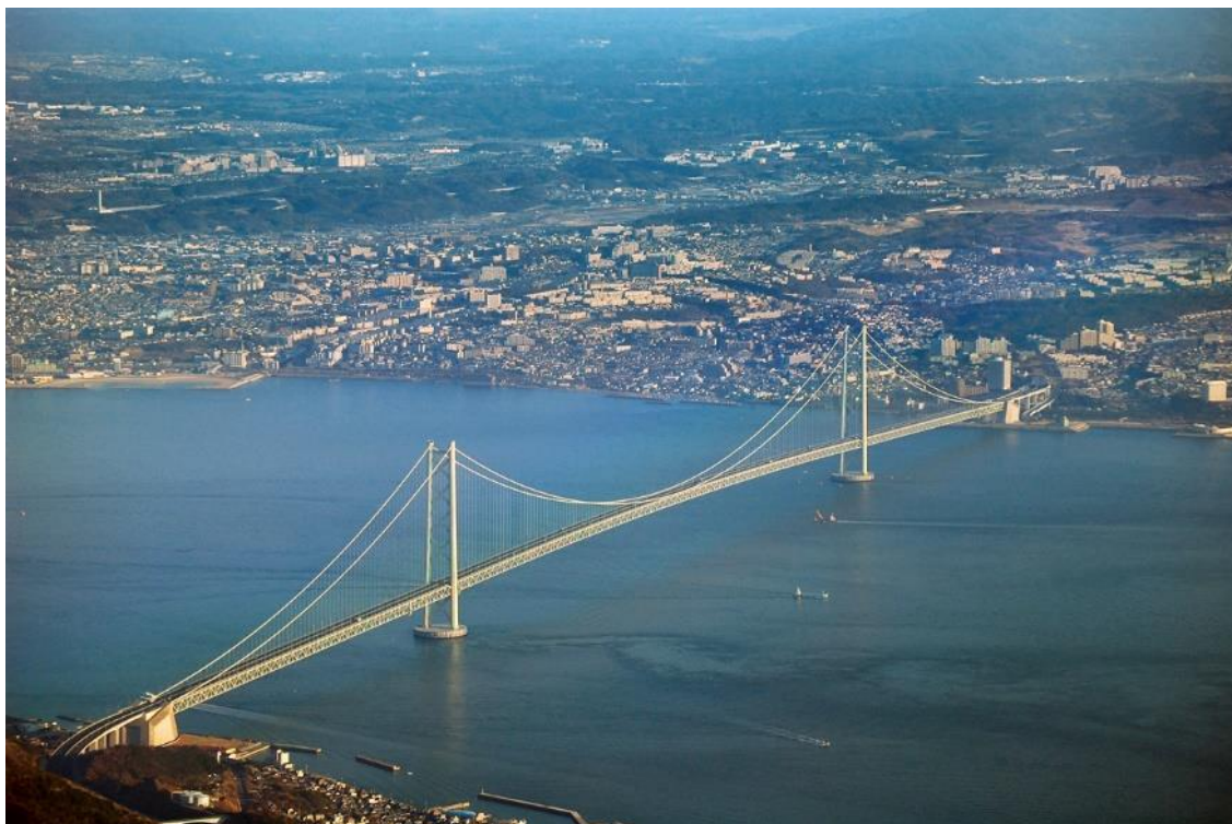
Obrázek 5: Akashi Kaikyo Bridge.
