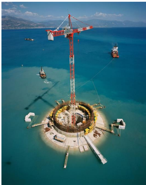
Obrázek 10: Zakládání pylonů v Korintském zálivu.
