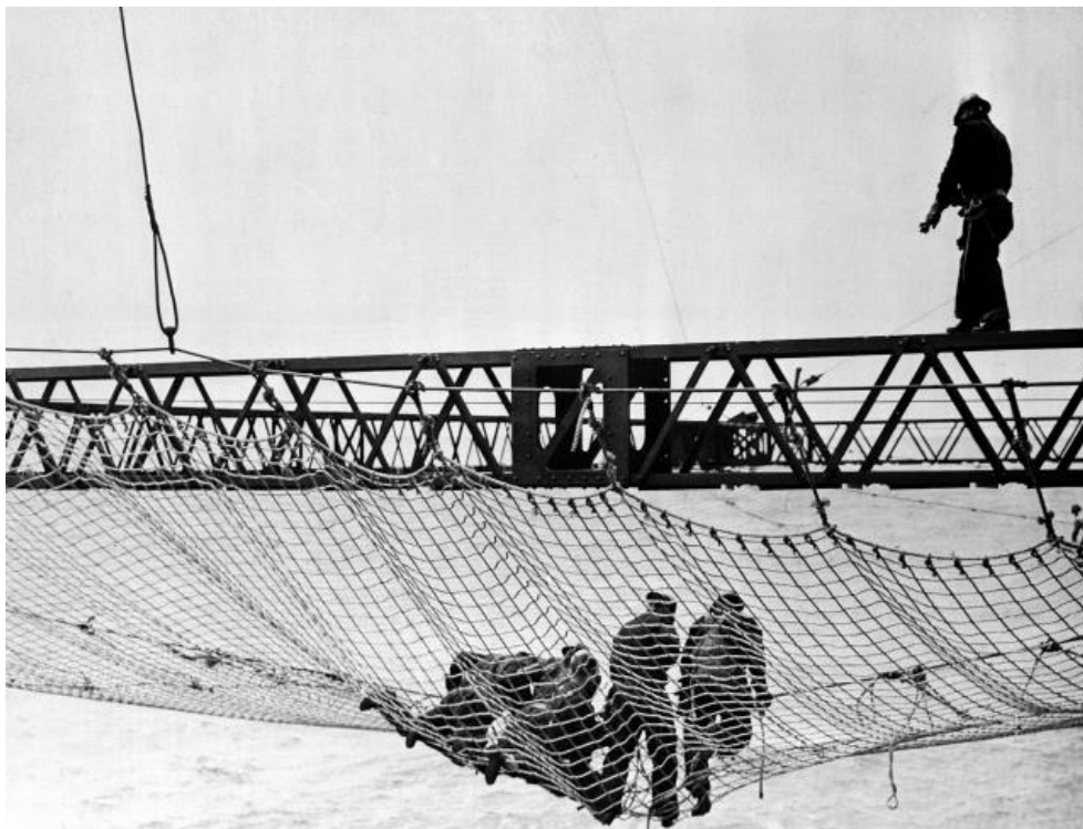
Obrázek 2: Bezpečnostní síť během realizace.
