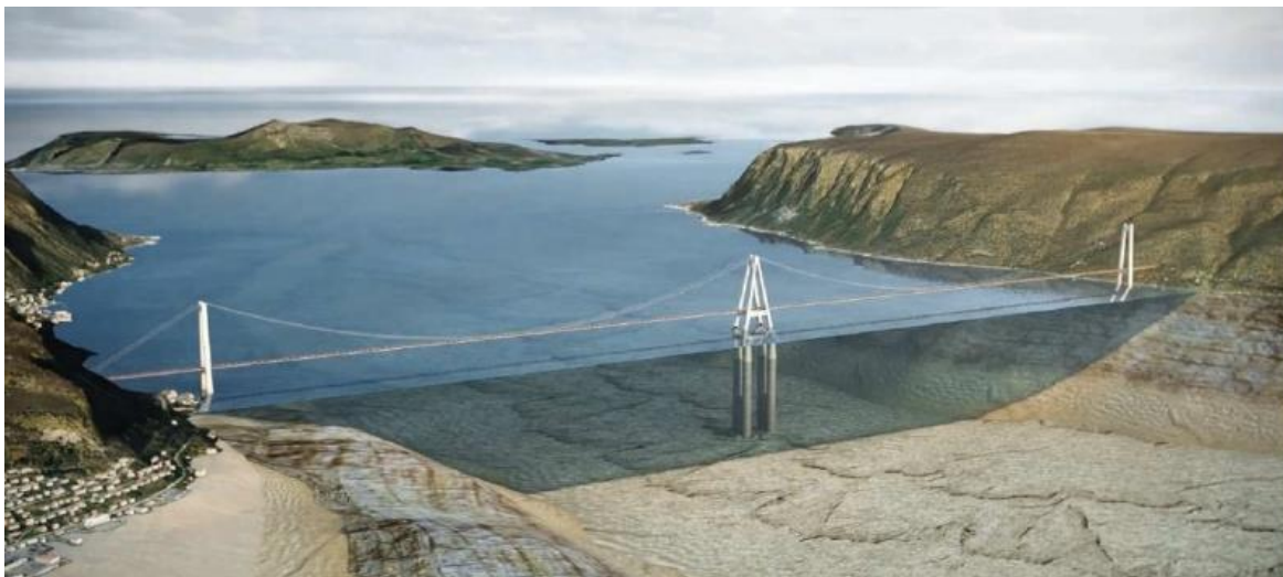
Obrázek 25: Visutý most v Norsku, hypotetické zakládání v extrémních hloubkách.
