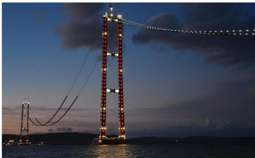
Obrázek 8: Montážní lávky pro následnou realizaci visuté mostovky. [2]
