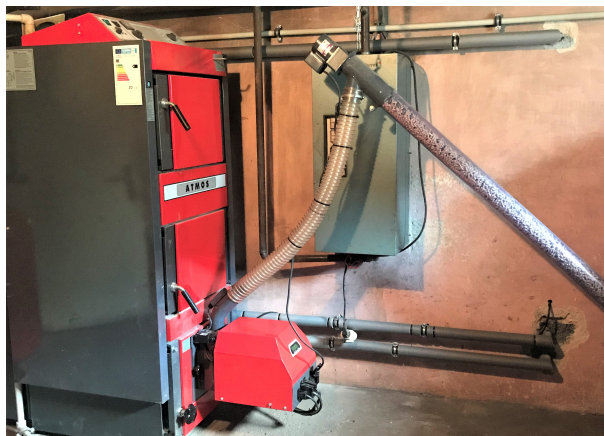
Obrázek 14: Kotel na pelety s automatickým podavačem
