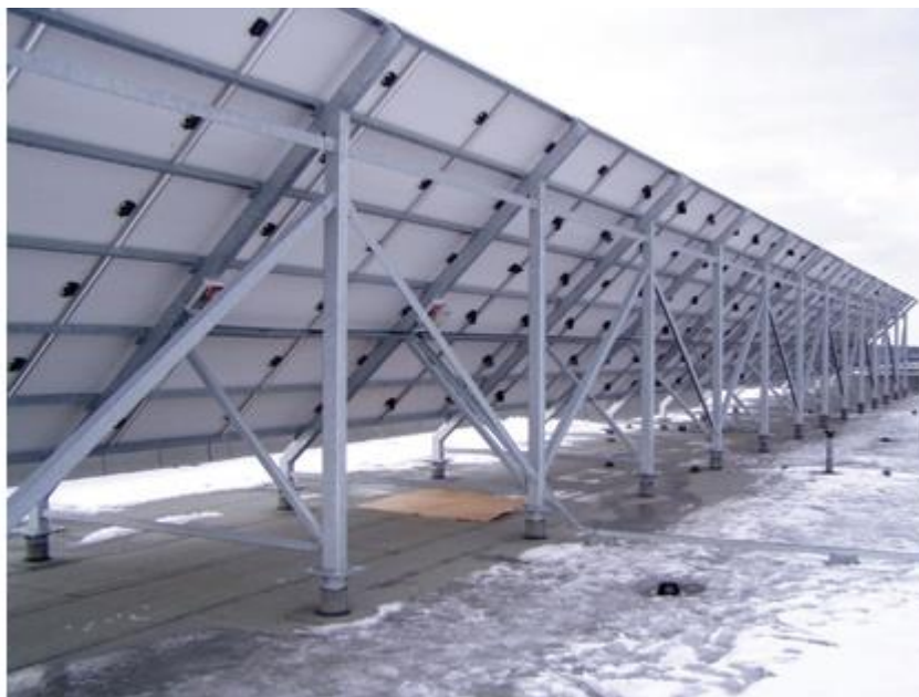
Obrázek 2.5 – Příklad střešní nosné konstrukce s přímým kotvením 25
