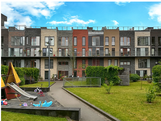
Obr. 46 Hlavní fasády townhousů orientované směrem do vnitrobloku (front) – Sluseholmen, Kodaň (Zdroj: autor Erik Petrus)
