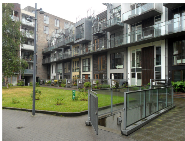
Obr. 88 Výstup ze společné podzemní garáže umístěný ve vnitrobloku – Sluseholmen, Kodaň (Zdroj: autor Erik Petrus)
