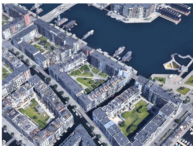
Obr. 54 Townhousy umístěné mezi vyšší bytové domy po stranách – Sluseholmen, Kodaň (Zdroj: www.google.com/maps/ )
