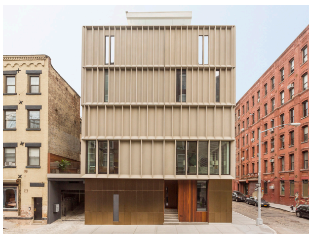
Obr. 85 Sdílená garáž integrovaná v podnoží townhousů – USA (Zdroj: Cameron Blaylock, www.archdaily.com )
