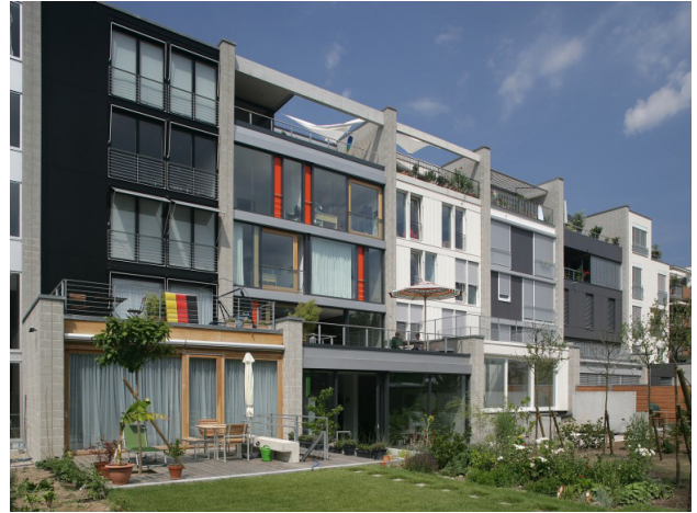
Obr. 96 Skupinová výstavba – Paul-Ehrlich Strasse, Karlsruhe (Zdroj: Stephan Baumann, Andreas Keller, www.heinze.de )
