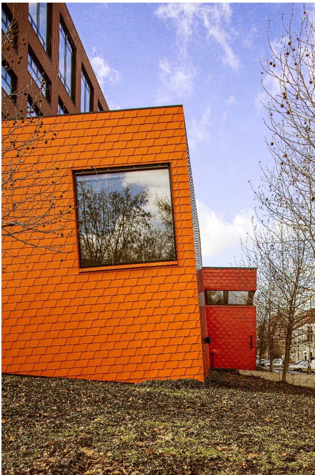
5. Fotografie budovy FA ČVUT arch. Aleny Šrámková, Praha. Fotografie: Václav Šedý, 2017
