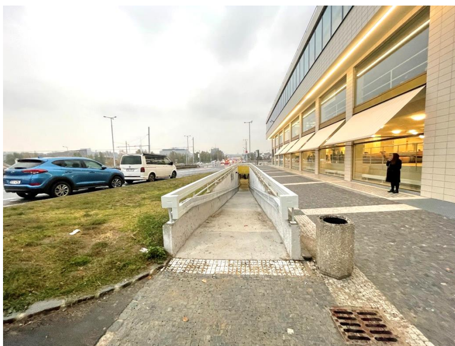
Obrázek 38 Nájezdová rampa do podchodů pod ulici Bubenská (1)
