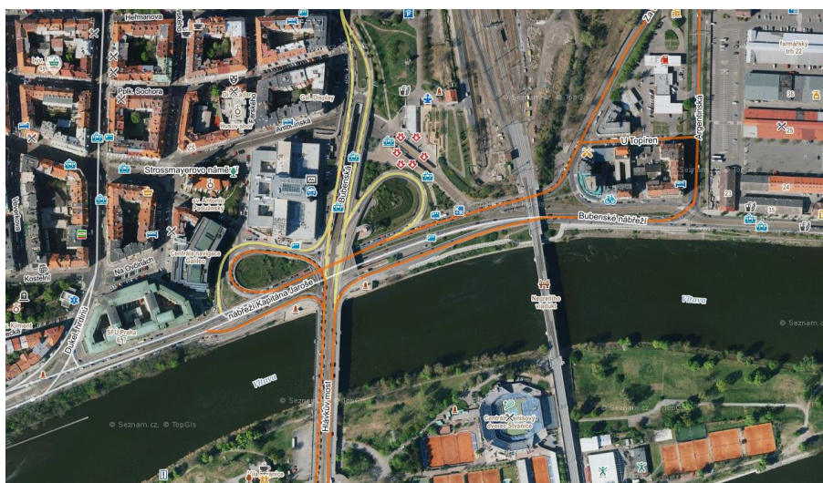
Obrázek 6 Oblast předpolí Hlávkova mostu
