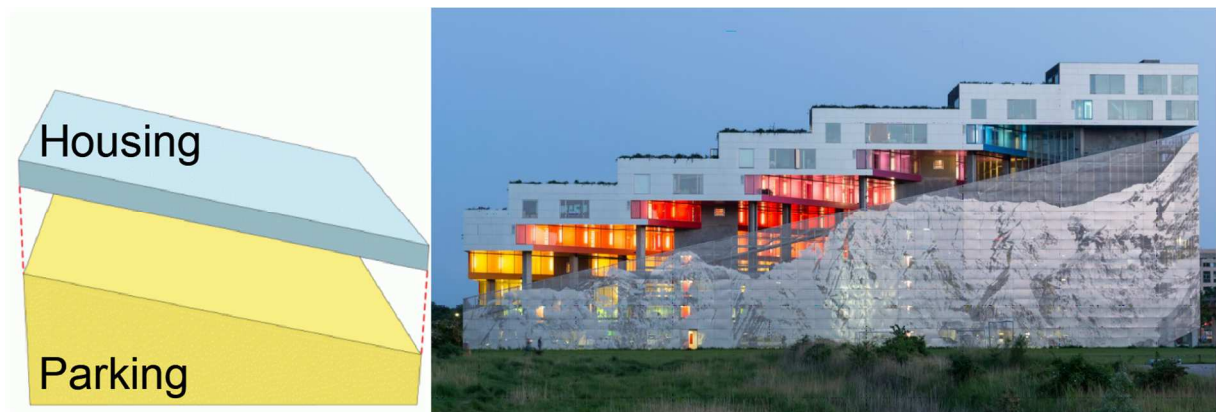
Obrázek 19: Bytový komplex The Mountain [39]
