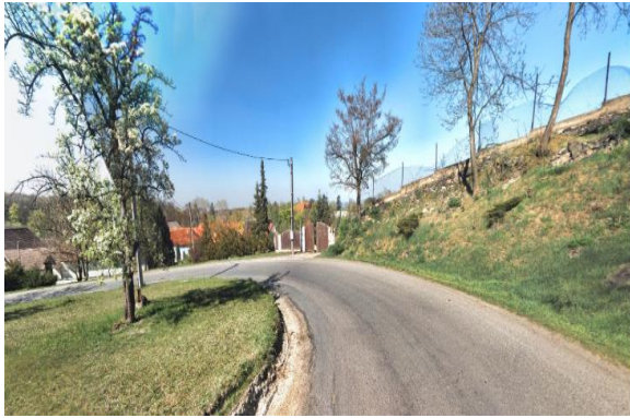
Obrázek 10 - obec Panenské Břežany, malý poloměr směrového oblouku (zdroj: Mapy.cz)
