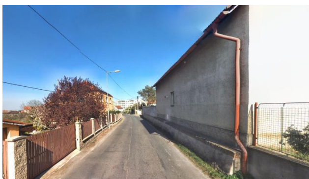
Obrázek 9 - objekty blízko vozovky, Odolena Voda (zdroj: Mapy.cz)
