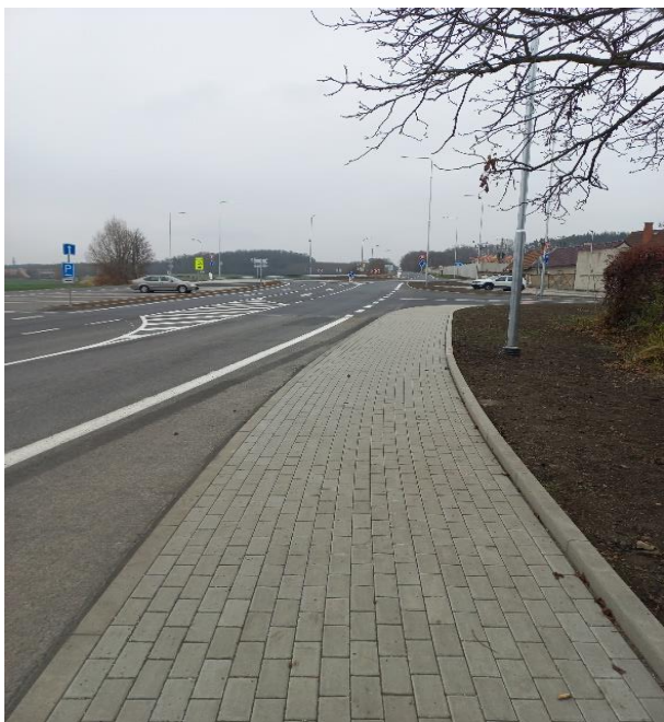
Obrázek 18 - obec Postřižín, oprava VDZ a nové chodníkové plochy (zdroj: autor)
