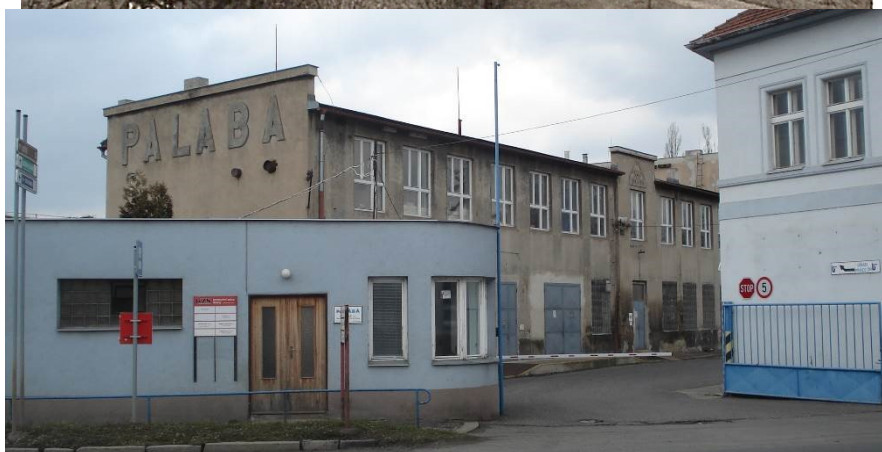
Obr. č. 92 Nahoře: zleva odzadu tovární budova ve tvaru obráceného „L“, vpředu vpravo na ni navazuje administrativní budova. Foto muselo vzniknout po roce 1928, kdy byla administrativní budova zvýšena o jedno patro. Uprostřed a dole radiobudova továrny Palaba ve 30. letech 20. století a roku 2016 v pohledu z Netovické ulice s vrátnicí. 523
