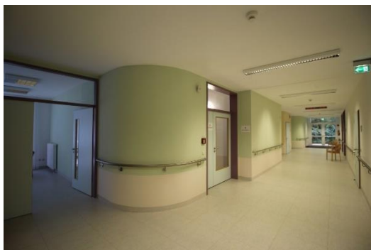
Obrázek 18: Oblý roh v místě změny směru chůze na hlavní chodbě (Waldklinik, Bernburg GmbH).
