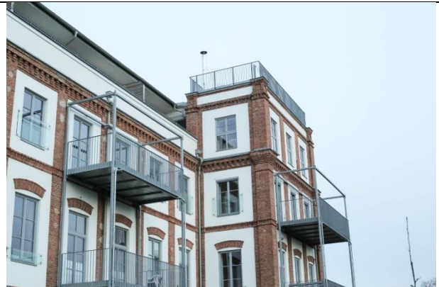
Obr. 186 Jihozápadní průčelí přádelny Oberwaltersdorf po rekonstrukci, zdroj: https://www.altbauneu.at/
