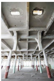
Obr. 153 Věšáky transmisi ve 2. NP, foto r. 2018, zdroj: archiv autora
