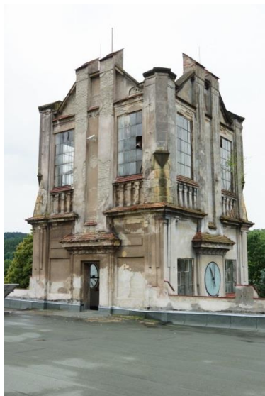
Obr. 134 Výstup na střechu z hlavního schodiště, nad stropem podesty je umístěna sprinklerová nádrž na vodu, zdroj: archiv autora
