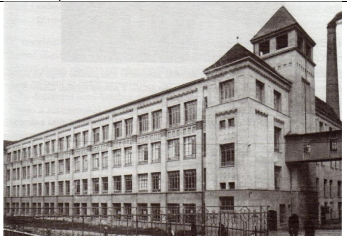
Obr. 113 Fotografie z roku 1909 po dokončení, z provozu, Tanvaldské p řádelny II, zdroj: Jaroslav Rýdl – Paměť Tanvaldska
