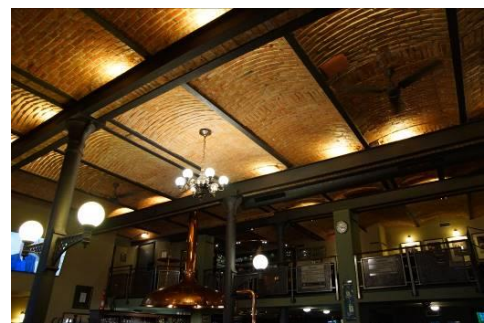
Obr. 19 Valené cihlové klenby na ocelocihlových průvlacích barevny Otto Stadler v Liberci; zdroj: archiv autora 11/2018
