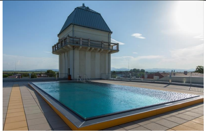
Obr. 184 Bazén přádelny bavlny Teesdorf, zdroj: https://www.altbauneu.at/
