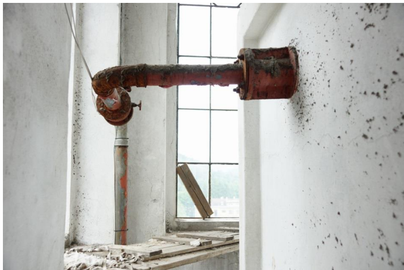
Obr. 135 Horní část věže, vpravo je sprinklerová nádrž, zdroj: archiv autora
