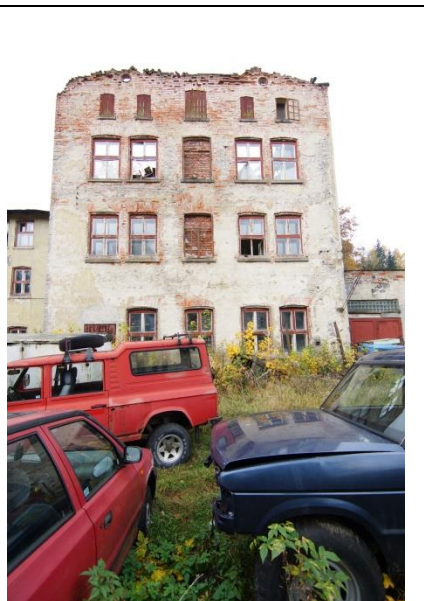
Obr. 42 Severovýchodní průčelí pravého křídla s částečně dochovaným štítem, foto 2016, zdroj: archiv autora
