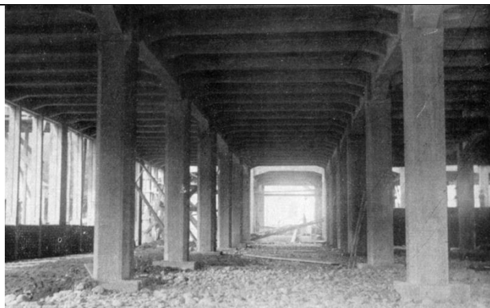
Obr. 175 Snímek vnitřní konstrukce z roku 1909, přádelny Františka Brůny v Plavech, zdroj: http://www.industrialnitopografie.cz/
