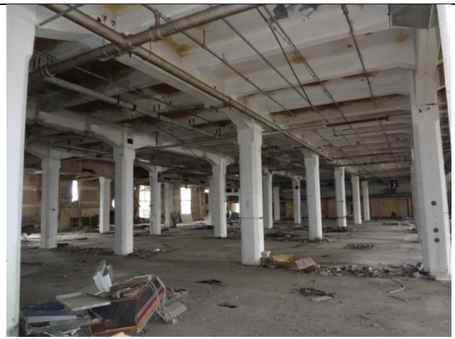
Obr. 178 Vnitřní nosná ŽB konstrukce přádelny bavlny Teesdorf, zdroj: https://www.altbauneu.at/
