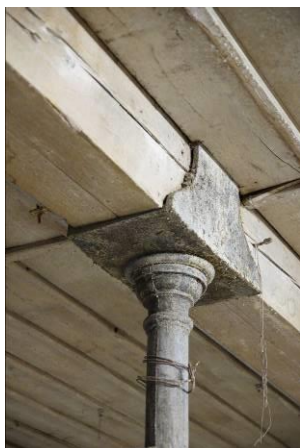
Obr. 5 Styk litinového sloupu s dřevěným průvlakem - tkalcovna Vincenc Mastný v Lomnici nad Popelkou; zdroj: archiv autora 11/2018
