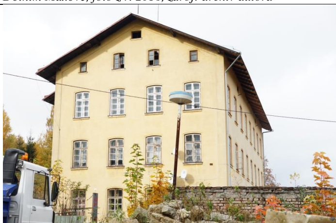
Obr. 41 Dům č.p. 148, zdroj: archiv autora
