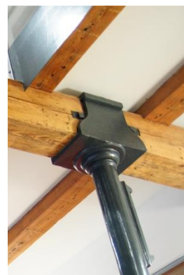
Obr. 4 Styk litinového sloupu s dřevěným průvlakem – přádelna Franze Franze Schmitta v Semilech; zdroj: archiv autora 11/2018
