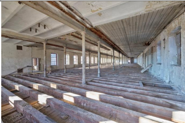
Obr. 185 Původní stav vnitřních konstrukcí továrny Oberwaltersdorf po rekonstrukci, zdroj: https://www.altbauneu.at/
