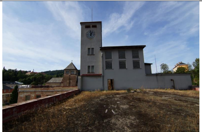
Obr. 100 Pohled ze střechy na prašnou a sprinklerovou věž Tanvaldské přádelny I, zdroj: archiv autora
