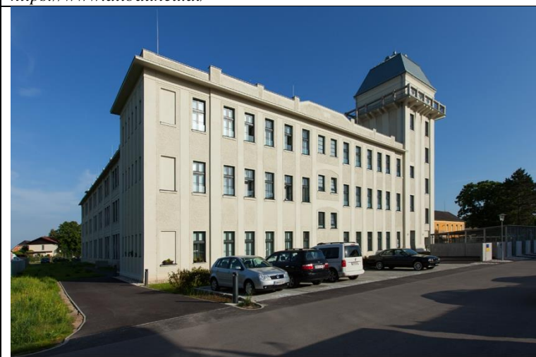
Obr. 181 Realizace přádelny bavlny Teesdorf, zdroj: https://www.altbauneu.at/
