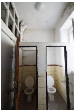
Obr. 136 Původní místnosti toalet, jihozápadní věž 1.NP, zdroj: archiv autora
