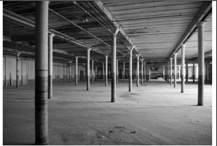
Obr. 196 Východní část z roku 1898 s litinovými sloupy a klenbami mezi nosníky přádelny Alten Spinnerei Kolbenmoor, zdroj: https://www.archilovers.com/ Quest Architekten GbR
