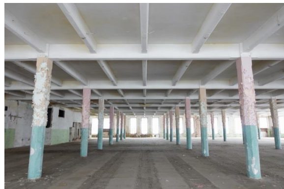
Obr. 150 Uložení trámů a průvleků v typickém podlaží (zde 3. NP), foceno východním směrem, zdroj: archiv autora
