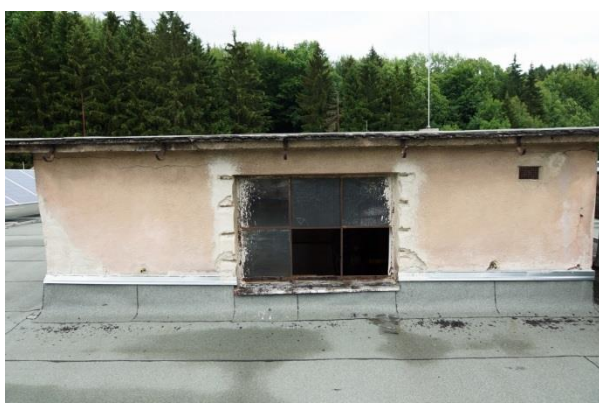
Obr. 132 Strojovna výtahu, střecha, zdroj: archiv autora
