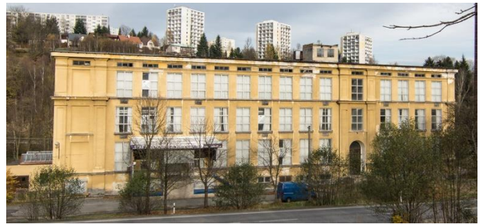
Obr. 64 JZ průčelí továrny Johann Priebse & dědiců z roku 2018, zdroj: archiv auto
