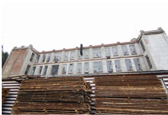
Obr. 143 Severní průčelí, se zděnou přístavbou s obložním, zdroj: archiv autora
