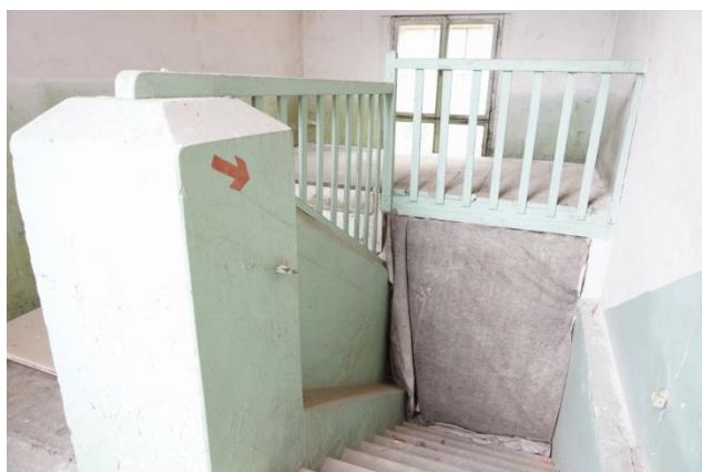
Obr. 138 Schodiště severovýchodní věže, 4. NP, zdroj: archiv autora
