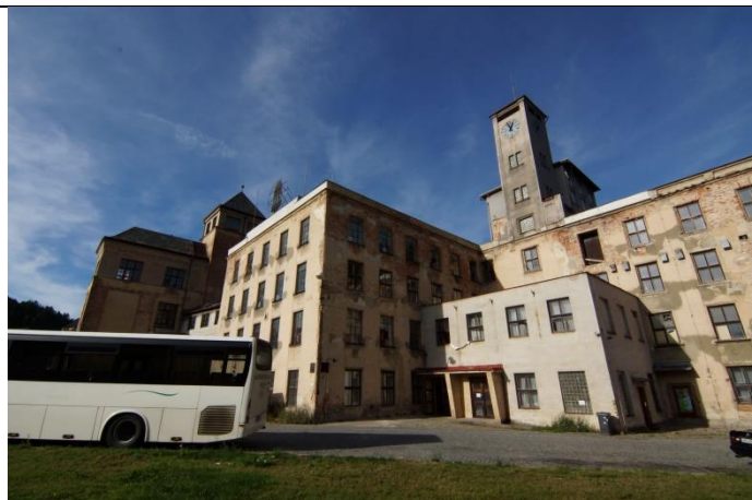
Obr. 90 Fotografie vstupu s prašnou věží z roku 2015 současný stav Tanvaldské přádelny I, zdroj: archiv autora
