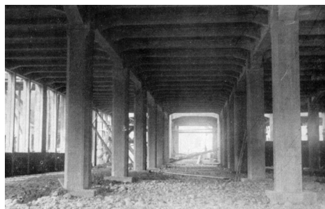
Obr. 8 ŽB konstrukce přádelny v Plavech F. Brůna; zdroj: archiv VCPD záznam V006703, foto 1908
