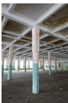
Obr. 9 ŽB konstrukce Liebigovy přádelny v Mezivodí; zdroj: archiv autora 7/2015
