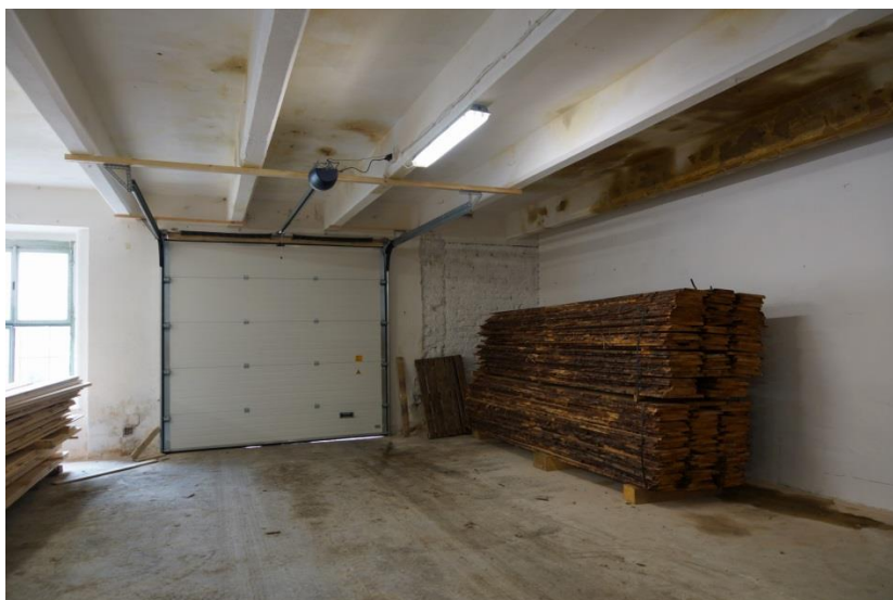
Obr. 152 Nová sekční vrata v 1. NP v jihovýchodní části velkého sálu, zdroj: archiv autora
