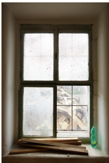
Obr. 151 Okno 1. NP jihovýchodní část, dnes garáže a sklad, zdroj: archiv autora
