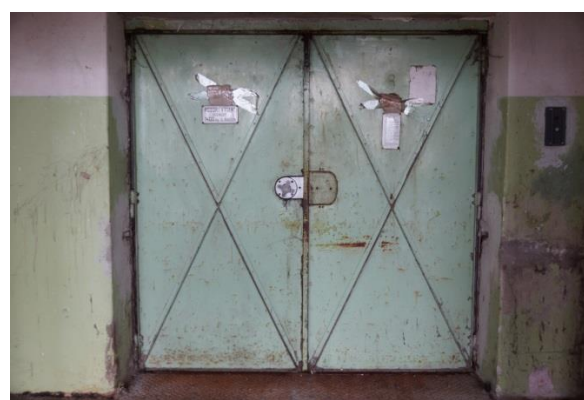
Obr. 131 Výtahová šachta 4. NP, zdroj: archiv autora
