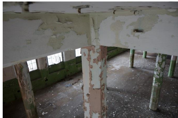
Obr. 160, Malý sál ve 2. NP (přehled ze 3. NP), zdroj: archiv autora
