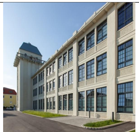
Obr. 182 Realizace přádelny bavlny Teesdorf, zdroj: https://www.altbauneu.at/
