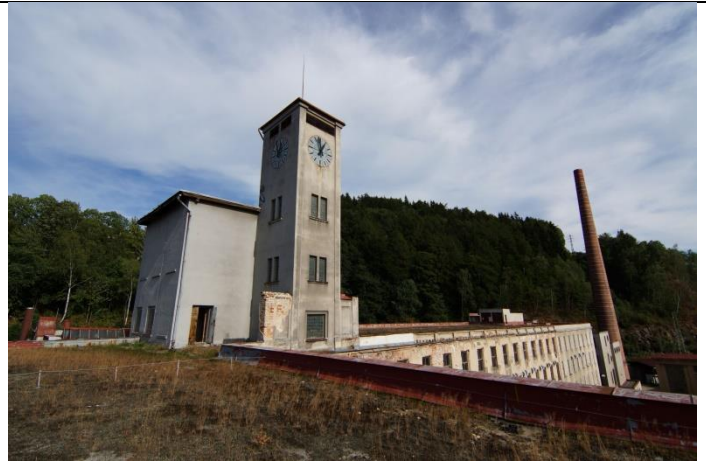
Obr. 98 Ploché střechy s prašnou a sprinklerovou věží Tanvaldské přádelny I - stav r. 2015, zdroj: archiv autora
