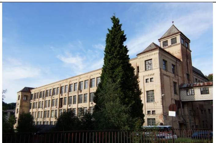
Obr. 115 JZ průčelí Tanvaldské p řádelny II, foto z r. 2015, zdroj: archiv autora
