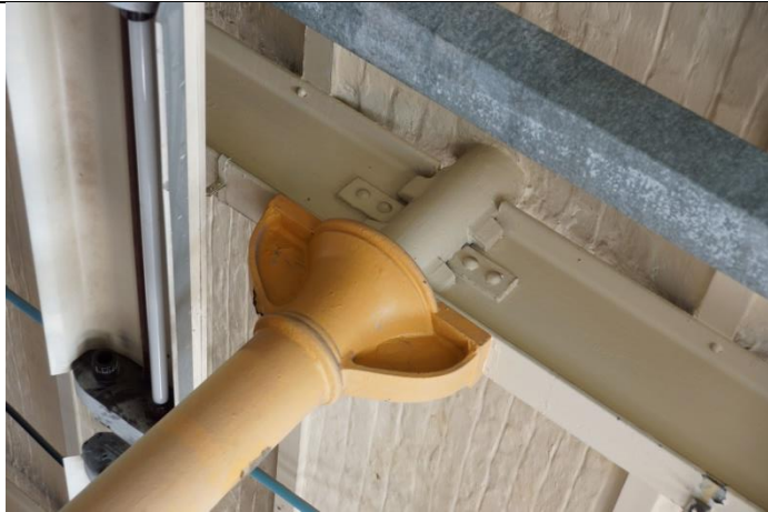
Obr. 97 Detail napojení sloupu, příčného nosníku a profilů včetně pat zděných kleneb ve 3.NP hlavního sálu (r. 2015) Tanvaldské přádelny I, zdroj: archiv autora
