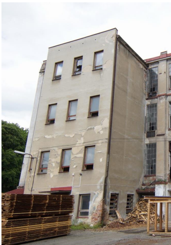
Obr. 139 Dostavba jižní věže, JZ, zdroj: archiv autora
