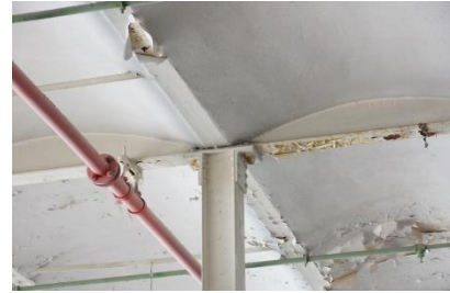
Obr. 7 Ocelový skelet II. Tanvaldské přádelny; zdroj: archiv autora 8/2015
