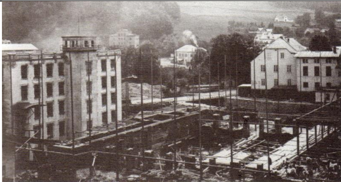
Obr. 110 Staveniště (~ r. 1907) Tanvaldské pádelny II, zdroj: Jaroslav Rýdl – Paměť Tanvaldska
