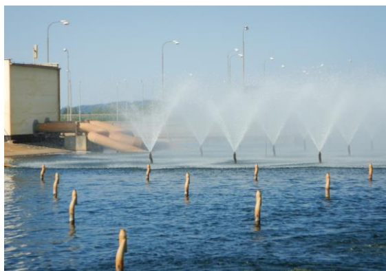
Obr. 18. Bazén rozstříku technické vody důležité za provozu při normální hladině.
