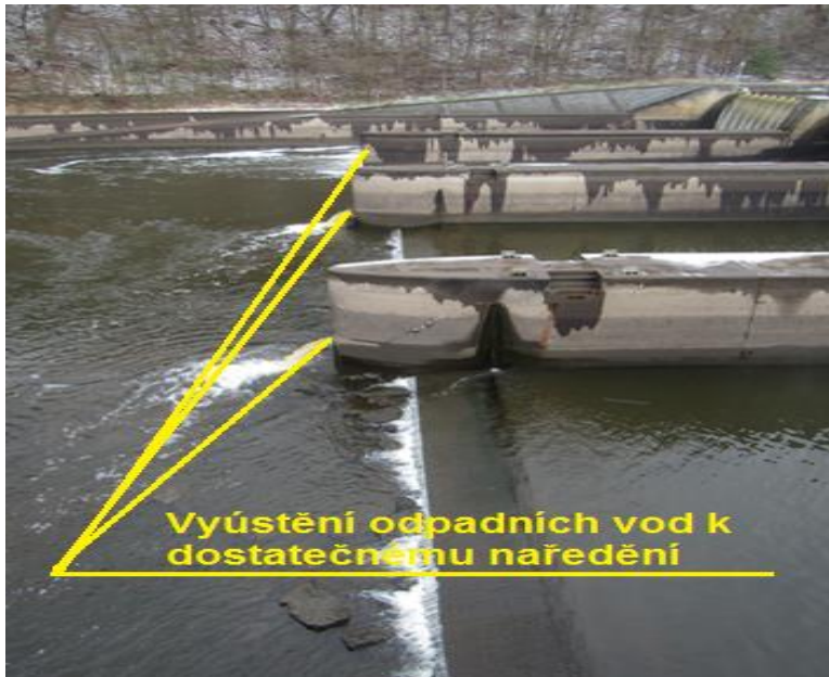
Obr. 11. Dispozice výpustí na ředění tritiových vod, foceno za extrémního snížení hladiny.
