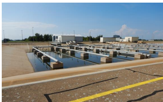
Obr.17. Bazén rozstříku technické vody důležité, ve vypuštěném stavu.
