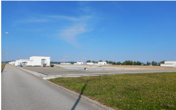
Obr. 19. Okraje bazénů rozstříku zvýšené proti úrovni servisních komunikací o cca 20 cm.
