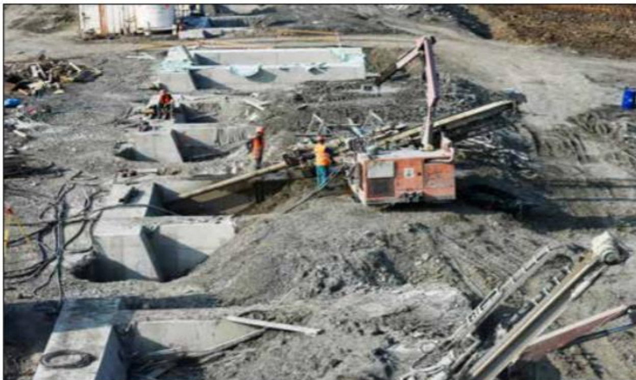
Obr. 11. Vrtání pramencových kotev u studen [38].
