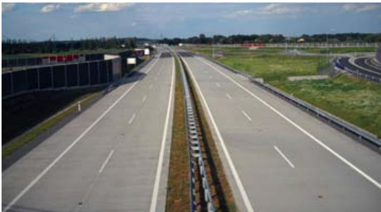
Obr. 20. Fotografie úseku dálnice mezi Bohumínem a hranicí do Polska [47].
