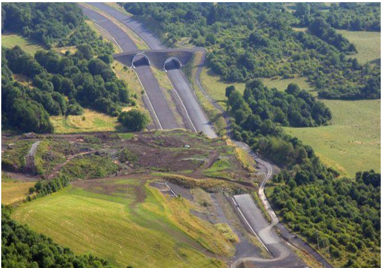
Obr. 7. Sesuv svahu na D8 [36].
