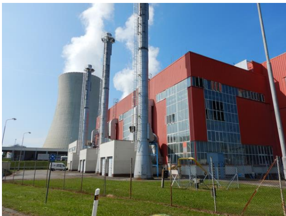
Obr. 20. Plynová kotelná s 5 kotli.
