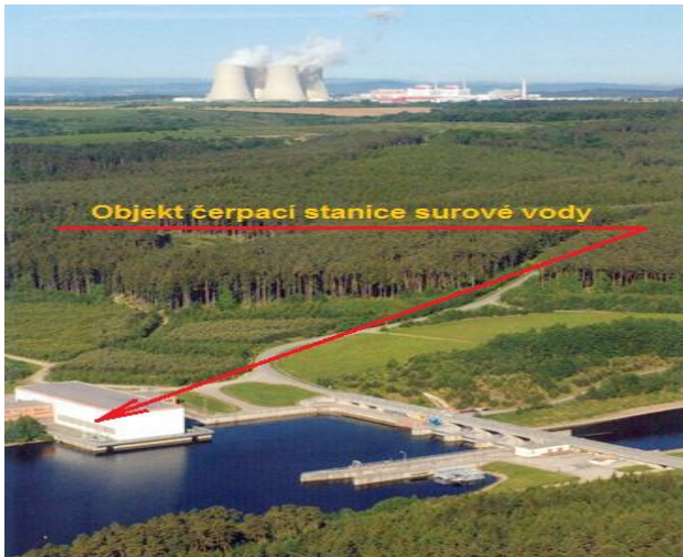
Obr. 8. Vodní dílo Hněvkovice v kontextu JE Temelín; vlevo čerpací stanice surové vody, vpravo dole zdi zdymadla [15].
