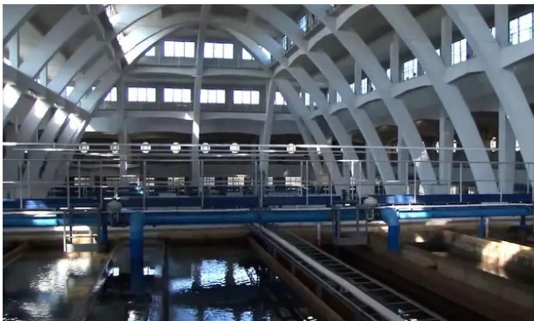
Obr. 10. Podolská vodárna, nově rekonstruovaná hala filtrů [16].
