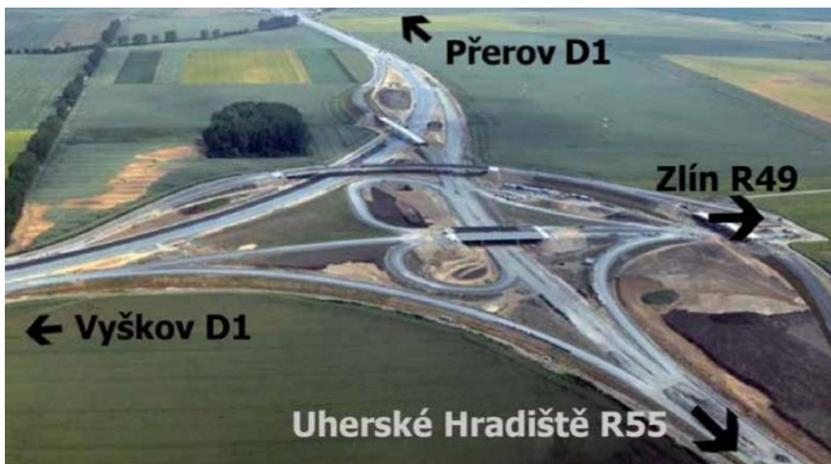
Obr. 19. Moravská křižovatka – stavba [49].
