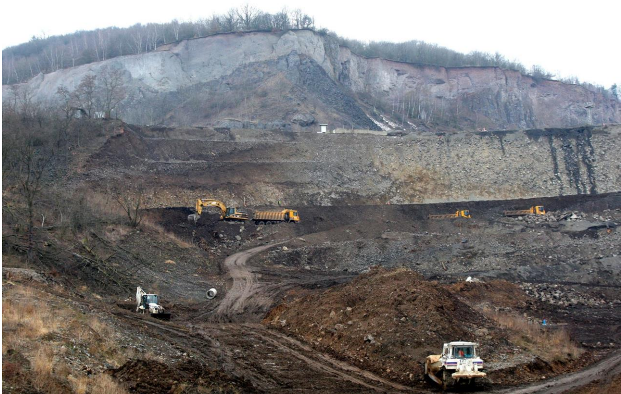
Obr. 11. Odstraňování zeminy po sesuvu [36].
