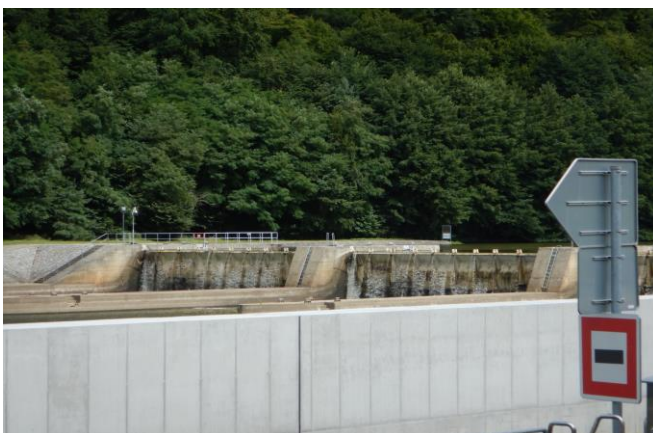
Obr. 9. Pohled na hydraulicky stavitelné tabule jezu vodního díla Kořensko, ze stěny zdymadla.
