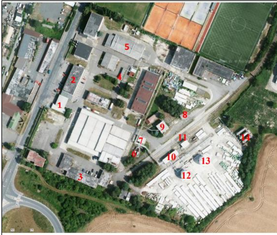
Obr.7 – Zařízení a budovy objektu Plnírna Satalice [31]
