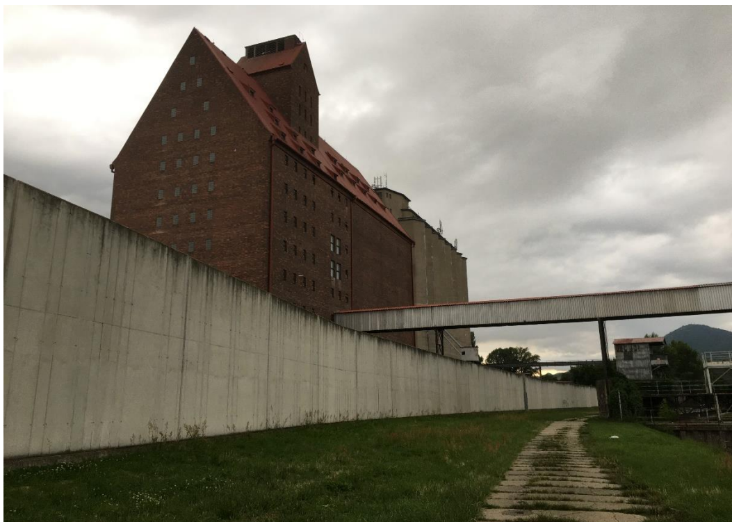
Obr. 17 – Protipovodňová zeď areálu Lovochemie a dvě zásobní sila (vlastní fotografie)
