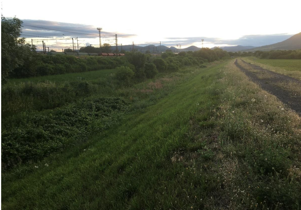
Obr. 24 – Protipovodňový val podél Modli (vlastní fotografie)
