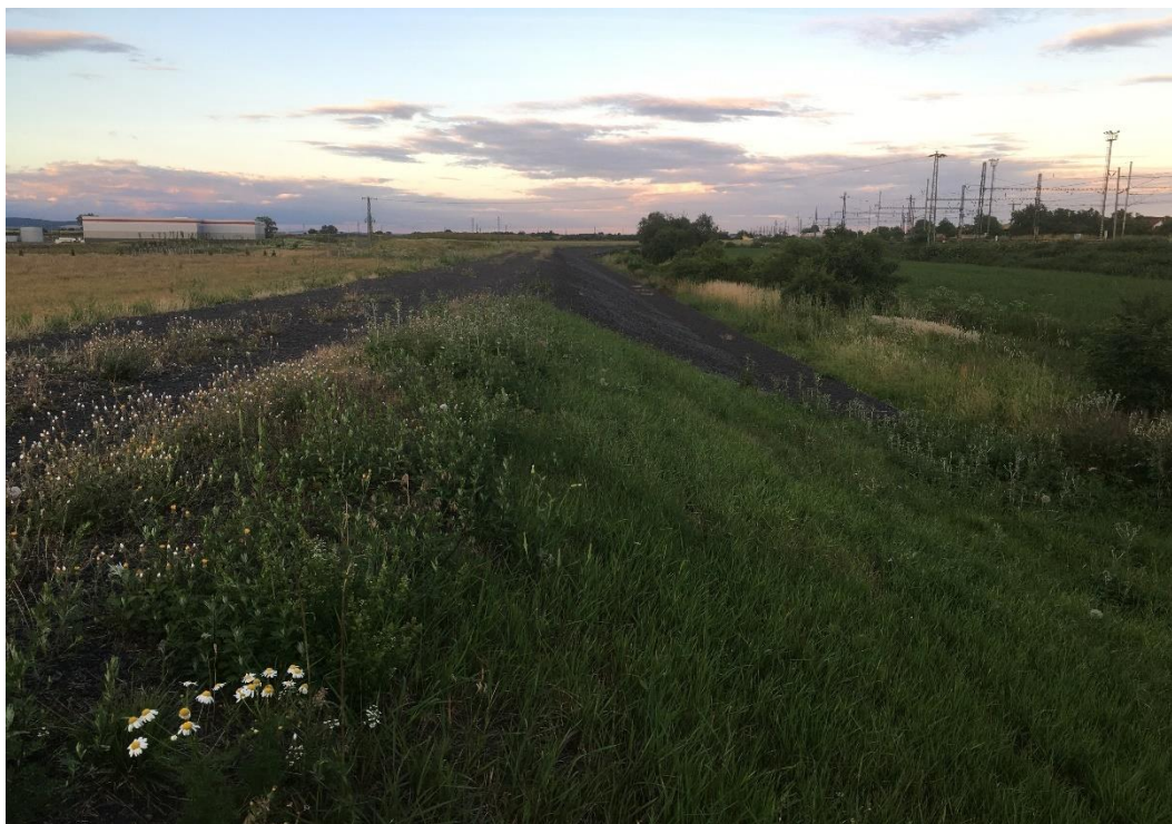
Obr. 28 – Přejchod ochranného valu do ochranné hráze (vlastní fotografie)
