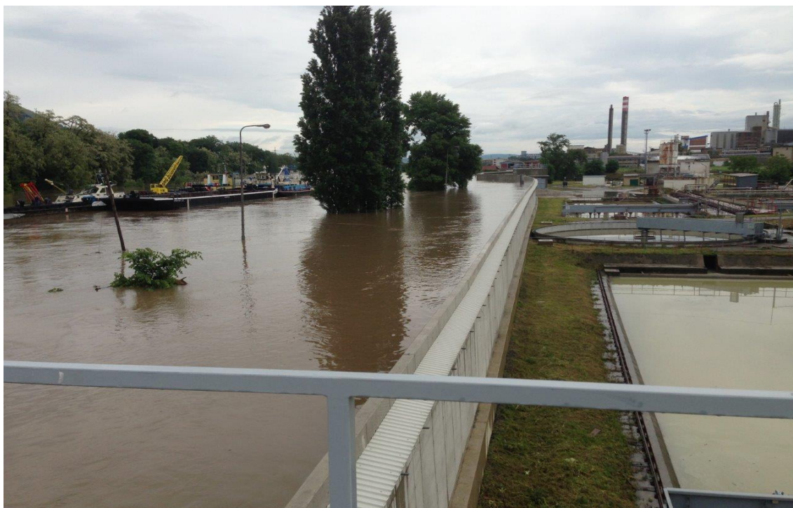
Obr. 32 – Povodeň 2013 Lovochemie (Fotografie získaná od zaměstnance Lovochemie)
