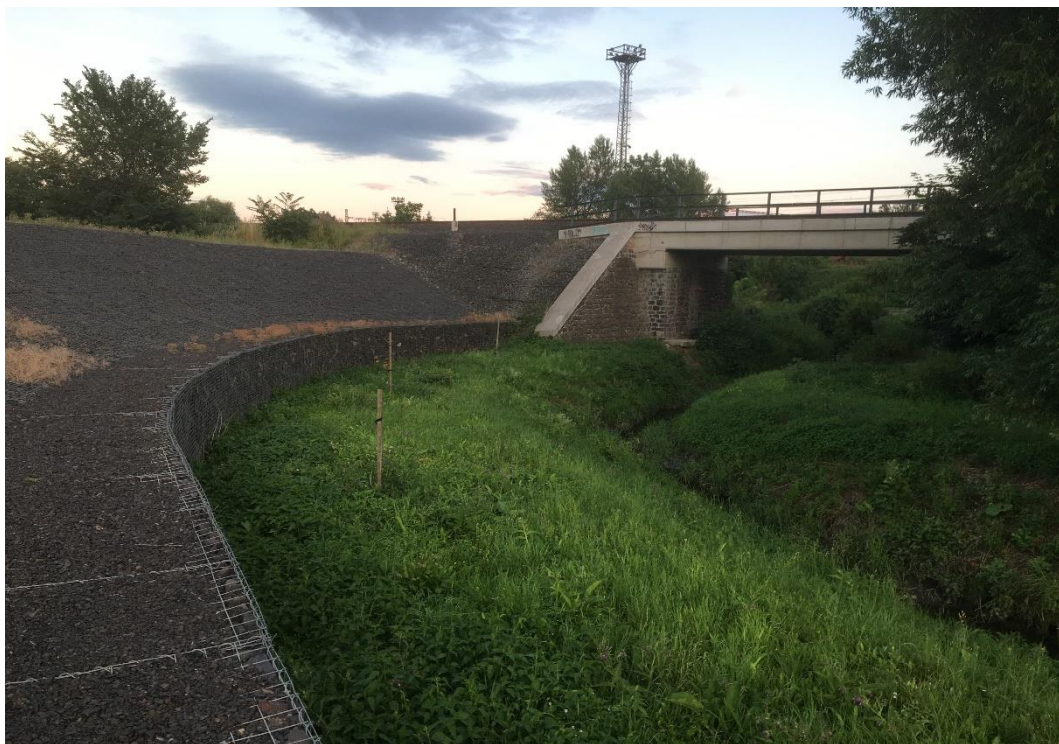
Obr. 23 – Ochranná hráz se železničním mostem (vlastní fotografie)
