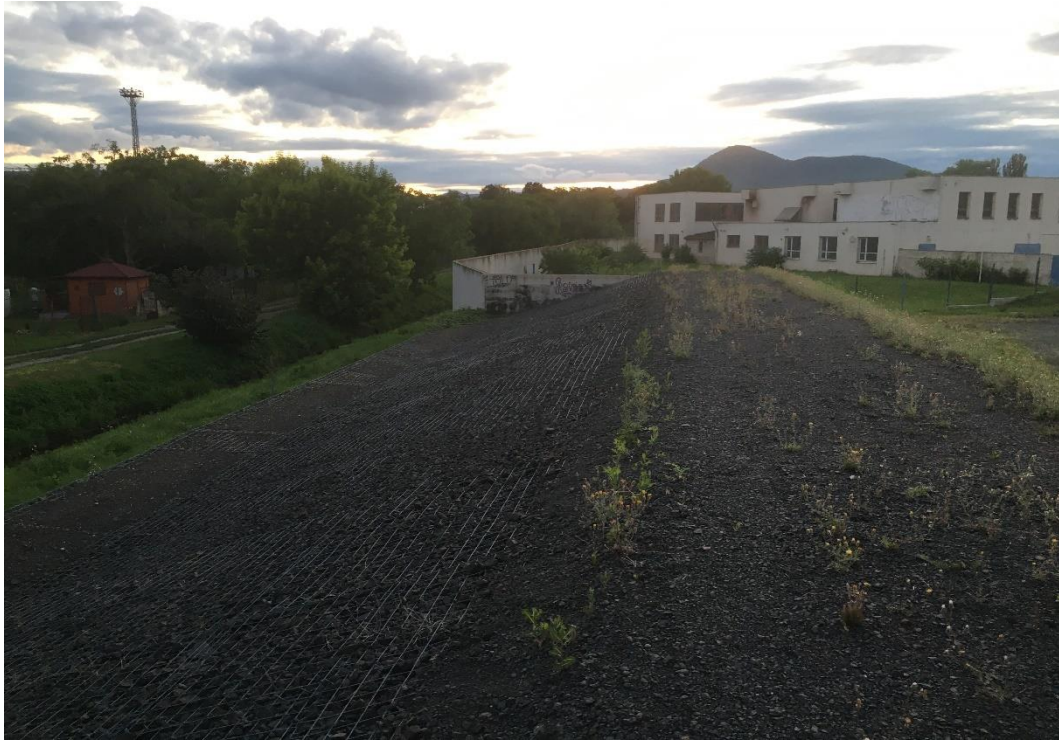
Obr. 22 – Přechod protipovodňové zdi do ochranného hráze (vlastní fotografie)
