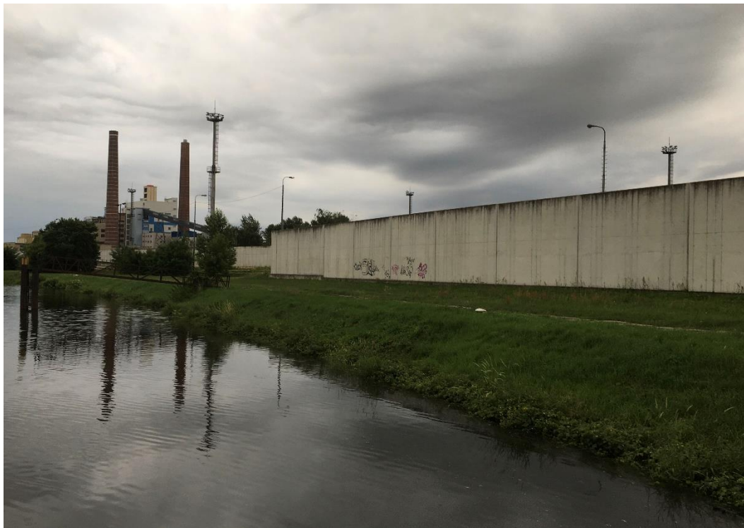
Obr. 16 – Protipovodňová zeď areálu Lovochemie (vlastní fotografie)
