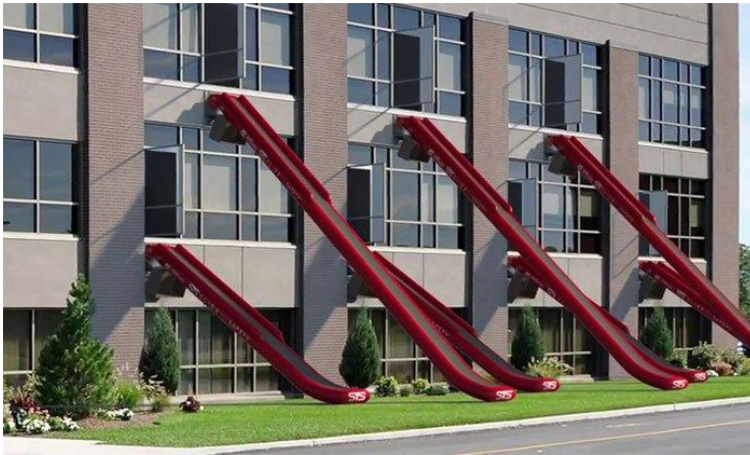
Obrázok 10 Modulárny evakuačný systém (zdroj: https://www.startupsselfie.net/2018/12/06/slide-to-safety-rapid-evacuation-system/ )
