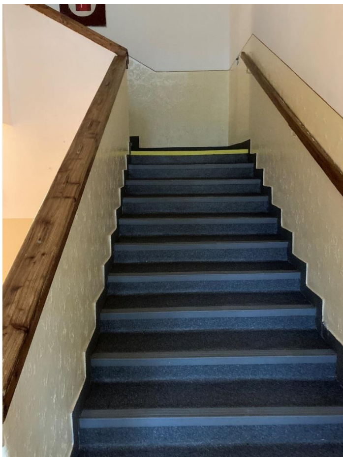
Obrázok 8 schodisko vo vedľajšej budove (zdroj: vlastný)
